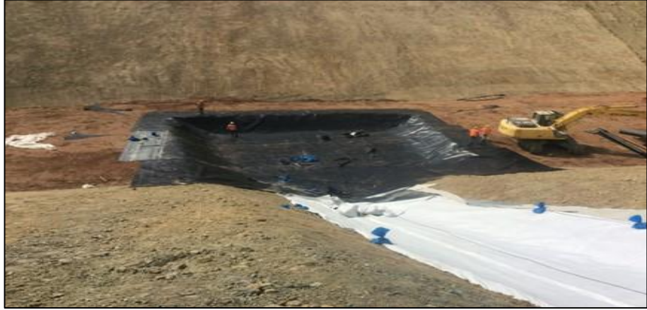
Şekil 3.17. Üst drenaj toplama havuzu jeomembran kaplama işlemi
