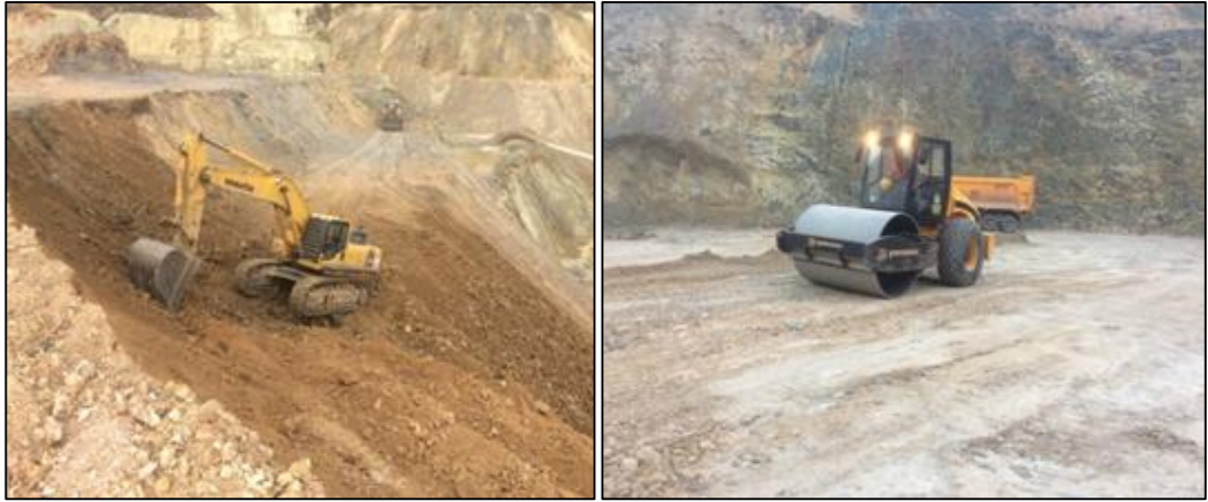
Şekil 3.3. Şev yüzeyi hazırlama ve sıkışma
