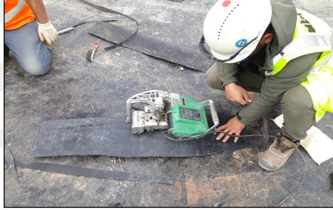
Şekil 4.9. Tecrübe kaynağı numunesinin hazırlanışı
