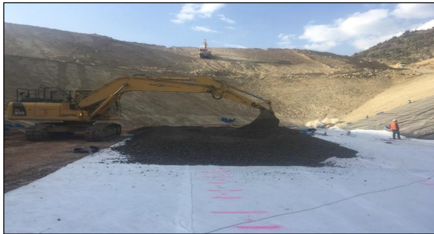
Şekil 3.9. Üst drenaj çakılı
