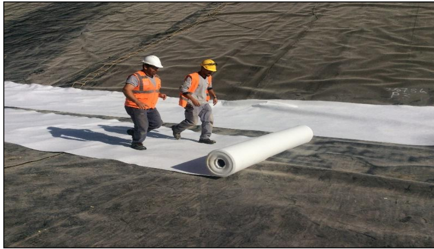
Şekil 3.24. Tabanda Jeotekstil serimi
