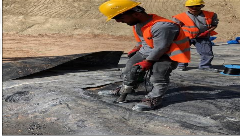
Şekil 4.5. Ekstrüzyon kaynağı
