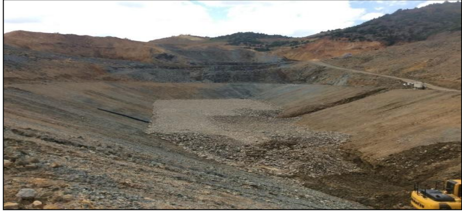
Şekil 3.7. Alt drenaj çakılı
