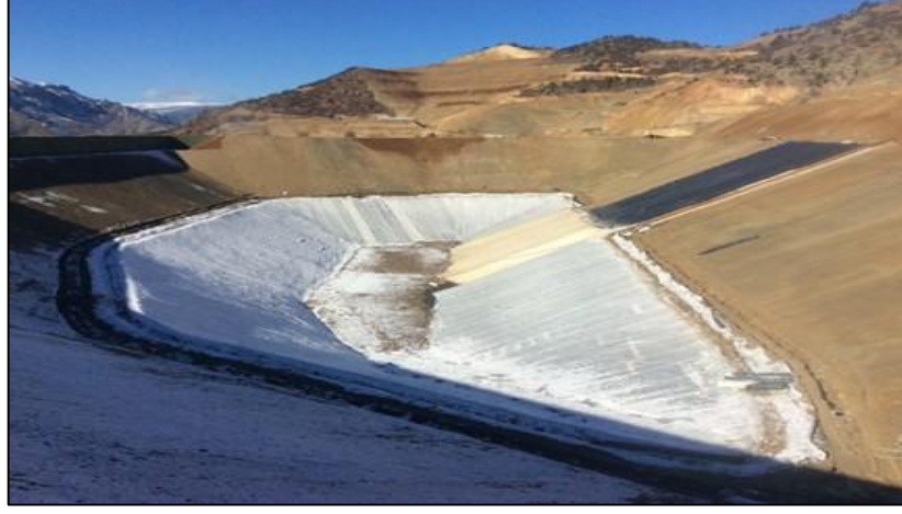
Şekil 3.23. Jeokompozit serimi tamamlanmış alan
