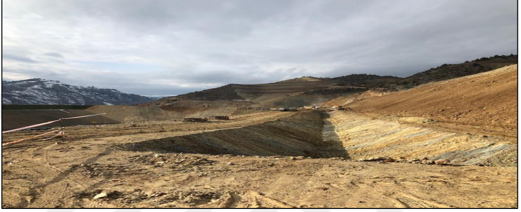
Şekil 3.27. Kuşaklama kanalı yapılışı
