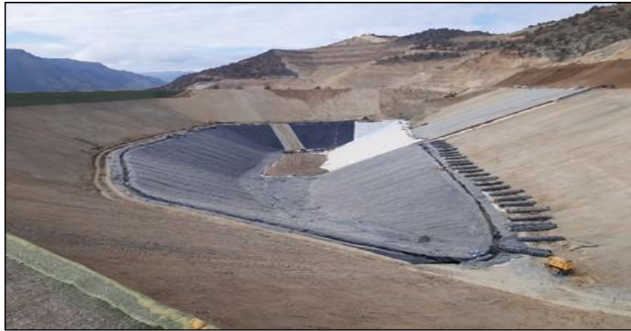
Şekil 3.20. Jeomembran kaplama işlemi Genel görünümü
