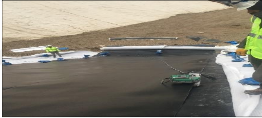
Şekil 3.19. Jeomembran sıcak füzyon kaynağı işlemi
