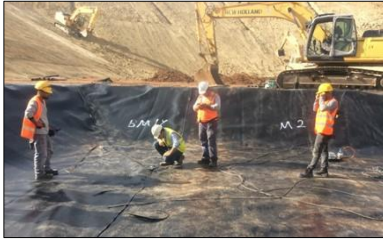
Şekil 4.6. Hava testi yapılacak yer
