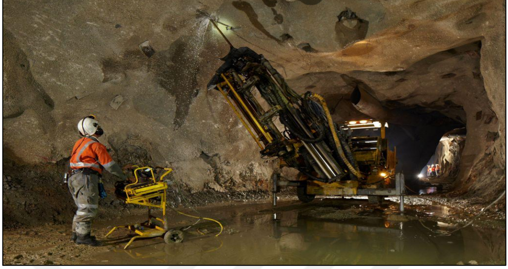
Şekil 2.3. Tüprak metal madencilik yeraltı işletmesi (Anonim 2018)
