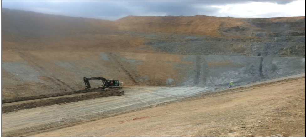
Şekil 3.4. Drenaj kanal kazısı
