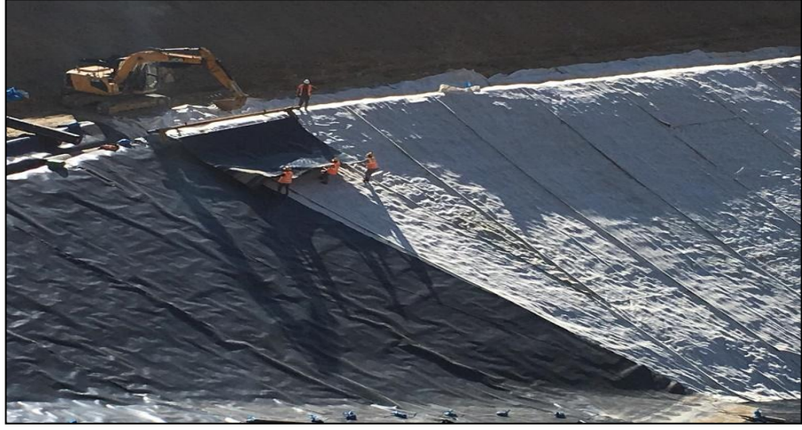
Şekil 3.18. Şev yüzeyinde jeomembran kaplama işlemi
