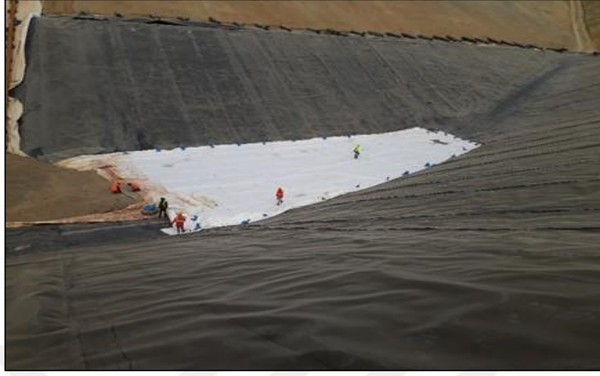
Şekil 3.25. Jeotekstil serimi tamamlanmış alan
