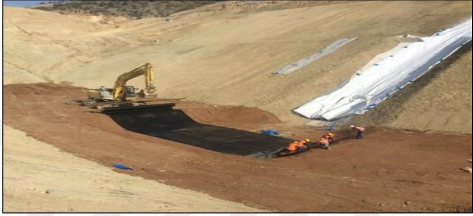
Şekil 3.16. Taban yüzeyinde jeomembran serim işlemi
