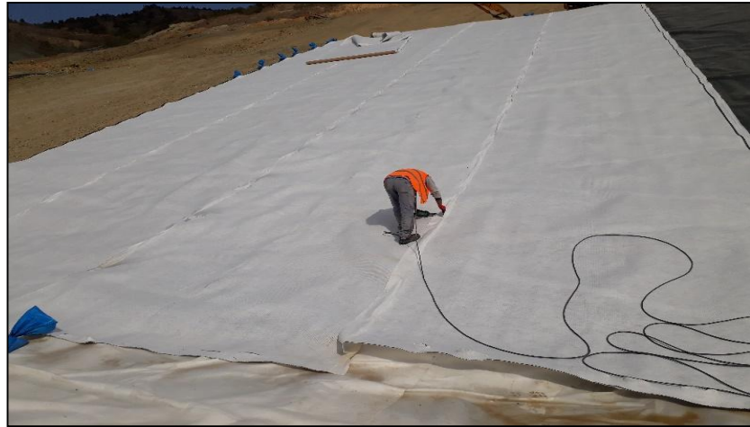
Şekil 3.22. Jeokompozit serimi
