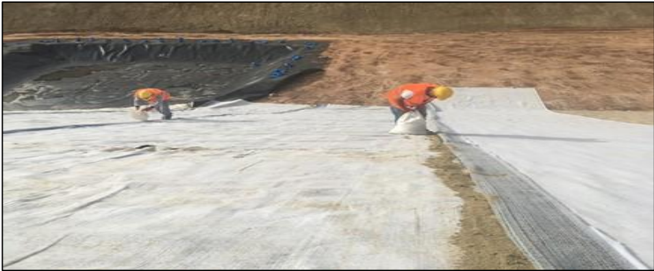
Şekil 3.14. Toz bentonit uygulaması
