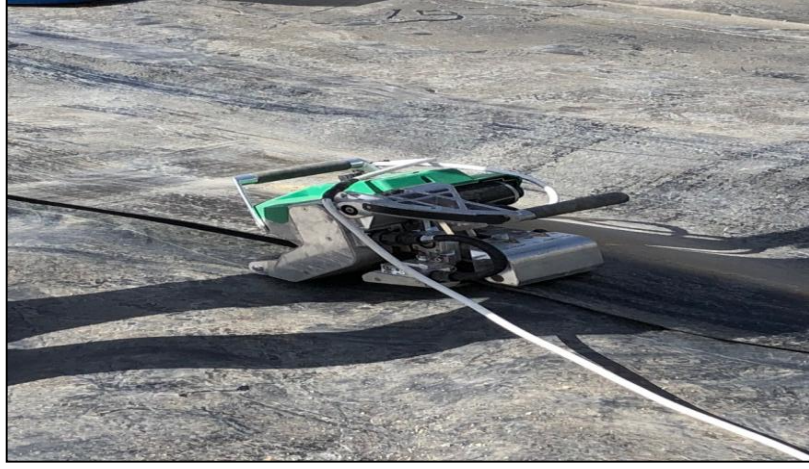
Şekil 4.4. Füzyon kaynak makinası
