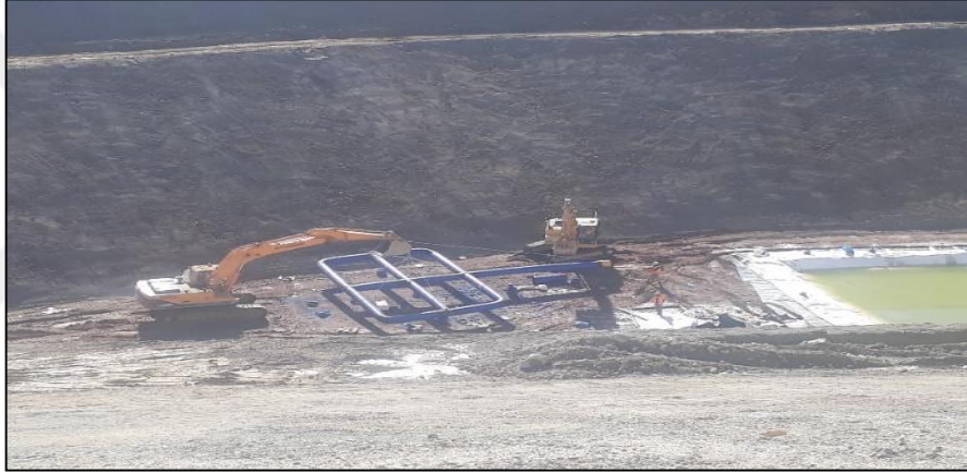
Şekil 3.8. Üst drenaj HDPE boruları
