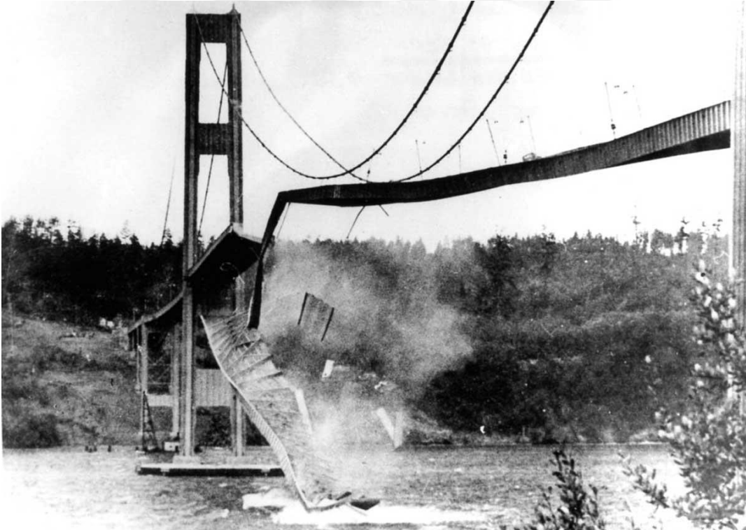
Şekil 20. Tacoma Narrows Köprüsü'nün rüzgâr etkisi altında aldığı hasardan bir görüntü. (URL-11, 2019)
