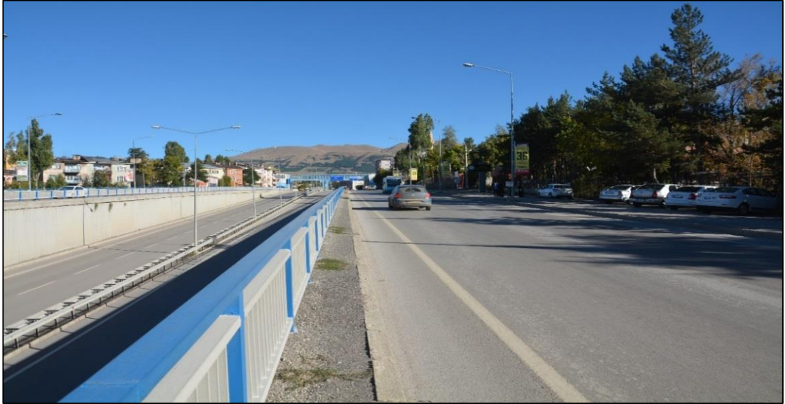
Şekil 3.10. Koridor 5 (K-5)'den bir görünüm (ATÜ.-Palandöken Kavşağı)
