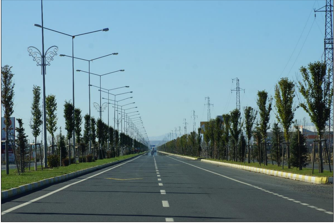
Şekil 3.3. Koridor 1 (K-1) görünüm (doğu'dan batı'ya bakış)
