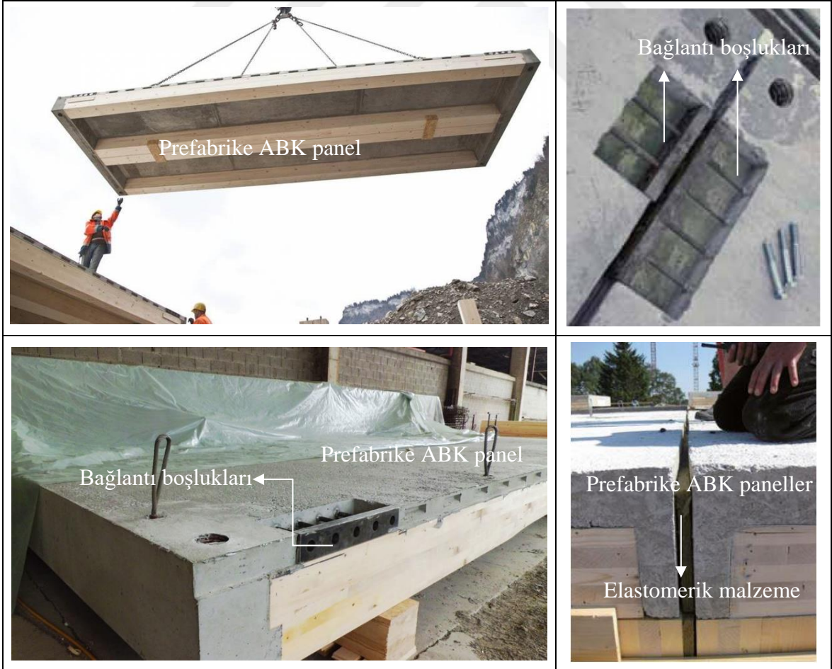
Şekil 57. Tam prefabrike yapım tekniği kullanılan uygulamalar (A) [63, URL-12 ve 13].
