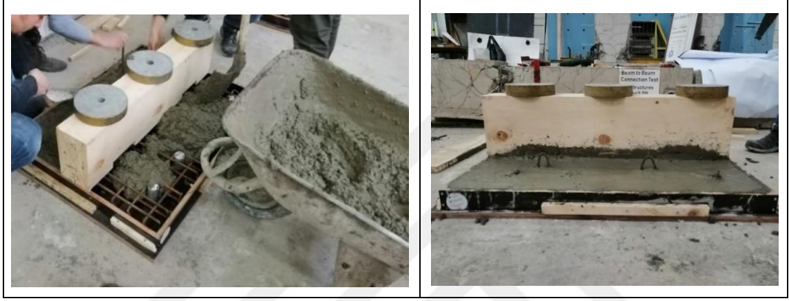
Şekil 95. Beton döküm sürecine ait görseller.
