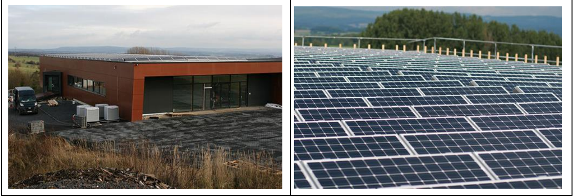
Şekil 59. Arenz Ticaret Merkezi çatısında yer alan güneş panelleri[URL-24].
