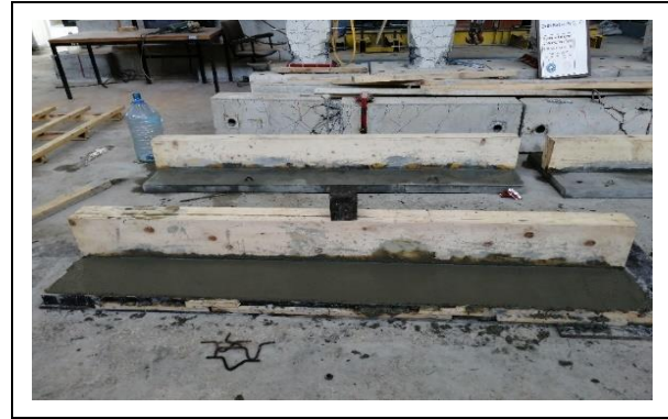
Şekil 101. Beton döküm sürecine ait görsel.
