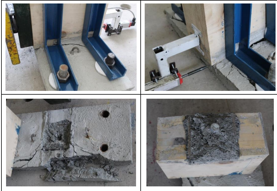
Şekil 86. O-1 deney elemanında hasar durumu.
