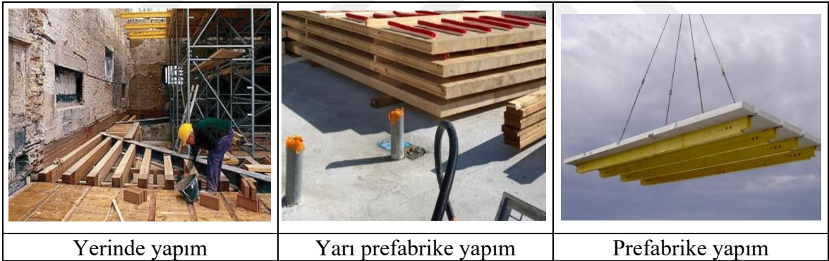
Şekil 50. ABK sistem yapım tekniklerine ait örnek uygulamalar[60, URL-7 ve 8].
