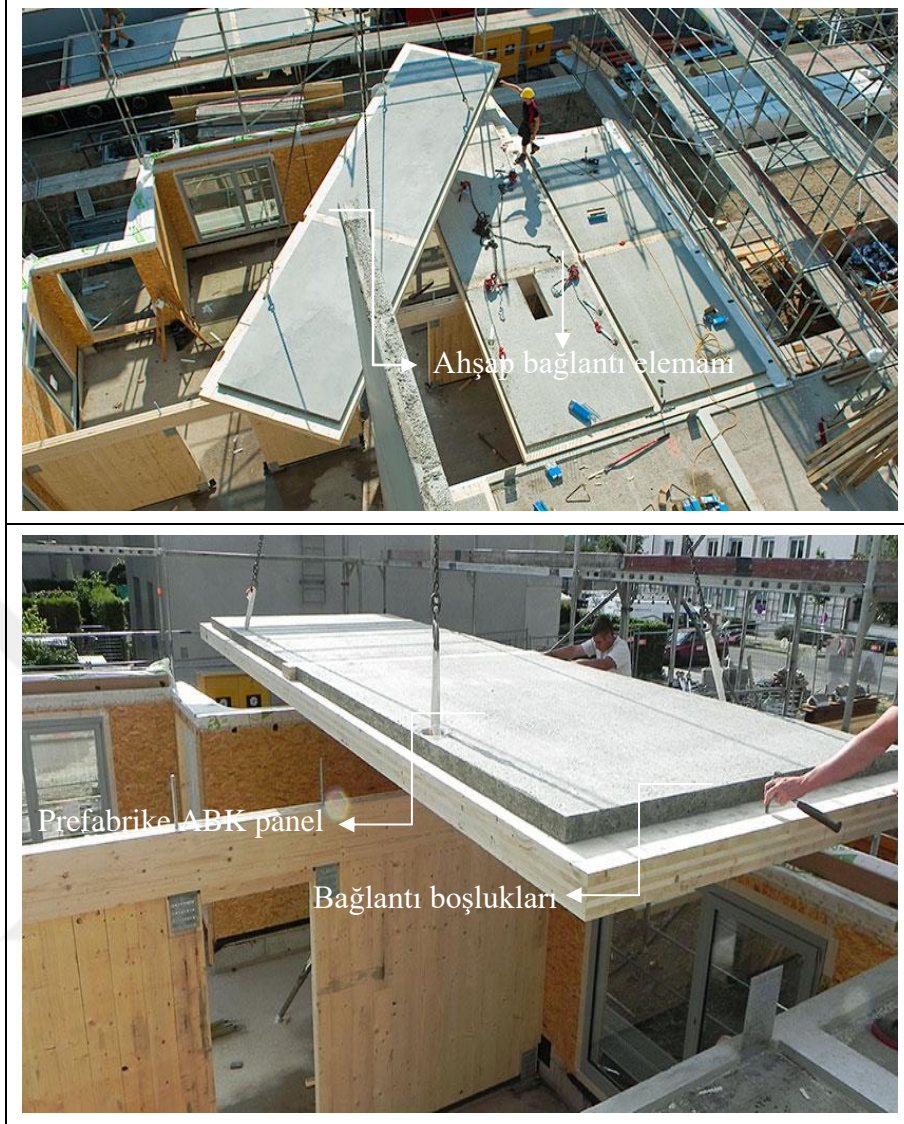
Şekil 58. Tam prefabrike yapım tekniği kullanılan uygulamalar (B) [URL-14].
