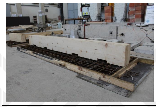
Şekil 100. Donatı çubuklarının yerleştirilmesine ait görsel.
