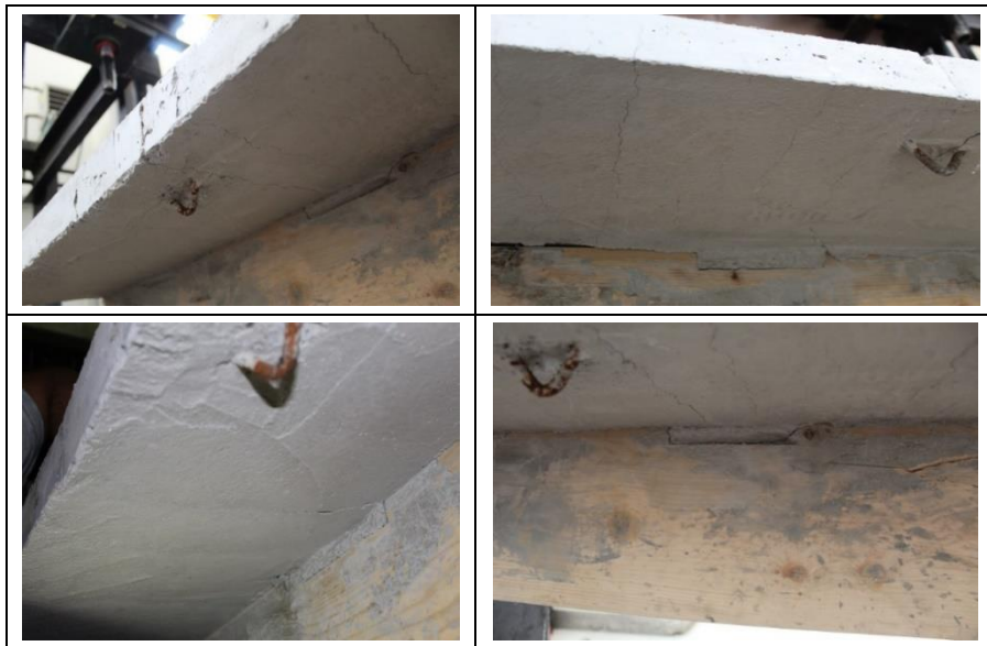
řekil 122. Deney sonunda beton plaktaki atlaklar (A-1 deney elemanı).
