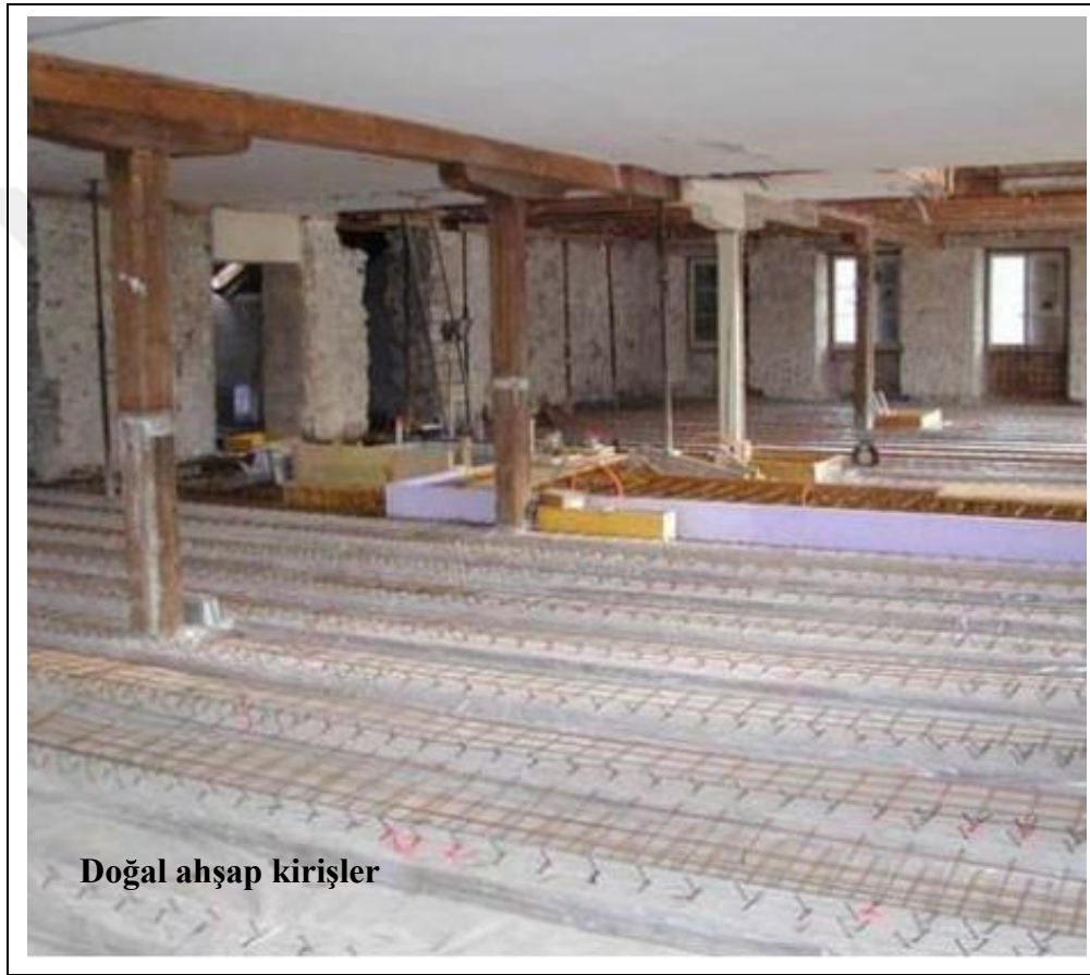
Şekil 15. SFS bağlantı elemanlarının kullanıldığı döşeme yenileme uygulaması[15].
