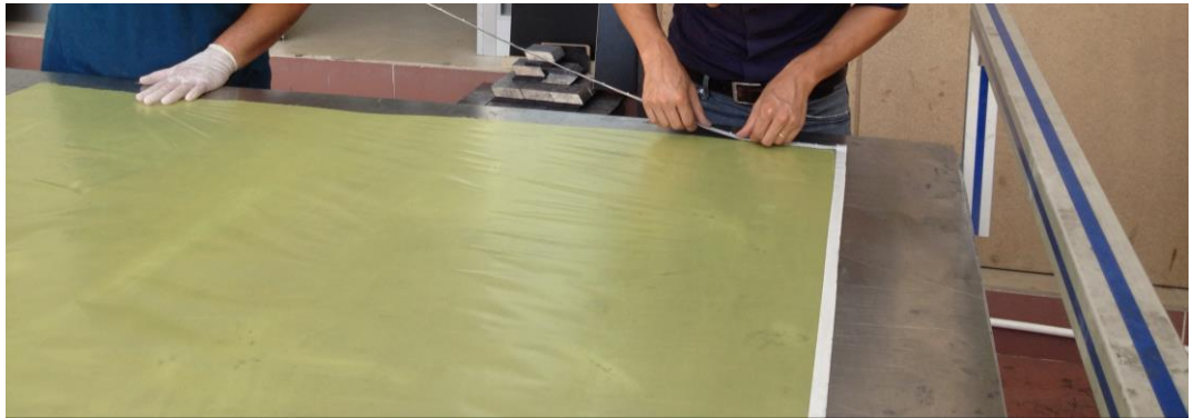
Şekil 3.7. Tezgâha sızdırmazlık poşeti serilmesi
