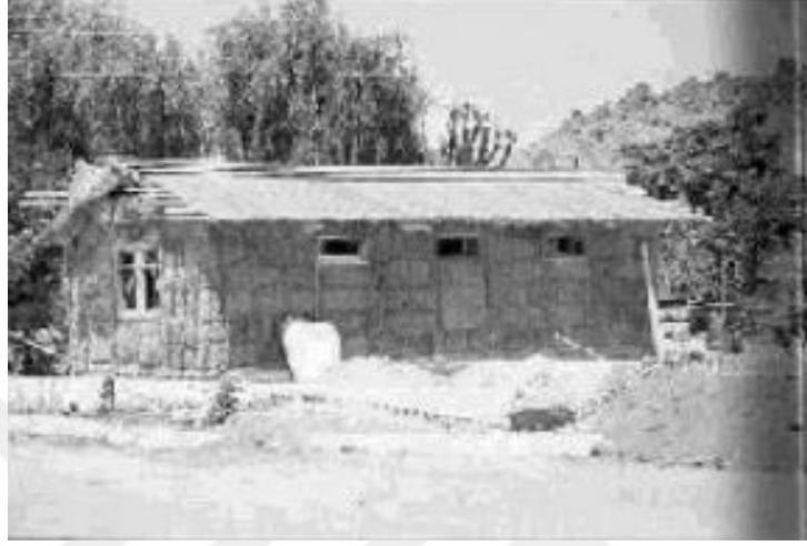
Şekil 2.10. Saman balyalarıyla ev yapım örneği (İrklı Eryıldız ve Başkaya 2007)
