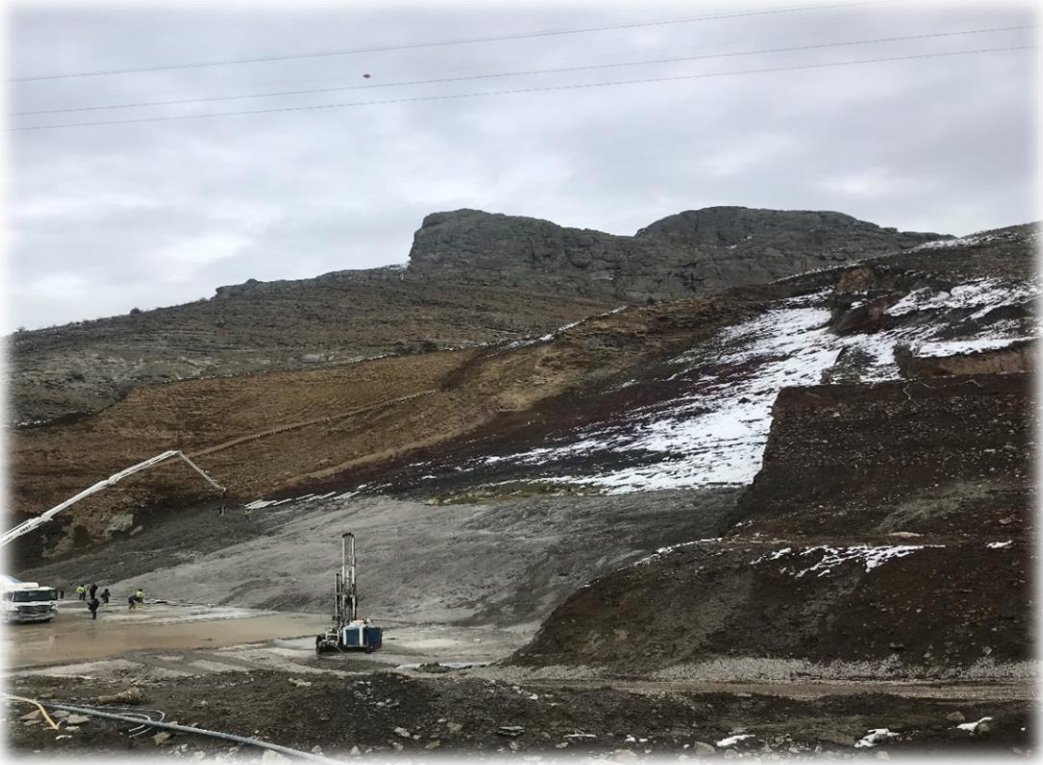
Şekil 2.5. Bahçecik Barajının gövde kısmının yapımı
