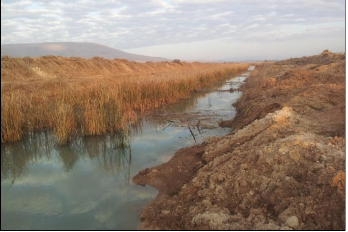
Şekil 3.10. Kışlaköy sektöründeki drenaj sularını Hurman Çayı'na ulaştırmak amacıyla inşa edilen toprak drenaj kanalının görünümü.
