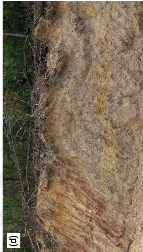
Şekil 3.4. Doğrudan kazma yönteminin uygulandığı sahalardan örnekler: (a) DEL (çamurtaşı) (b) HVL (kumtaşı) (c) GSL (silttaşı) (d) CKL (silttaşı)
