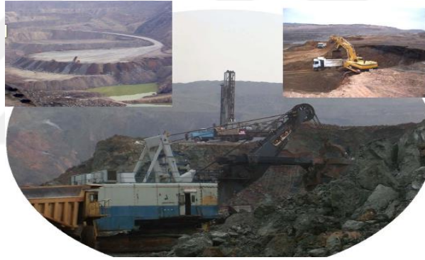
Şekil 8.ÇLI Müdürlüğü açıkocak görünüm
