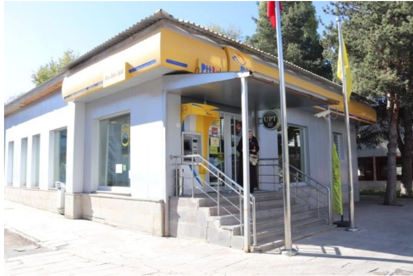
Şekil 4.33. Yerleşkede bulunan ptt
