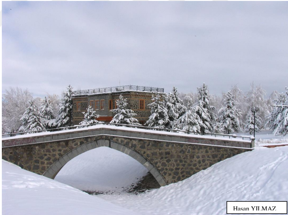
Şekil 4.24. Yerleşkede bulunan köprüden bir görüntü
