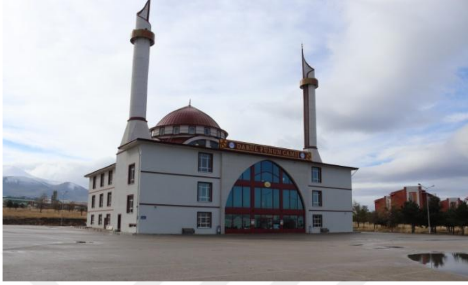
Şekil 4.32. Batı Yerleşkesinde yer alan Kalemli Camii
