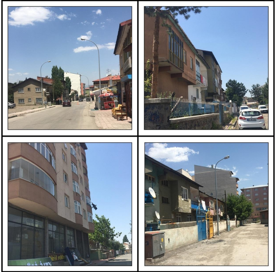
Şekil 4.24. Şükrüpaşa kentsel dönüşüm alanı yerleşim yeri görüntüleri
