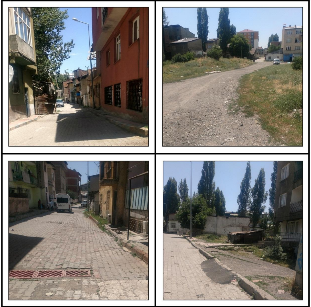
Şekil 4.12. Gölbaşı kentsel dönüşüm alanı yerleşim yeri görüntüleri
