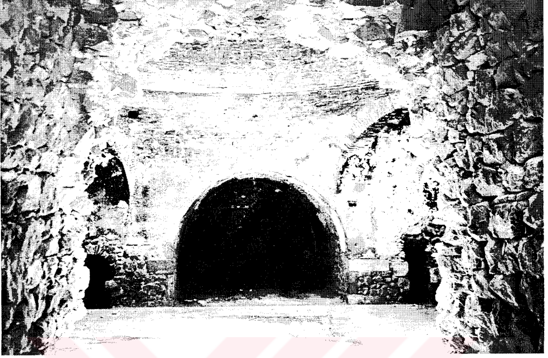
a. Tokat Yağlıbasan Medresesi, iç mekan, kubbeli birim
