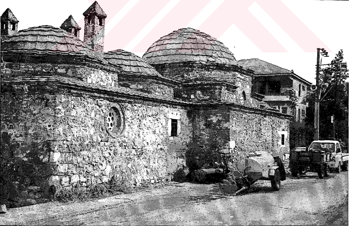
b. İznik Süleyman Paşa Medresesi, yan cephe
