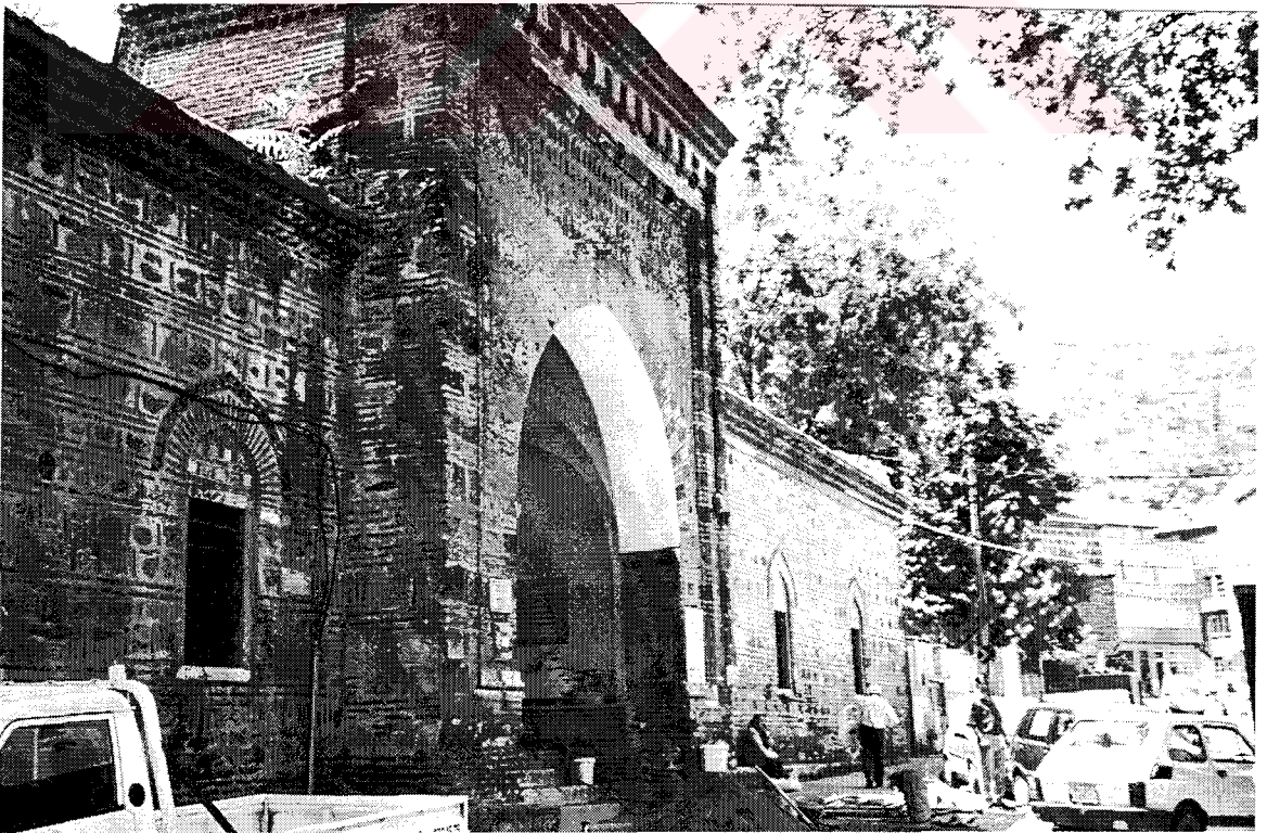
b. Bursa Muradiye Medresesi, giriş cephesi
