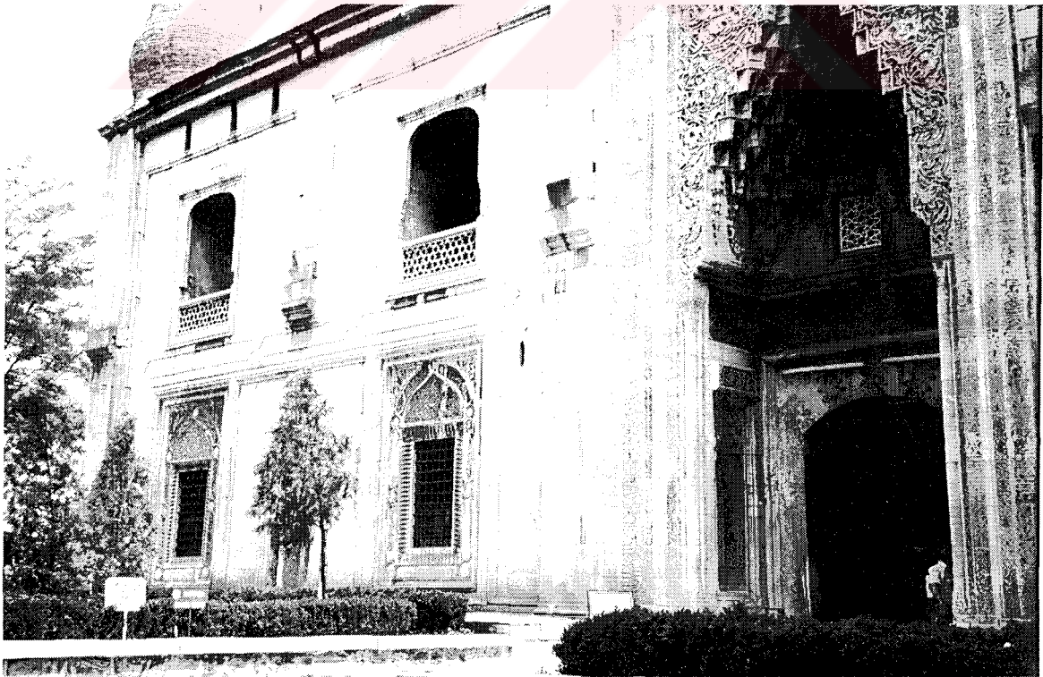
c. Bursa Yeşil Zaviye, kuzey cephesi
