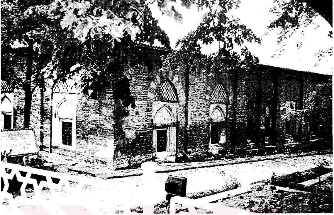
a. Bursa Yeşil Medrese, yan cephe
