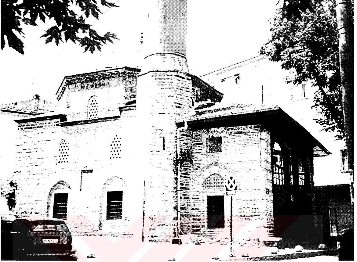
a. Bursa İbrahim Paşa Cami, genel görünüm
