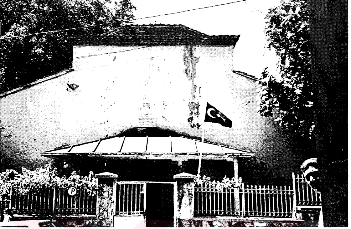
a. Bursa Lala Şahin Paşa Medresesi, kuzey cephe
