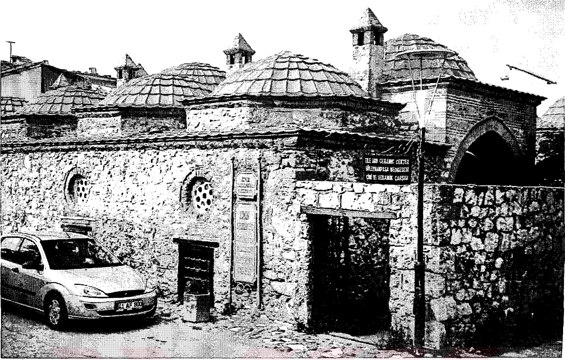
a. İznik Süleyman Paşa Medresesi, giriş cephesi
