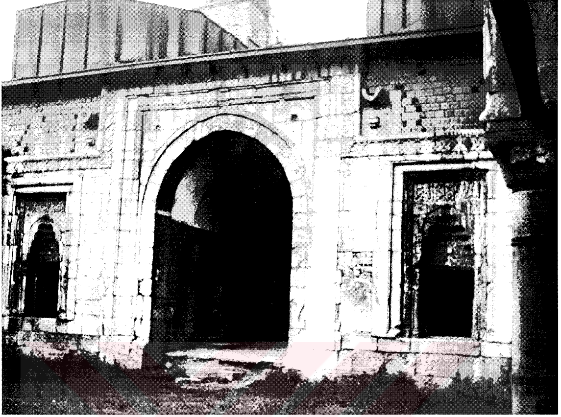
a. Sivas Gök Medrese avlu giriş duvarı penceresi
