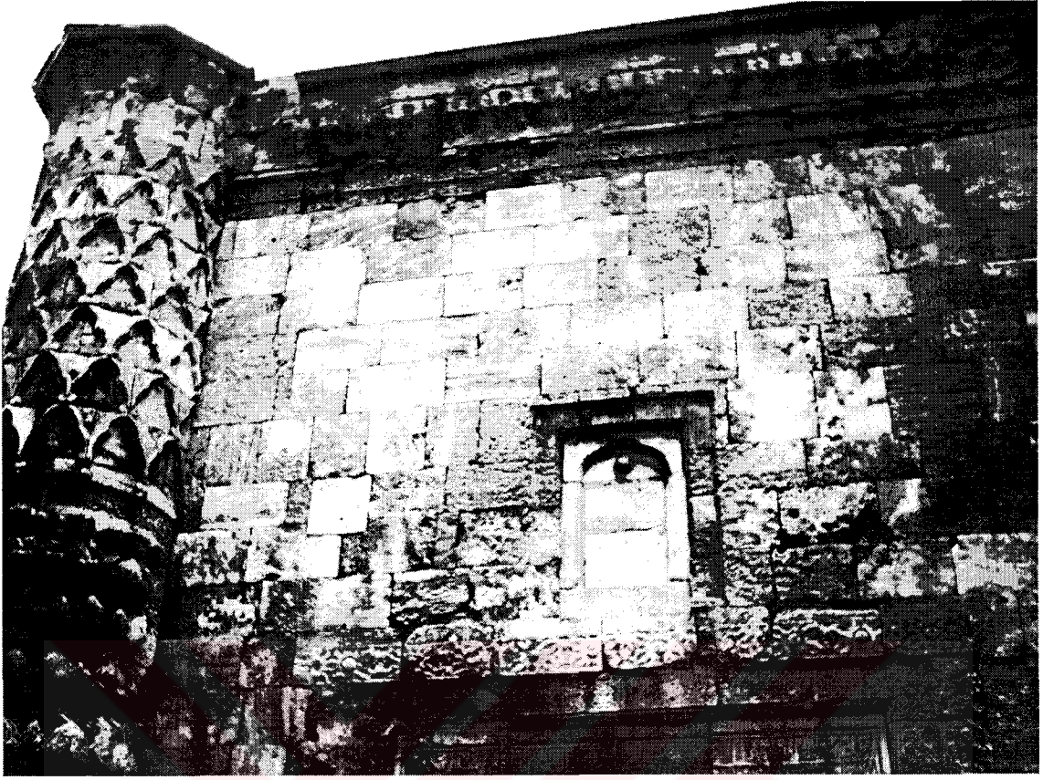
a. Sivas Gök Medrese kuzey cephe saçak
