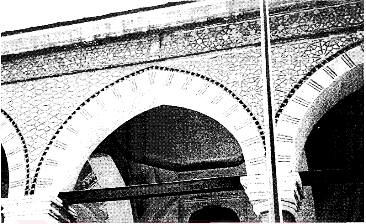
a. Bursa Muradiye Zaviyesi, revak kemerleri ayrıntı
