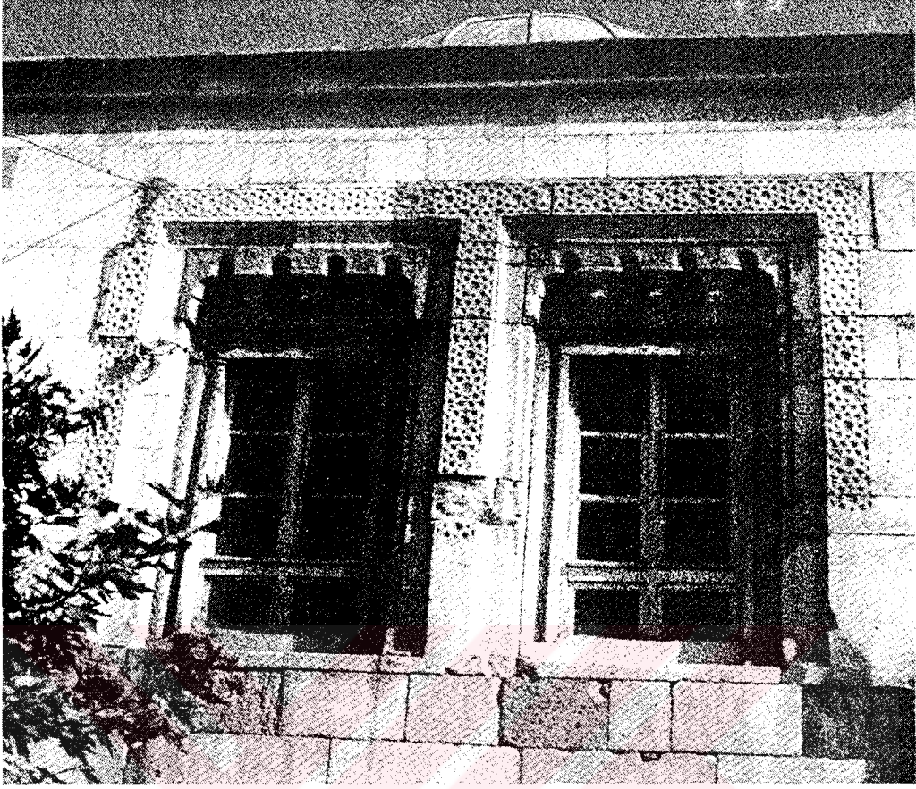
a. Çay Yusuf bin Yakub Türbesi pencereleri
