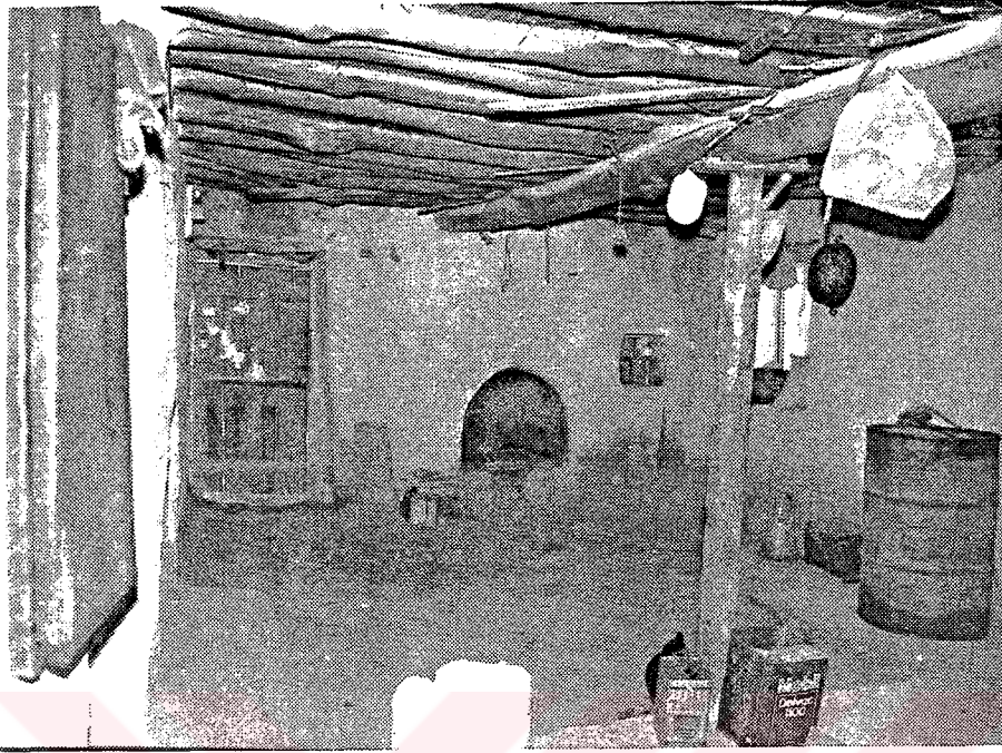
Resim 8- S. Çınar evini "dışdam" daki ocak ve tavan kirişleri ile dikme detayı.
