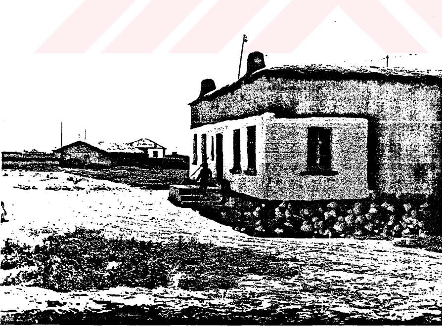
Resim 41- H. M. Boz evinin yol tarafından görünüşü.
