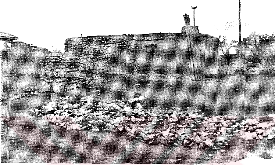
Resim 4- S. Çınar evinin güney taraftan görünüşü.
