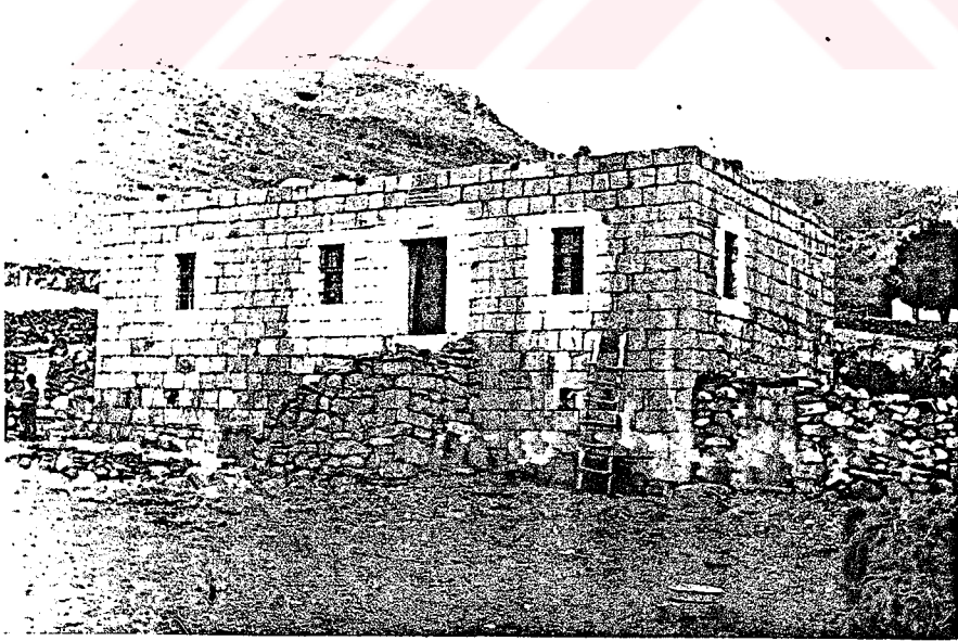
Resim 72- İ. İlaslan evinin güney tarafa bakan giriş kapısı ve pencereleri.
