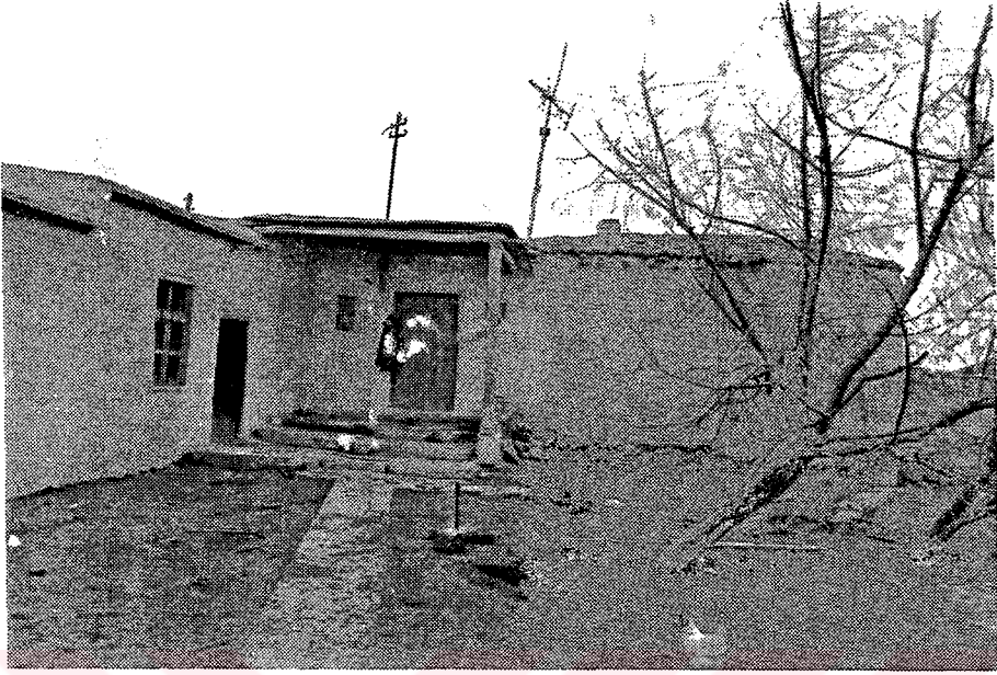
Resim 16- A. Dođan evinin avluya açılan mutfak ve evin giriş kapısı.
