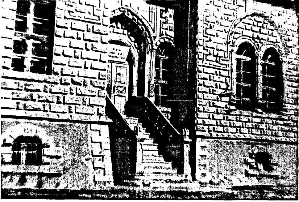
Resim 48. Cümle kapısının genel görünüsü
