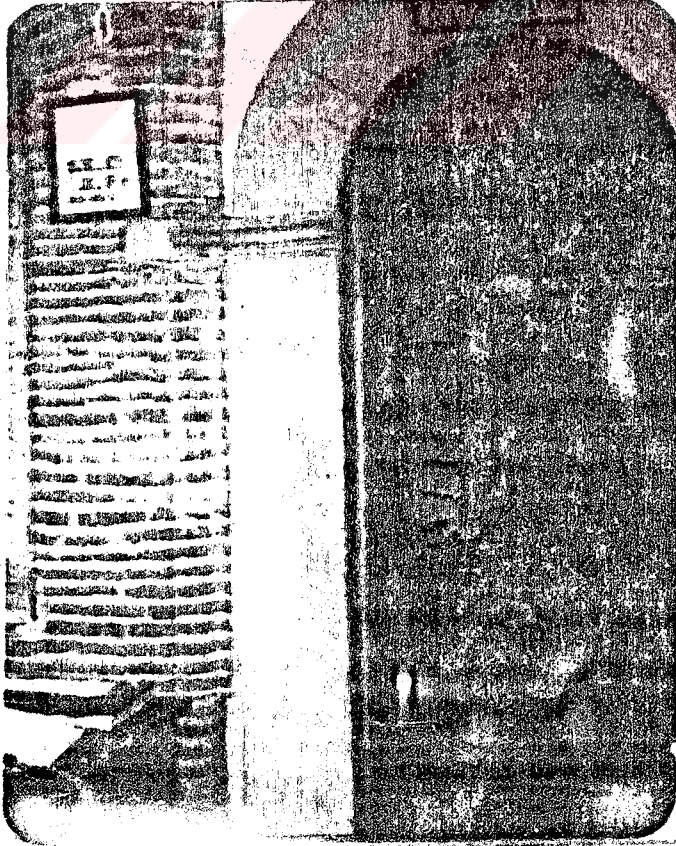
Resim 33. Giriş kapısının kenarındaki tuğla örgü
