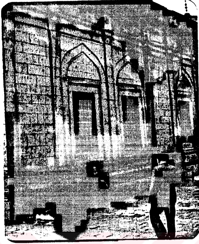
Resim 13. Geniş plasterler arasındaki pencereler
