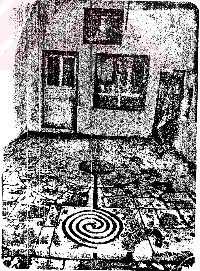
Resim 62:Köroğluzade Haydar Ağa Evi Eyvan Şadırvanının Su yolu. (Harrankapı) Yükseköğretim Kurulu Dokümantasyon Merkezi
