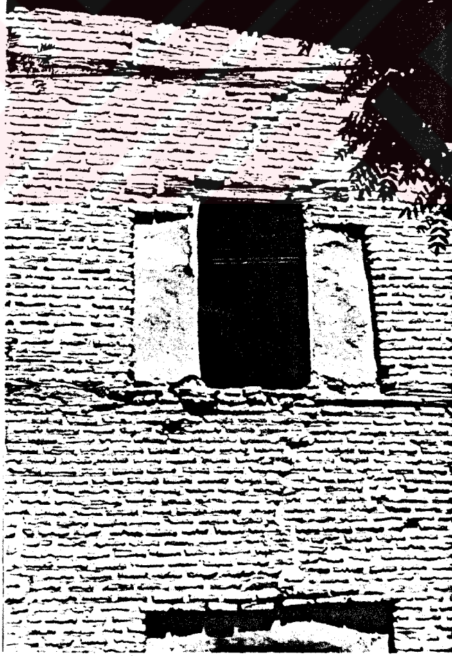
Resim 3.1.1.4.- Konya Hoca Hasan Cami Batı Duvarında üst Pencere
