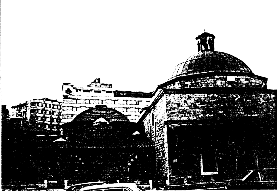
Resim 3.2.5.3- : Bursa Eski Kaplıca-Kadınlar Bölümü Girişinden Görüntü
