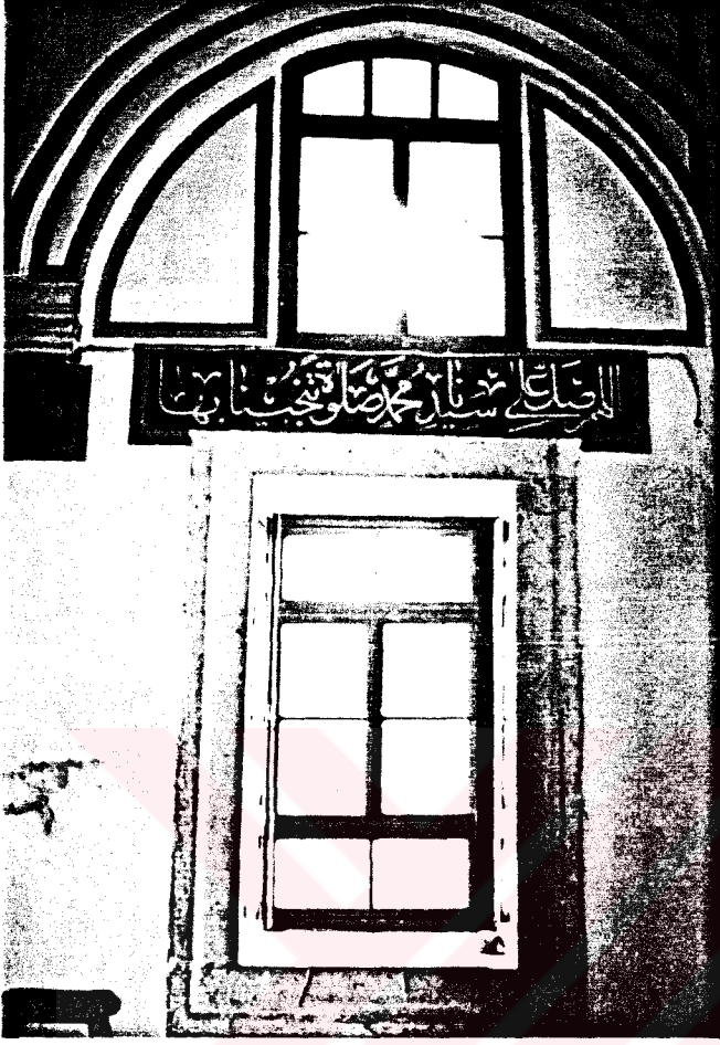
Resim 2.1.2.9. Konya Şerafeddin Cami penceresi ve pencere yuvasında ağırlık taşı.
