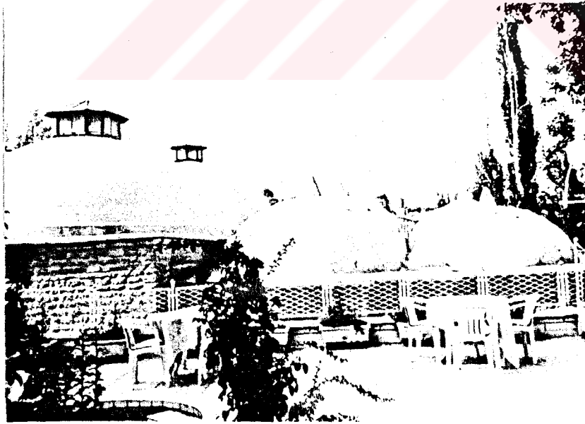
Resim 2.1.1.16.- Konya - Meram Hasbeyođlu Hamamının soyunmalık kısmı aydınlık feneri ve diđer bölümlerin aydınlatma gözleri görülmektedir.
