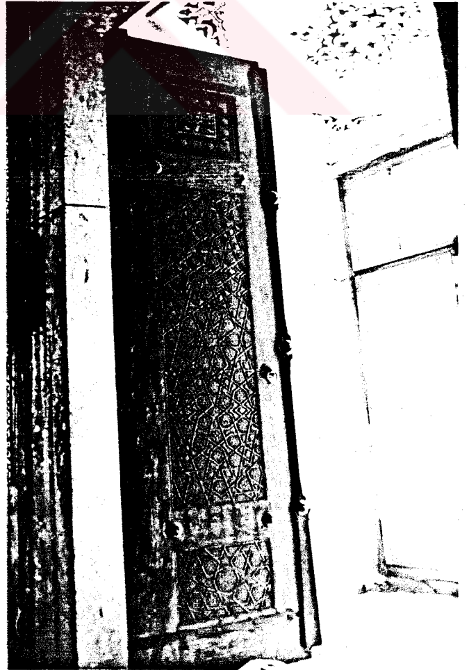
Resim.3.2.1.8- : İstanbul Süleymaniye Cami Mihrabın Sağındaki Pencere Ka- ğızının Alt ve Üst Metal Kuşakları Görülmektedir.
