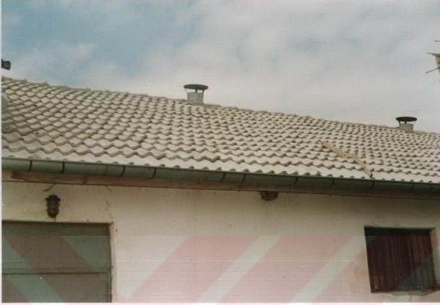
Şekil 4.11. Mahyaya yerleştirilen havalandırma bacalarının görünüşü
