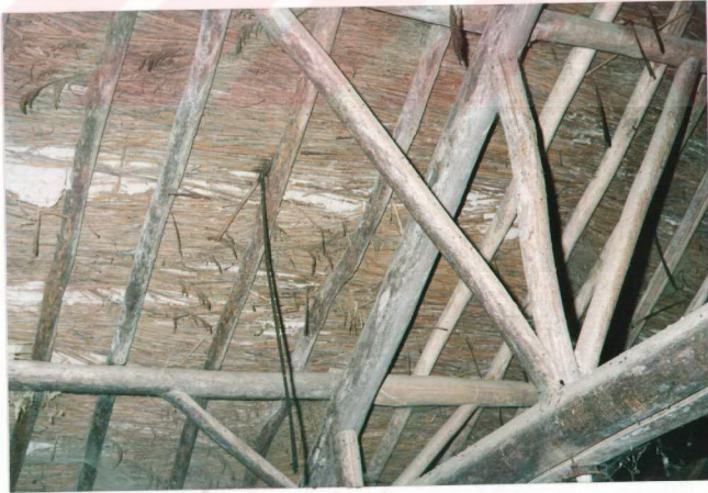
Şekil 4.4. Ahşap bir çatıda kamyş kaplama malzemesinin görünüşü
