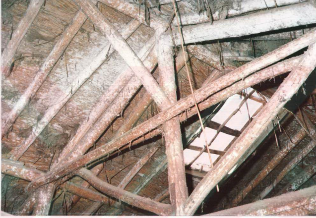
Şekil 4.7. Çatıya yerleştirilen bir barnak penceresinin içten görünüşü
