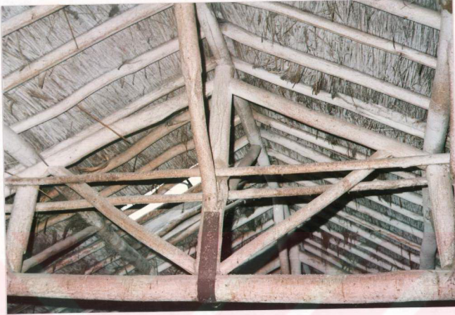
Şekil 4.3. Ahşap çatı makası elemanlarının görünüşü
