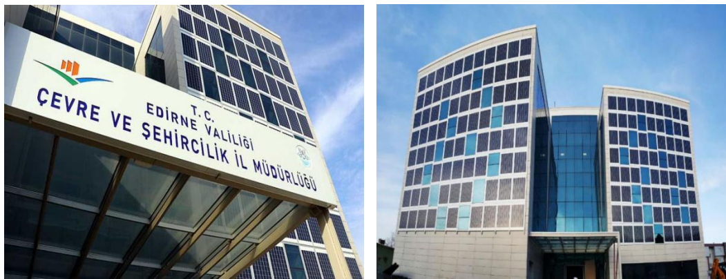
Şekil 2.7. Ülkemizde dış cephesinde fotovoltaik paneller yerleştirilen bir kamu binası
