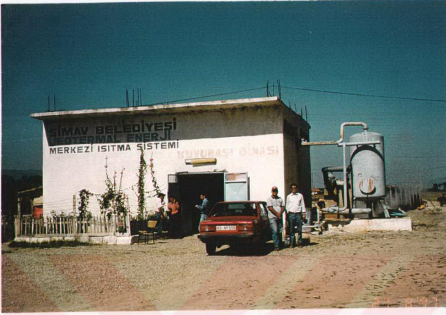
Şekil 5.48. EJ- 2 sıcaksu sondaj kuyusu ve merkezi ısıtma sistemi kuyu başı binası.
