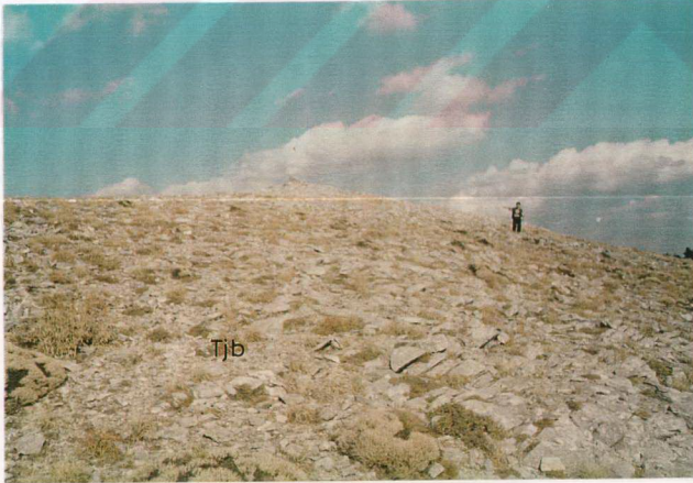
Şekil 5.45. Kırkaya Tepe'deki 2. Hazne kayayı oluşturan kırıklı ve eklemli Budağan kireçtaşlarından (Tjb) bir görünüm.
