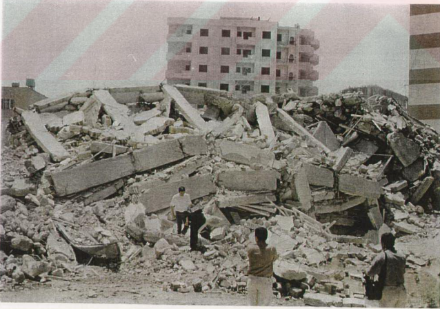
Şekil 1.5. Kolon-kiriş birleşim bölgesi hasarı sonucu yıkılmış bina(Adana 1998)
