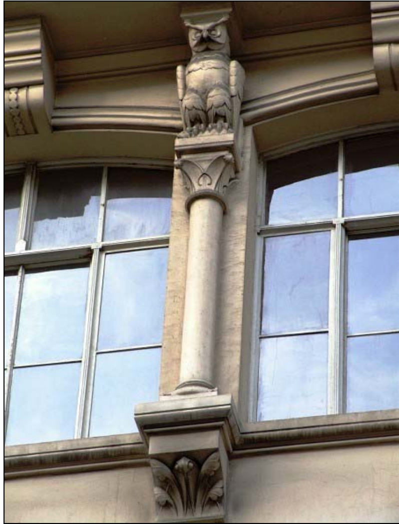
Resim 34. Condorcet Evi Cephesinden Detay http://fr.structurae.de/photos/
