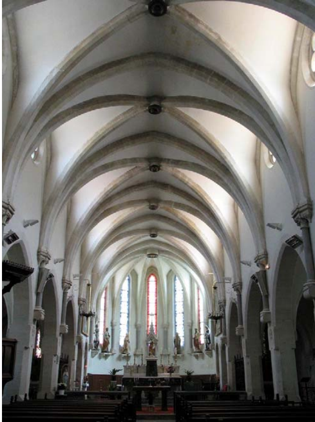
Resim 23. Saint Gimer Kilisesi'nin İç Mekanından Görünüm
