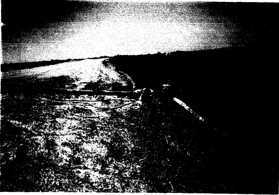
Şekil 3.2. Drenaj kanallarındaki suyun sulama suyu olarak kullanılmasına bir örnek
