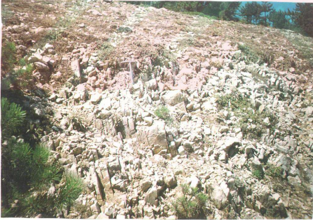
Şekil 2. 6., Ortaburun Sırtı'nın kuzeydoğusundaki Arıkaya formasyonuna ait gri, kirli gri, sarımsı gri ve yer yer pembemsi renkte oldukça çatlaklı, sık kıvrımlı ve laminalı kristalize kireçtaşları (bakış yönü kuzeydoğu).
