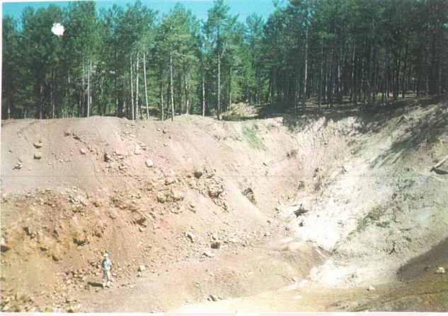
Şekil 2. 13, İpburunçeşme Sırtı'nda açılan yarmada gözlenen silis oranı düşük genelde yumuşak kırmızımsı, kahverengimsi, sarımsı, yeşilimsi renkte lateritik oluşum (bakış yönü güneydoğu).
