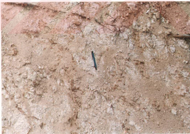
Şekil 2. 35, Bayram Tepesi'ndeki Sarıtaş tüflerinde meydana gelen çatlaklarda görülen demir oksit oluşumları.
