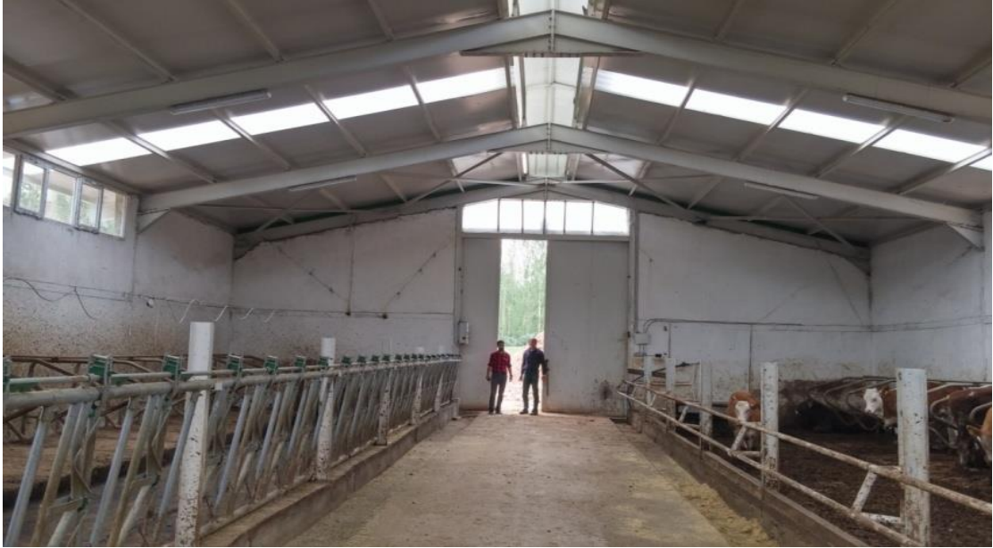
Şekil 4.19. Çatı makasının içten görünüşü
