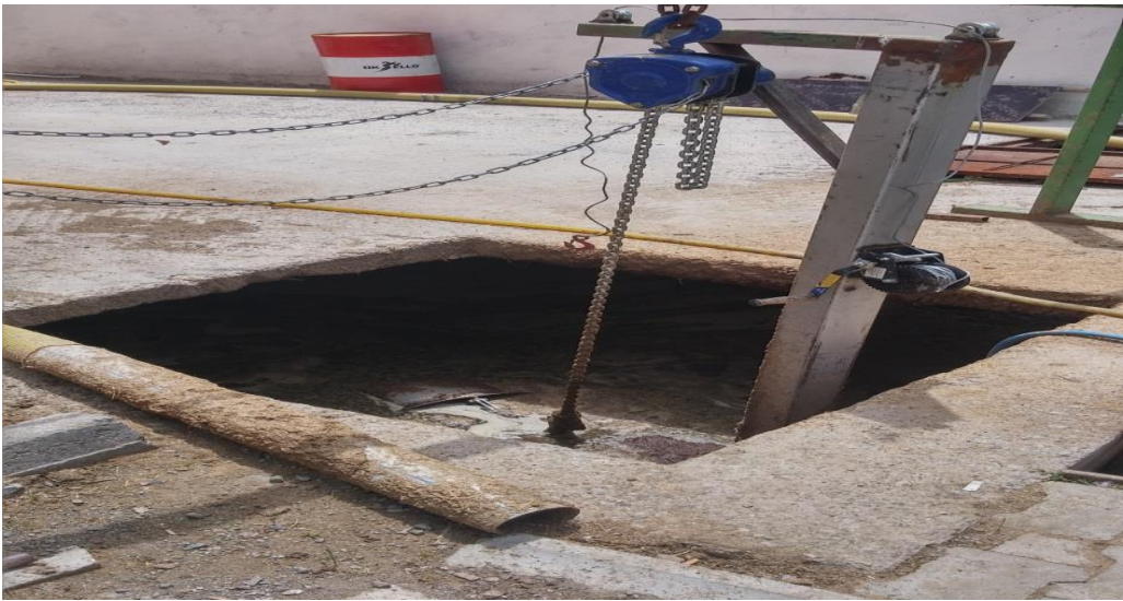
Şekil 4.6. Bir işletmeye ait kapalı gübre çukuru
