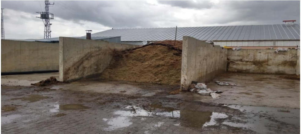
Şekil 4.13. Araştırılan işletmelerden birinde betonarmeden yapılmış silaj çukuru
