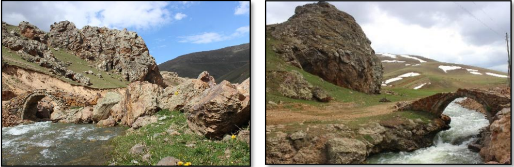
Şekil 3.12. Taş Köprüye ait görüntüler (Nisan 2018)
