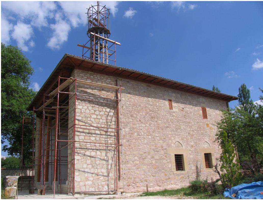
Fotoğraf 22 Restorasyon sırasında yapının çelik konstrüksiyonlu ahşap minaresinin yapım aşaması (Kastamonu Vakıflar Bölge Müdürlüğü).
