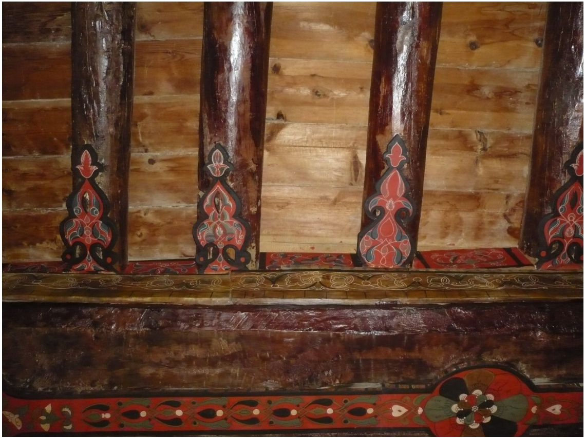
Fotoğraf 109 Beyşehir Eşrefoğlu Camii, tavan, detay
