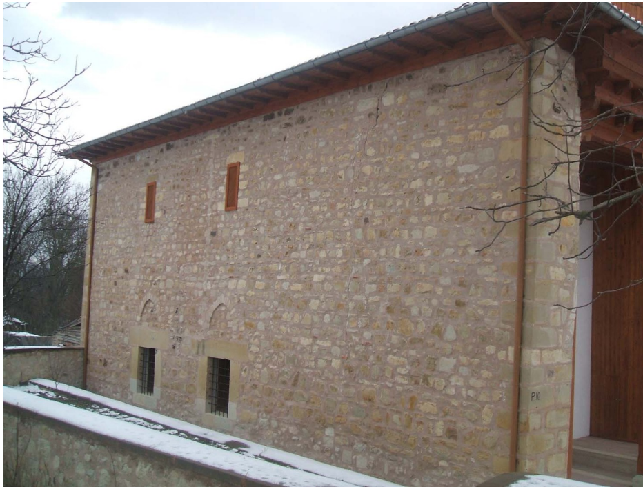
Fotoğraf 10 Yapının dođu cephesi
