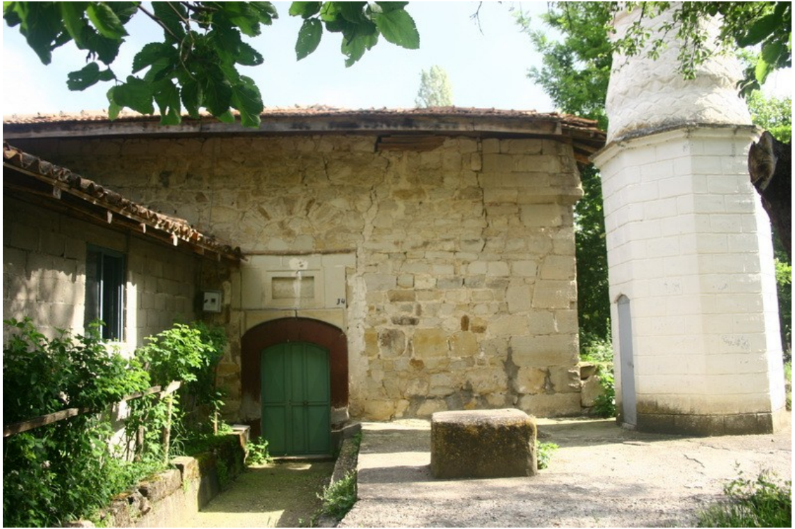
Fotoğraf 118 Saray Camii, giriş cephesi
