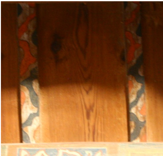
Fotoğraf 48 Mahfil, tavan kirişleri, ahşap levhaların derz çitaları
