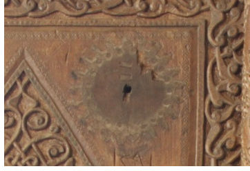
Fotoğraf 26 Kapı kanadı, orta pano, üst köşe, kabara izi
