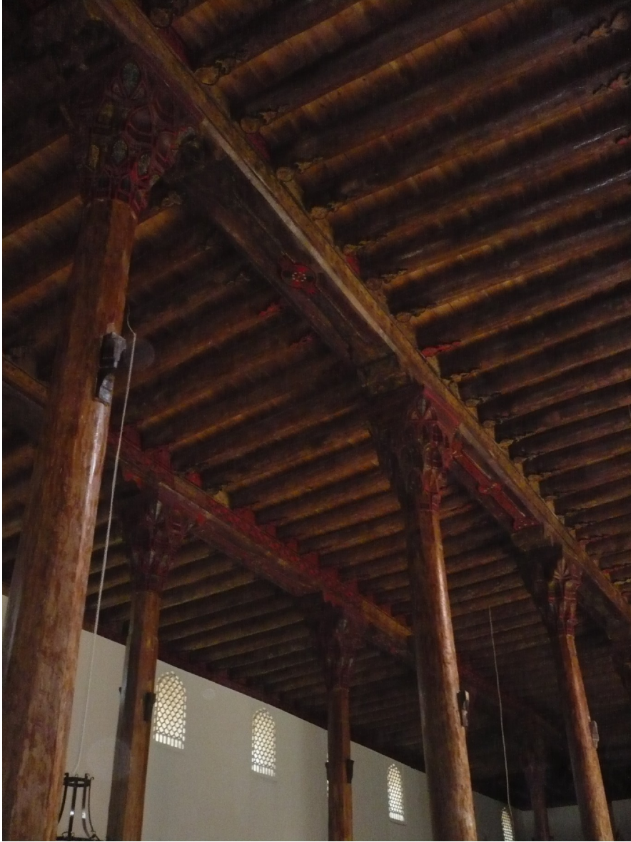
Fotoğraf 96 Beyşehir Eşrefoğlu Camii, destek ve örtü sistemi
