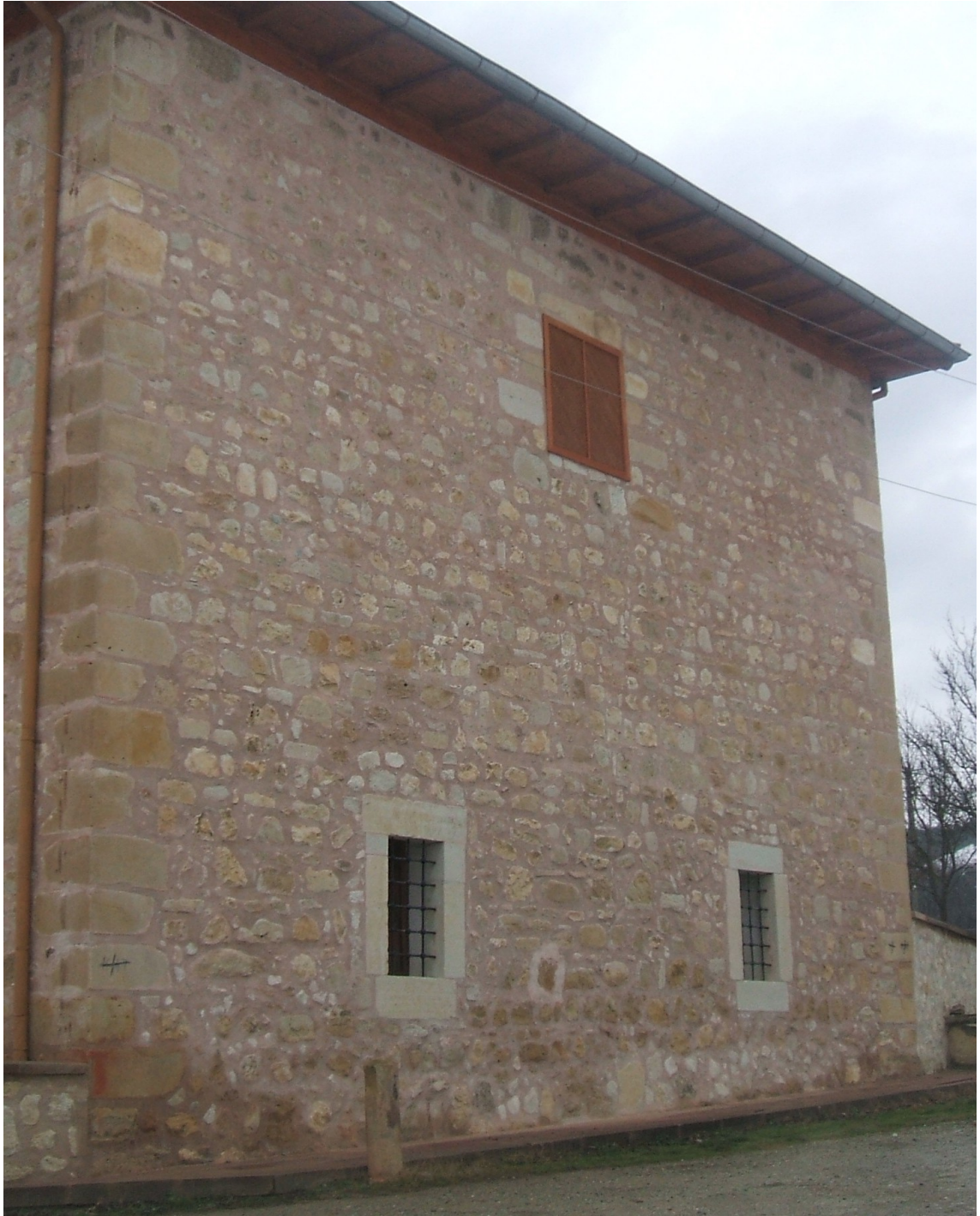
Fotoğraf 11 Yapının güney cephesi
