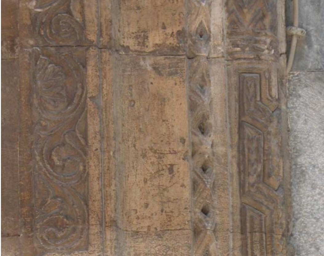
Resim 156 Türbe Kapısı, Ayrıntı
