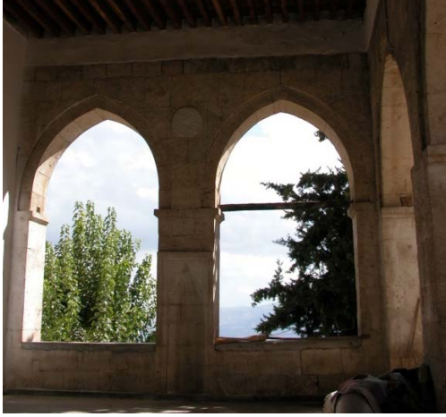
Resim 17 Giriş Mekanı, Mihrap
