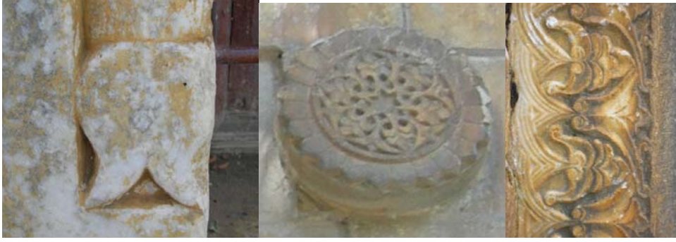
Akşehir Şeyh Hasan Türbesi pencere detay,
