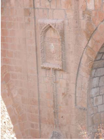
Resim 243 Köprü Kemer Ayağı
