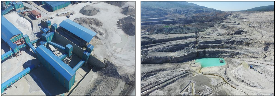
Şekil 2.4. Bigadiç bor yatağı ve üretim tesisi (Eti Maden 2019)
