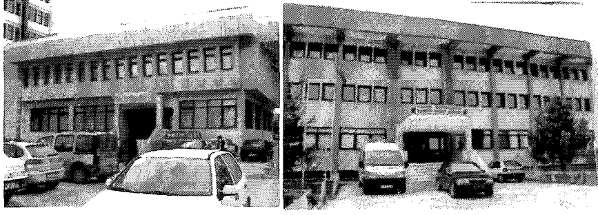
Resim 4.22. Rektörlük binası (solda) (Orijinal 2005), mediko-sosyal binası (sağda) (web adresi).
