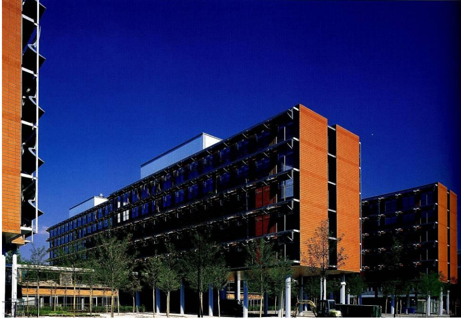
Resim 2.18: Işık Miktarını dengelemeye yardımcı olan cephe aparatlarına örnek
