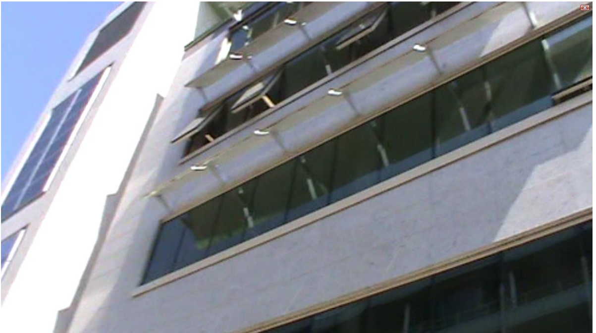
Resim 3.4: Bina dış yüzeyine yerleştirilmiş güneş pilleri ve doğal ışık kontrolü sağlayan cephede bulunan güneş kırıcılar (kişisel arşiv).
