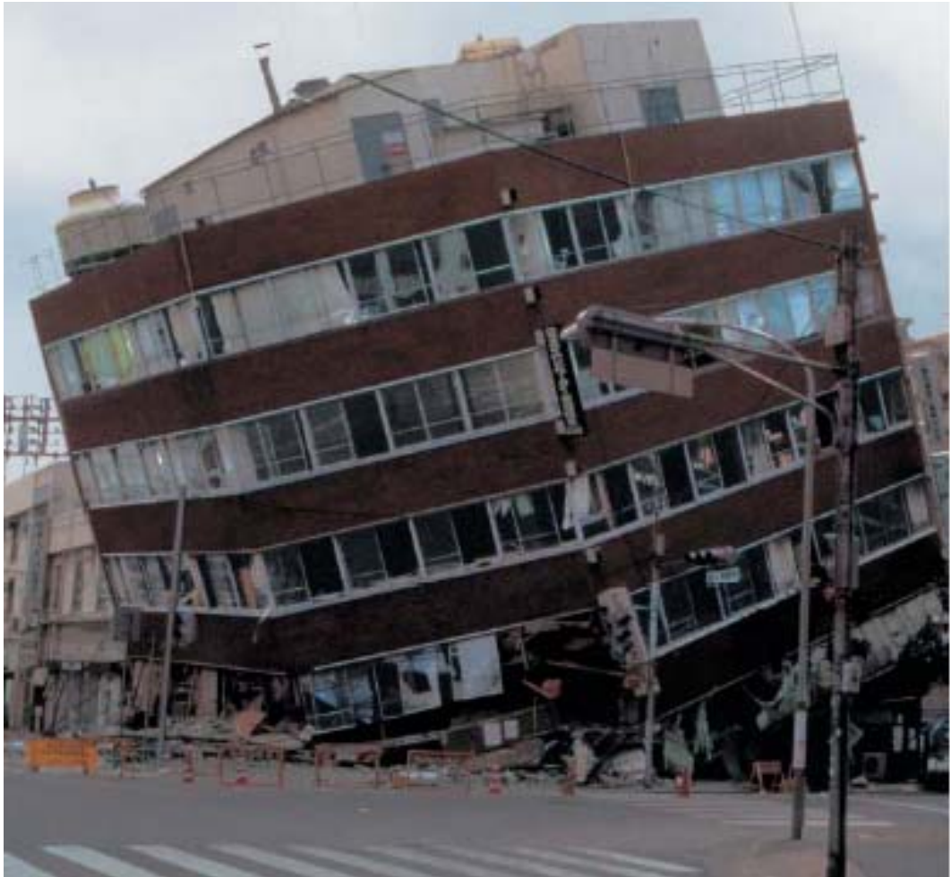
Şekil 1.8 Arkada yangın merdiveni perdesinin etkisi ile burulma etkisiyle yıkılan bina (Kobe 1995)
