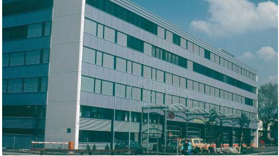
Şekil 1.14 Perdeler ile güçlendirilmiş 3 katlı bina (İsviçre 2001)
