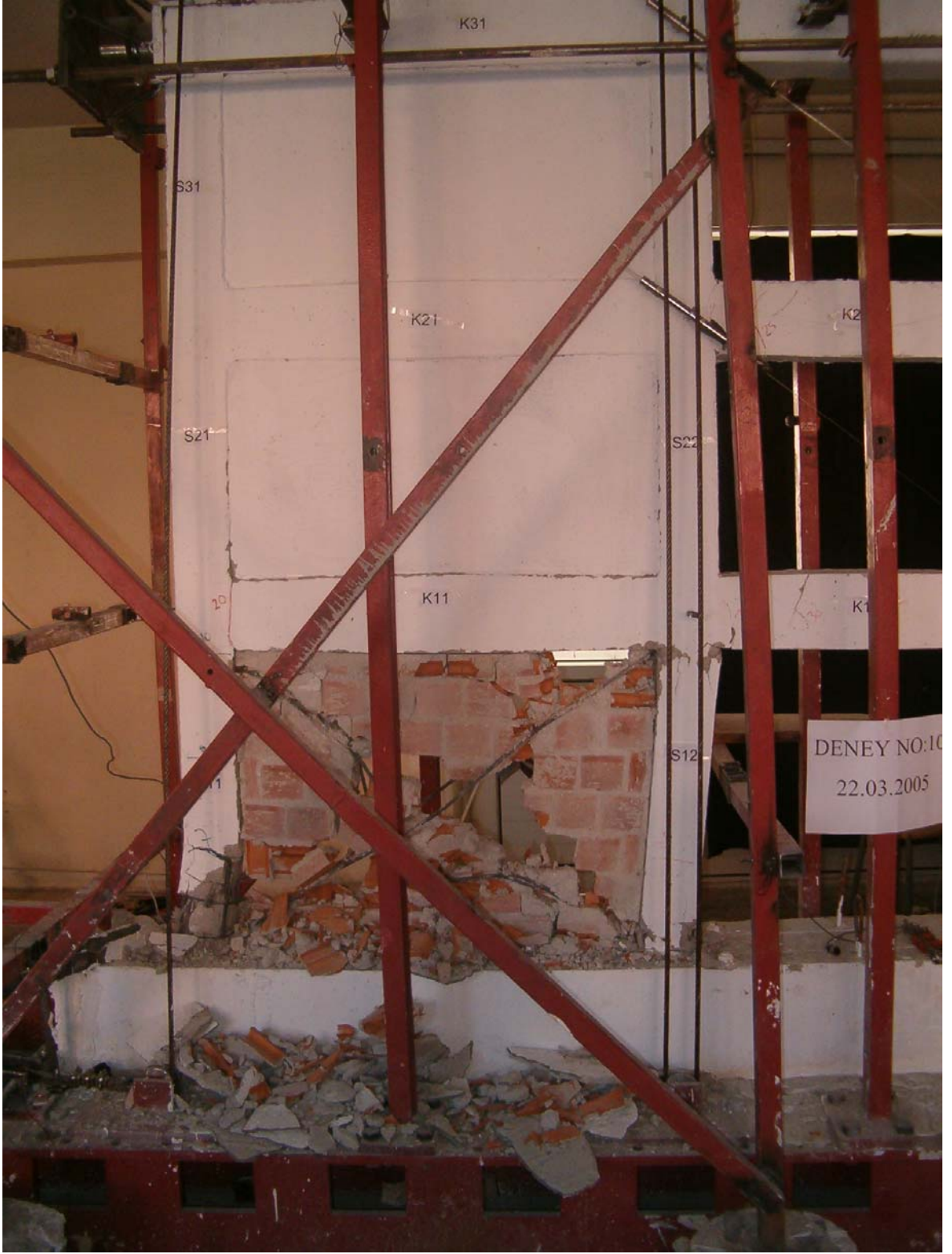
Şekil 5.10.9 Deney numunesinde dolgu duvar hasarı
