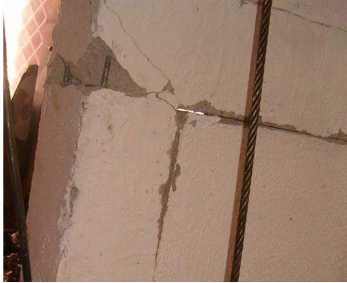
Şekil 5.10.12 Ayrılmış duvar ve kolon
