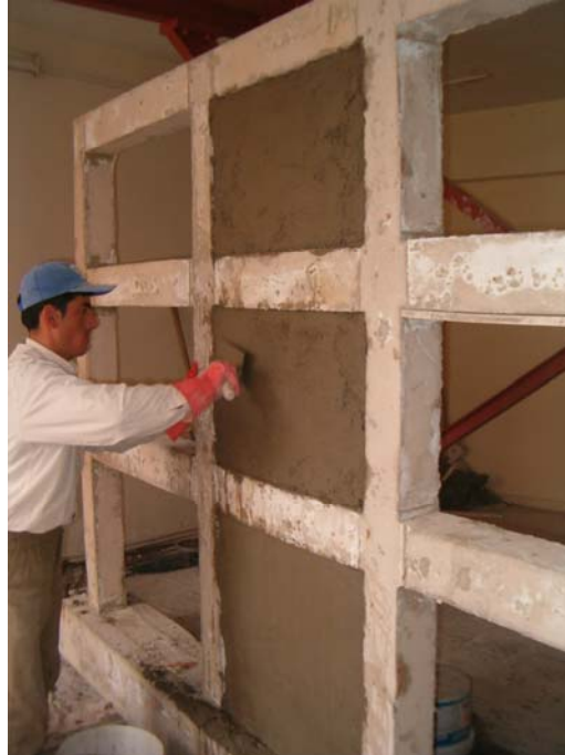
Şekil 3.48 Sıva yapılması
