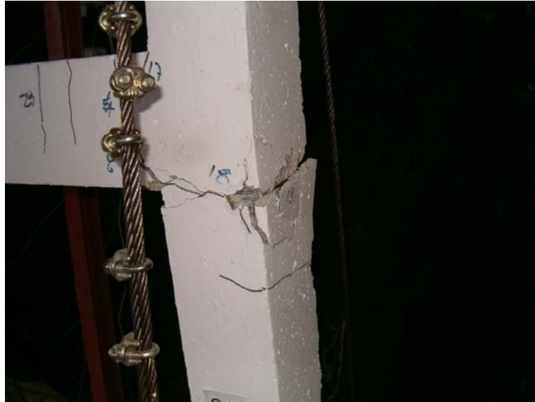
řekil 5.3.6. 3 nolu deney numunesinin kenar kolon stnde mafsallařma bařlangıcı
