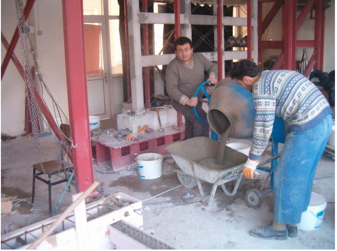
Şekil 3.31 Beton hazırlama işlemi
