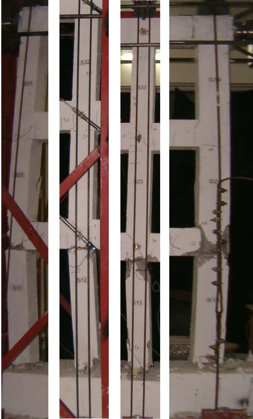
Şekil 5.2.5 Mesnetlerde ve zemin kat kolonlarında oluşan mafsallar
