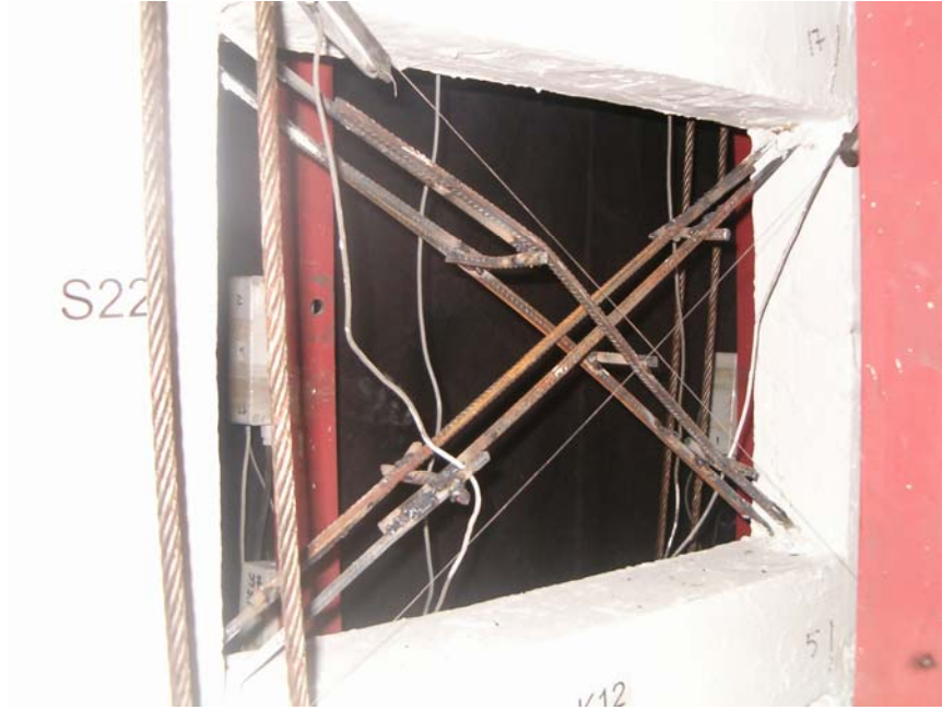
Şekil 5.7.10 7 nolu deney numunesinde çekmeye çalışan ve burkulan kuşaklamalar
