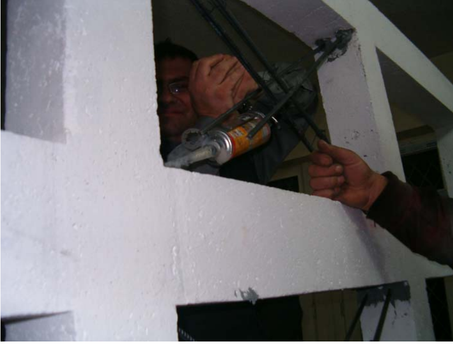
Şekil 3.41 Epoksi enjeksiyonu
