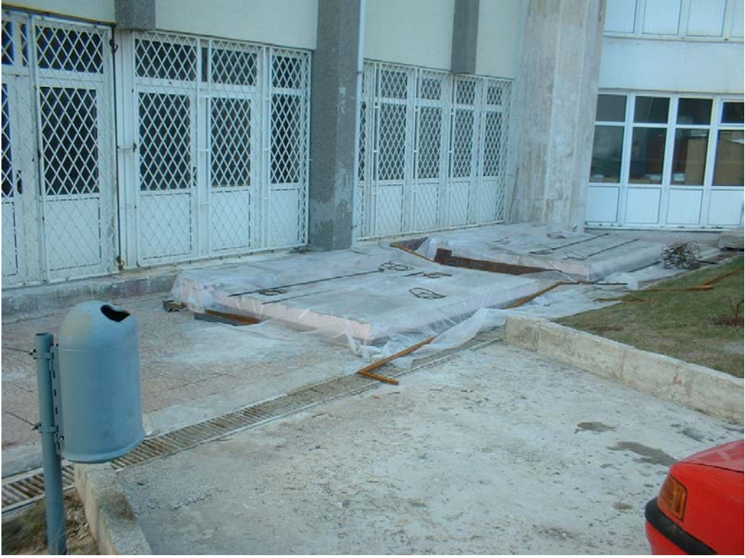
Şekil 3.33 Dışarıda dökülen numunelerin kürlenmesi
