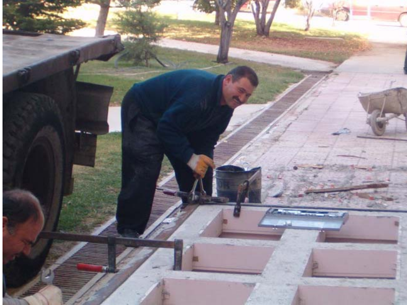
Şekil 3.37 Profiller yardımıyla çerçevenin bağlanması
