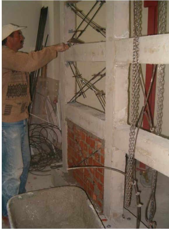
Şekil 3.46 Tuğla duvar örülmesi
