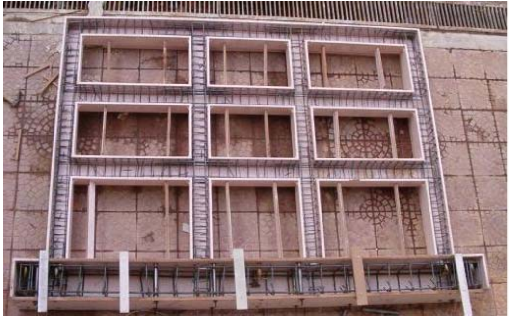
Şekil 3.25 Betonlanmaya hazır T2 donatı düzenine sahip numune
