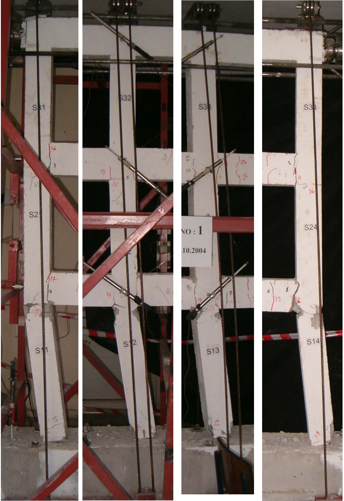
Şekil 5.1.5. Mesnetlerde ve zemin kat kolon uçlarında oluşan mafsallar
