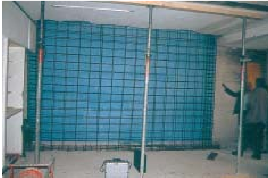
Şekil 1.12 Perdeler ile yapılan güçlendirme uygulaması
