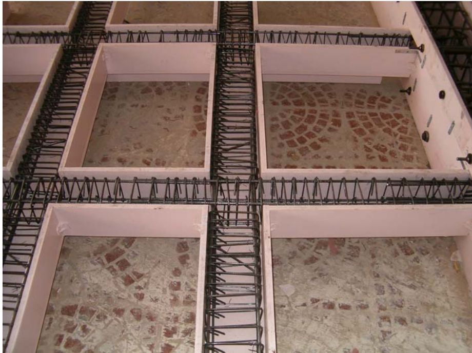
Şekil 3.23 Kolon-Kiriş bölgesinde devam eden etriyeler ve sıklaştıрма bölgesi
