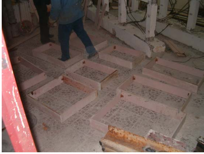
Şekil 3.27 Üretilen kalıpların birleştirilmesi
