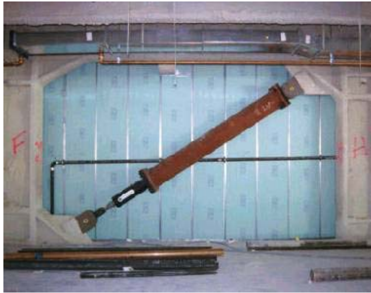
Şekil 3.1. Çerçevenin yatay deplasmanını azaltan sistem
