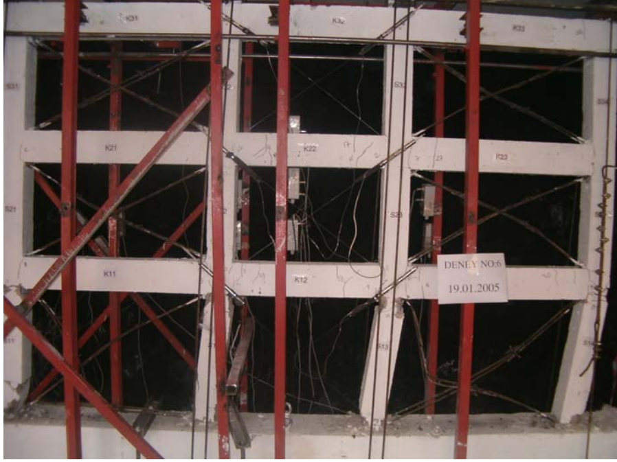
Şekil 5.6.9 6 nolu deney numunesinde yumuşak kat mekanizması
