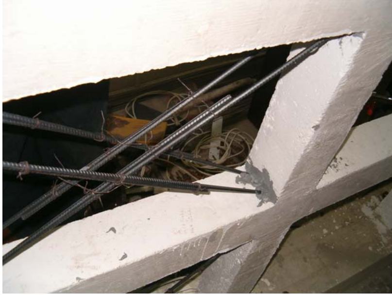
Şekil 3.43 Çapraz filizlerinin sabitlenmesi
