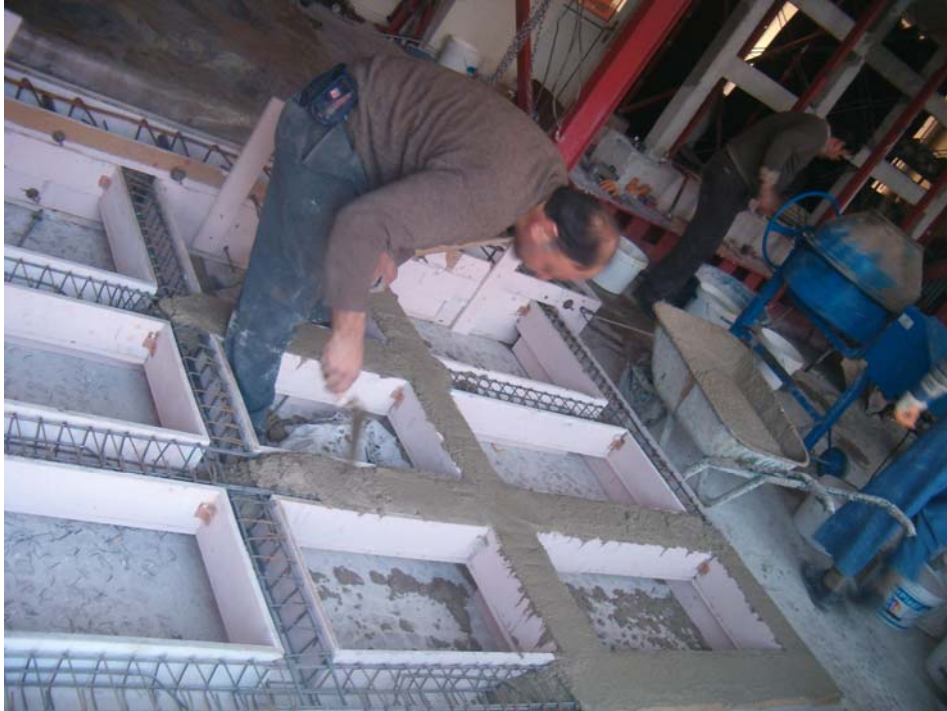
Şekil 3.32 Çerçeve numunelerinin beton döküm ve yerleştirme işlemi
