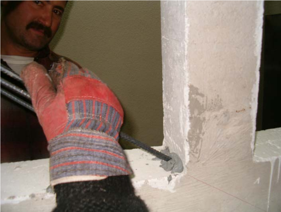
Şekil 3.42 Çapraz filizlerinin yerleştirilmesi
