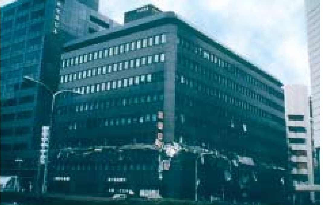
Şekil 1.5 Üst katlarda yumuşak kat davranışı (Kobe 1995)
