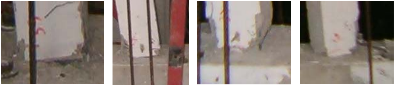
Şekil 5.1.9. 1 nolu deney numunesi zemin kat kolon – temel birleşiminde mafsallaşma
