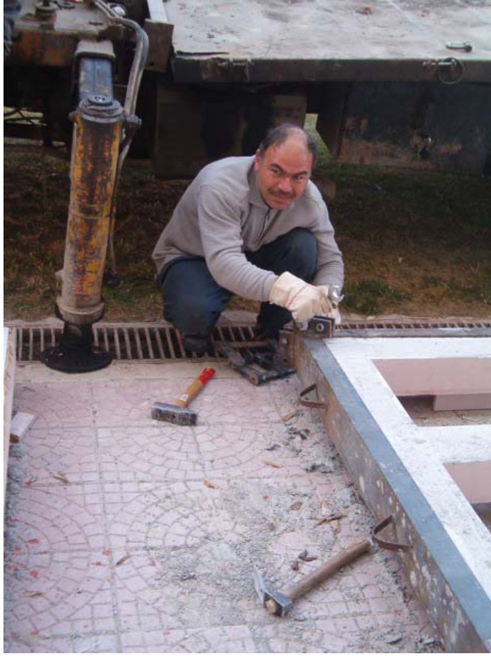
Şekil 3.38 Çerçevenin düşey konuma getirilmesi için kullanılan aparat
