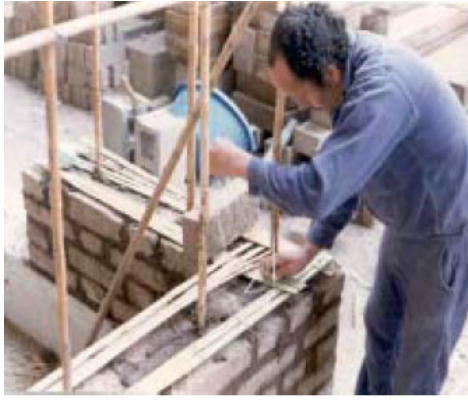
Şekil 3.85 Duvar içine bambu yerleştirilmesi
