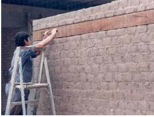
a) Duvara ahşap plaka sabitlemesi
