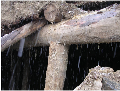
a) Çatıyı taşıyan ahşap hatıl ve dikme
