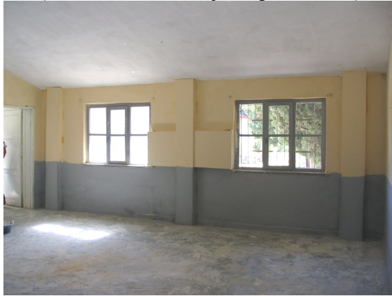
Şekil 4.49 İçeriden kapatmanın bitirilmesi ve boyanarak hazırlanması (DM2003-1451 Proje Raporu, 2003)
