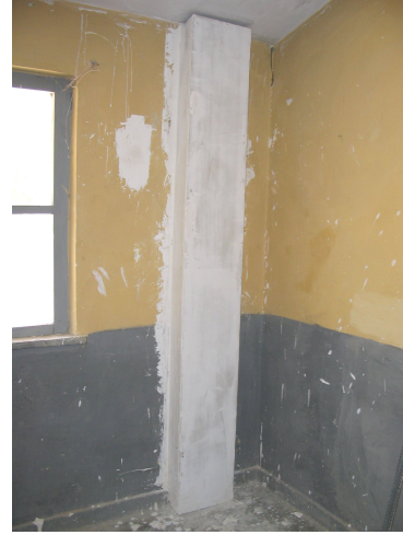
Şekil 4.48 Düşey sargılamanın içeriden kapatılması (DM2003-1451 Proje Raporu, 2003)
