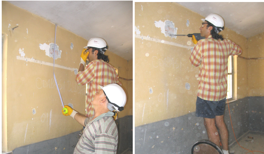
Şekil 4.45 Delik yerlerinin belirlenmesi ve deliklerin açılması (DM2003-1451 Proje Raporu, 2003)
