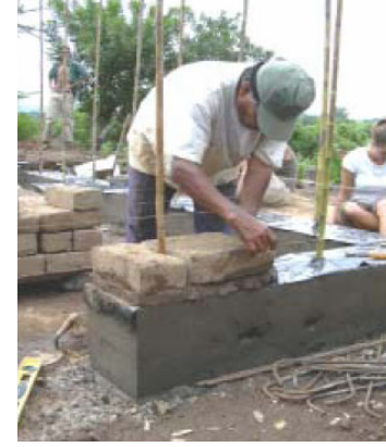
Şekil 3.85 Duvar içine bambu yerleştirilmesi
