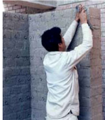
d) Telin döşenmesi
