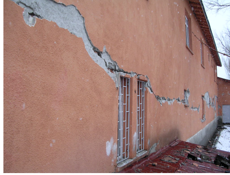
Şekil 3.26 Duvarda birden fazla açıklık bulunması durumunda çatlama (Erzurum-2004 Kaynak: A. Türer)
