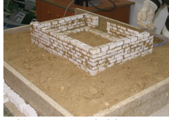
b) Pencere alt hizasına kadar örülmüş duvar
