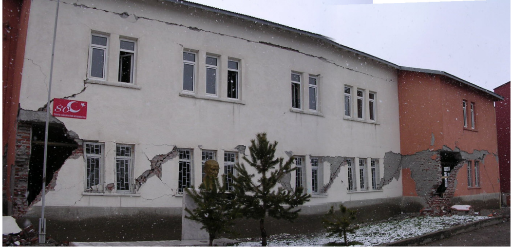
d) Okul binası
