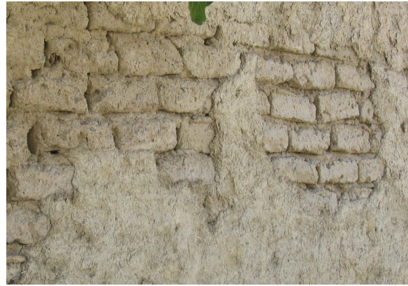
Kerpiç duvar görünüşü
