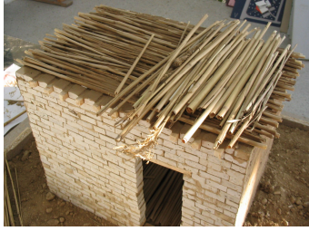
d) Çatı kirişleri üzerine hasır ve kamışların konulması
