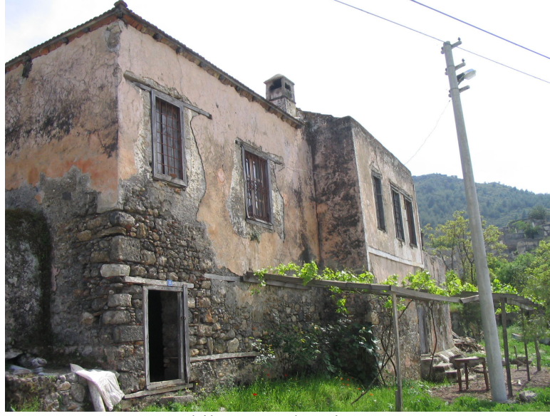
Şekil 2.4 Taş kargir yapı
