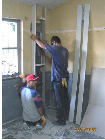
Şekil 4.48 Düşey sargılamanın içeriden kapatılması (DM2003-1451 Proje Raporu, 2003)
