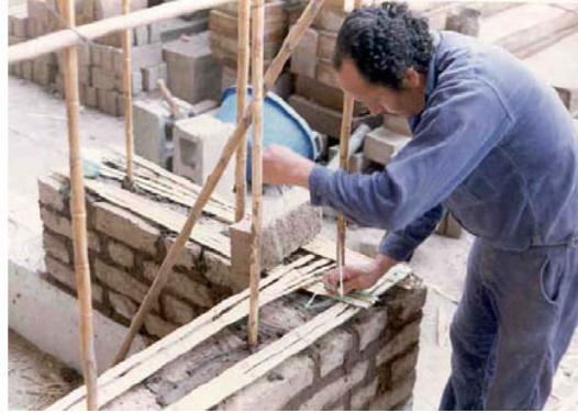
Toprak duvarların içine yatayda ve düşeyde ahşap elemanlar yada kamış -bambu donatılar yerleştirilmesi
