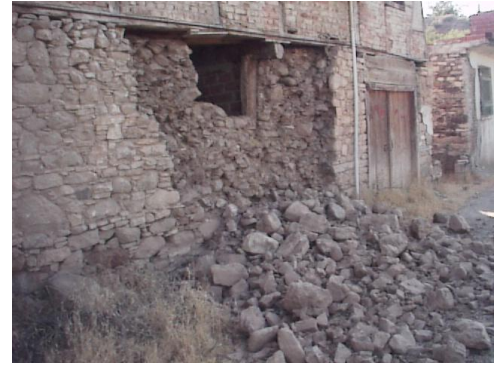
b) Duvarın dış tarafının yıkılması (Kaynak T. Wasti)
