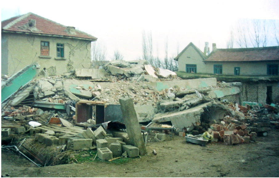
Şekil 2.12 Adsız Köyünde yıkılan 3 katlı betonarme bina (2000 yılı Akşehir depreminde)
