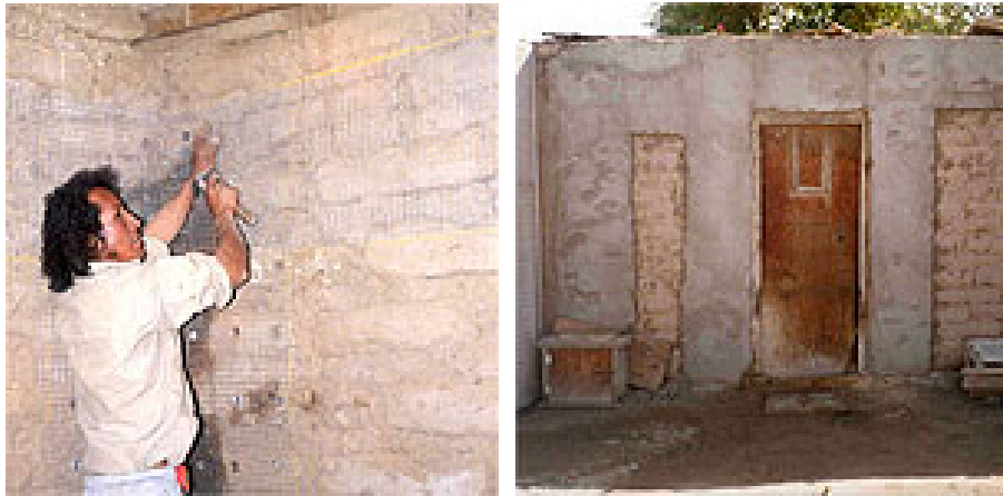
Şekil 3.109 Peru'da kümes teli ile kerpiç yapıların güçlendirilmesi (Arie, 2001)
