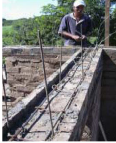
Şekil 3.84 Duvar içine donatı yerleştirilmesi örnekleri (Graham, 2001)
