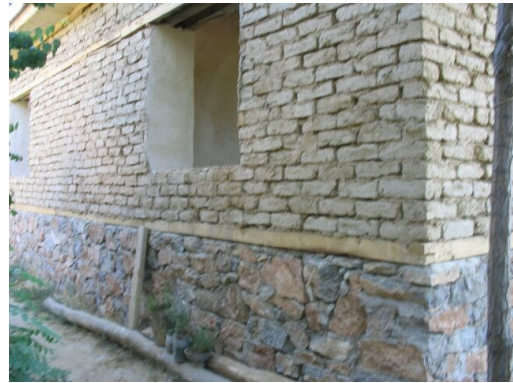
Şekil 3.56 Kerpiç yapıda taş duvar ve hatıllar
