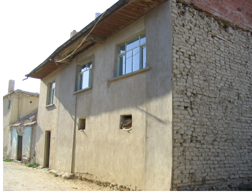
Şekil 3.93 Akşehir'de kerpiç yapıda uygulanan güçlendirme örneği
