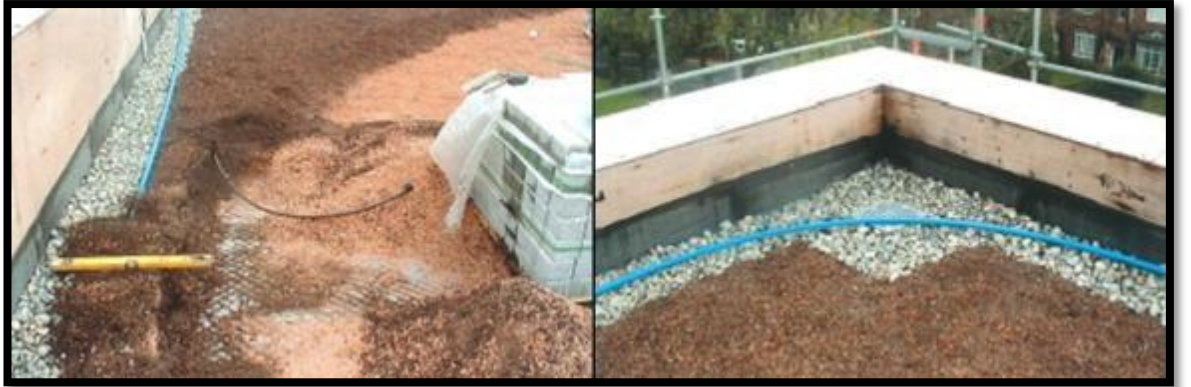
Şekil 4.28 Sulama borusunun drenaj katmanı üzerinden geçişi örneği
