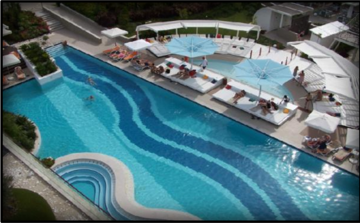
Şekil 5.32 Sensimar Hotel altıncı kısım tesisat odasının üzerinde tasarlanan havuz ve çevresinden görünüm (Anonim 2013a)
