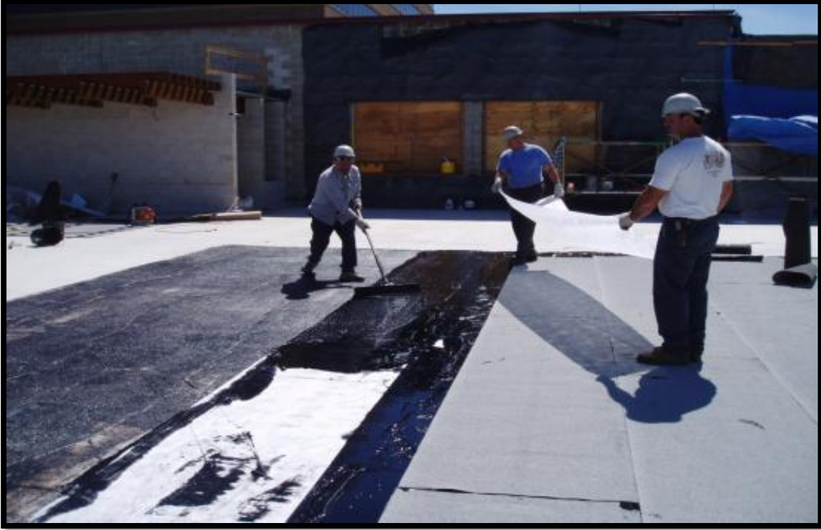
Şekil 4.21 Likit membran uygulaması (Anonymous 2013p)
