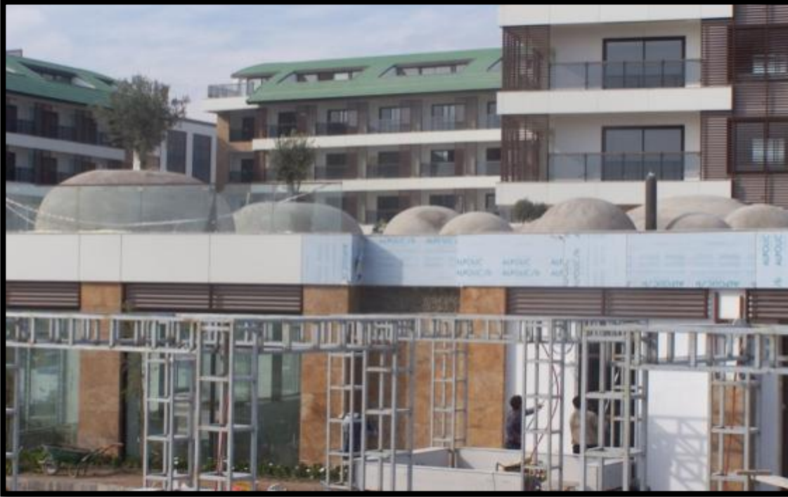
Şekil 5.8 Sensimar Hotel birinci kısım çim tepelerin yapım aşaması (Anonim 2013a)
