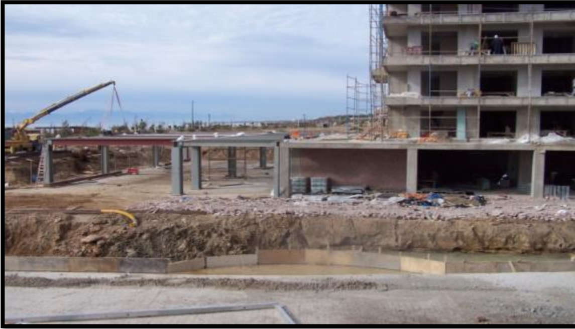
Şekil 5.20 Sensimar Hotel üçüncü kısım uygulama çalışmalarından bir görüntü (Anonim 2013a)
