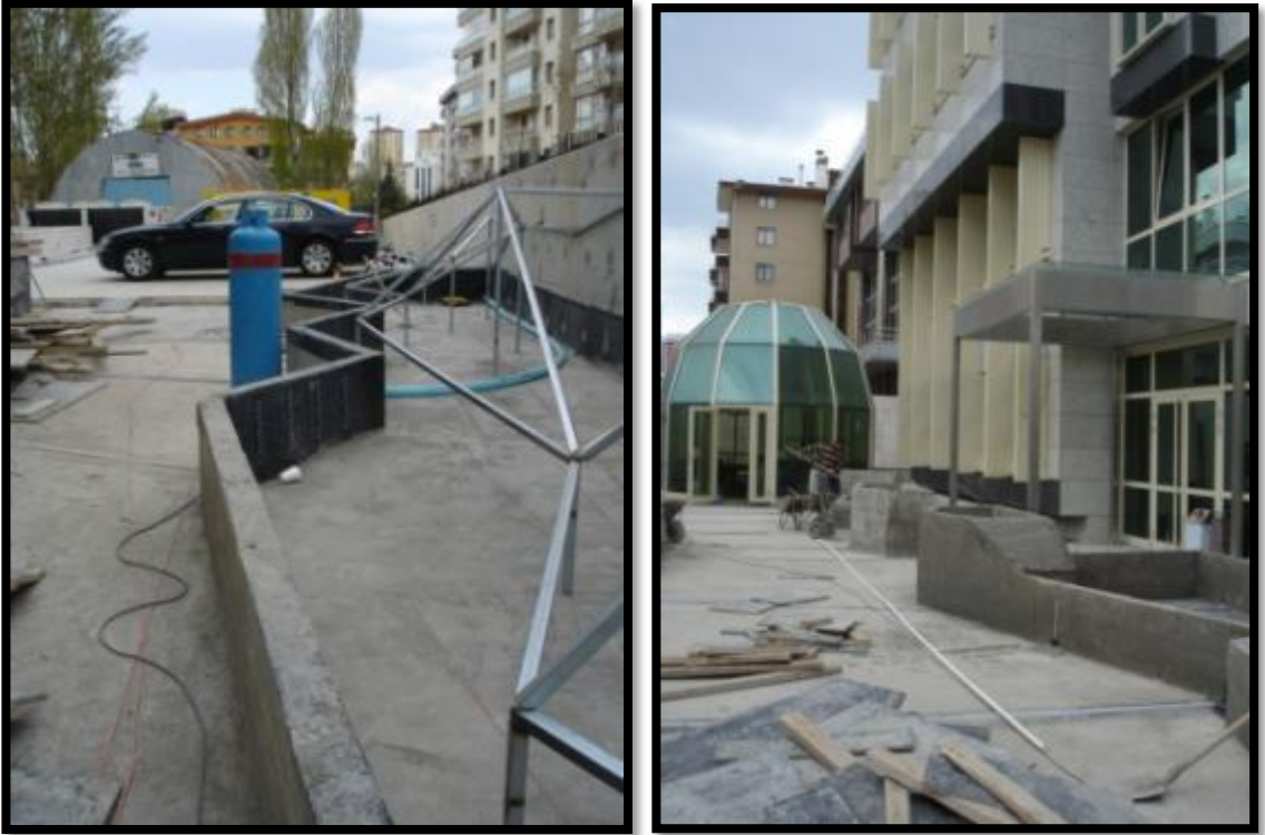
Şekil 5.41 Eser inşaat hizmet binası arka bahçesinin yapım aşamalarından görüntüler (Anonim 2013a)
