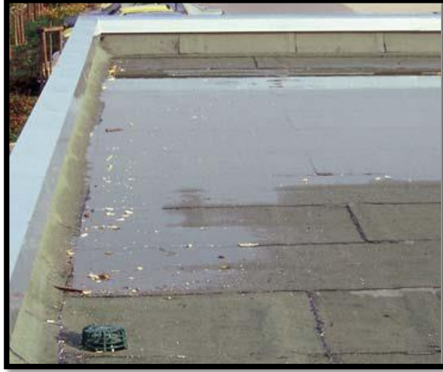
Şekil 4.38 En az % 2 eğimli çatılarda ekstansif çatı uygulamasına ait örnek çatı görünümü
