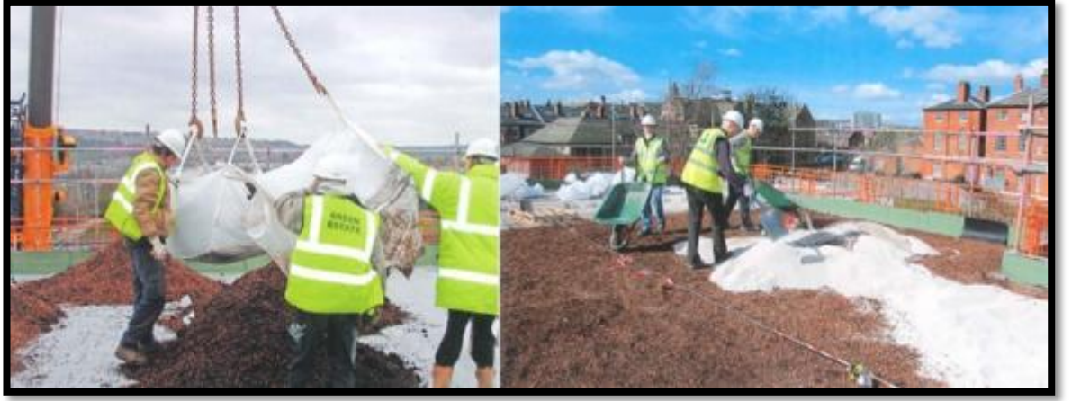
Şekil 4.27 Agregatın çatıya aktarılması (Dunnett ve Kingsbury 2008)
