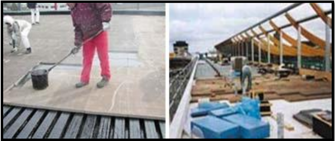
Şekil 4.24 Fesco levha örneği ve uygulaması (Anonymous 2013t)
