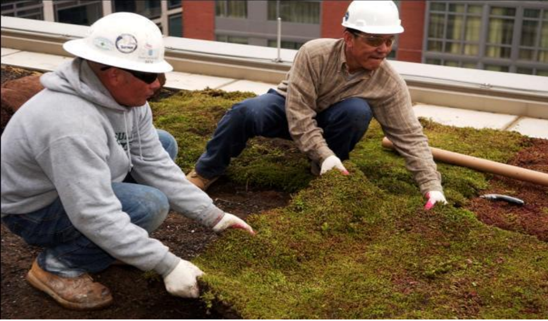
Şekil 4.82 Sedum bitkilerinin yerleştirilmesi (Anonymous 2012a)
