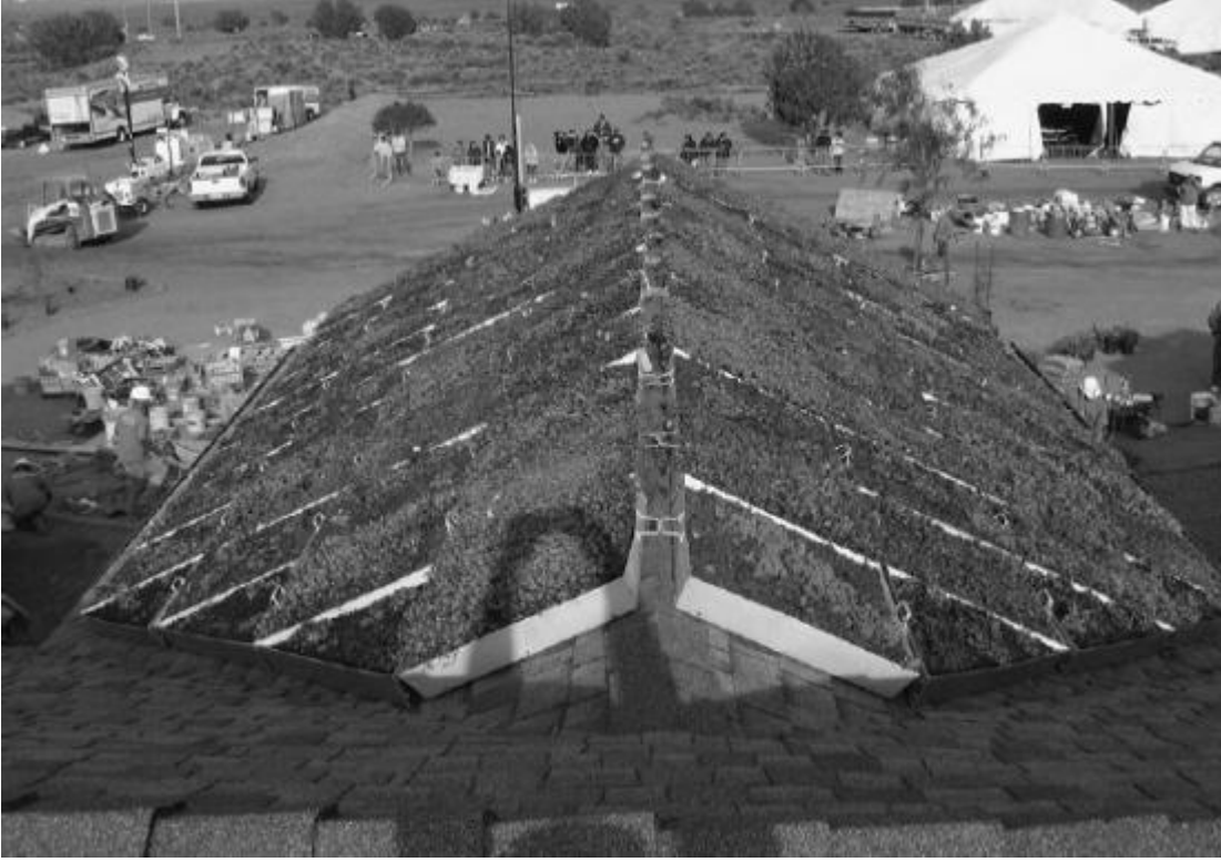
Şekil 4.81 Paslanmaz çelik kısaçlar kullanılan modüler çatı (Luckett 2009)
