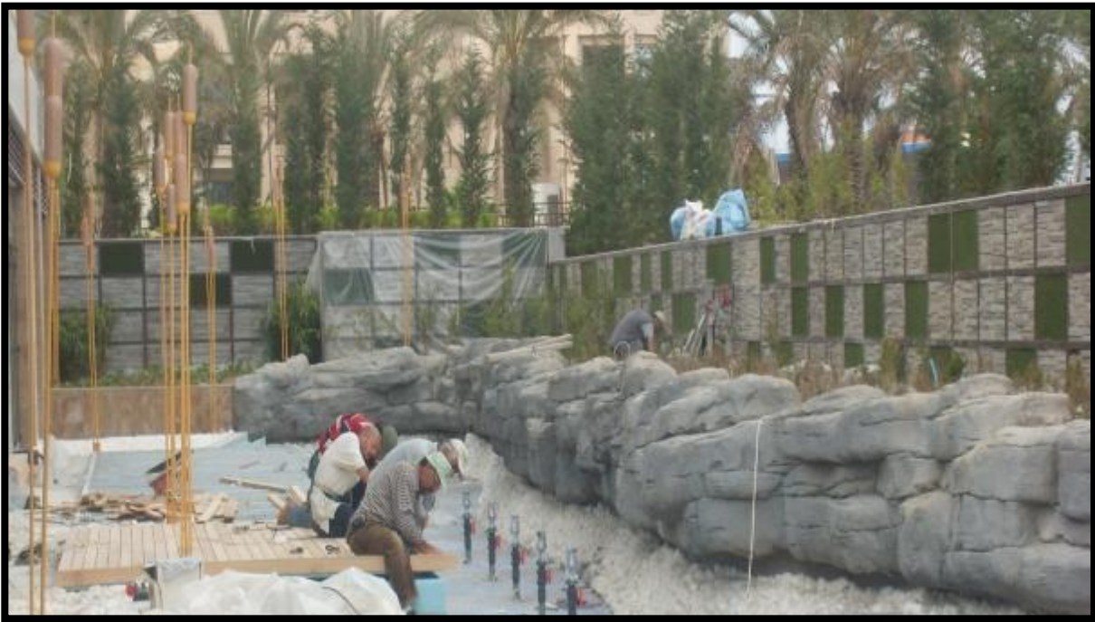
Şekil 5.28 Sensimar Hotel beşinci kısım yapım aşamalarından bir görüntü (Anonim 2013a)
