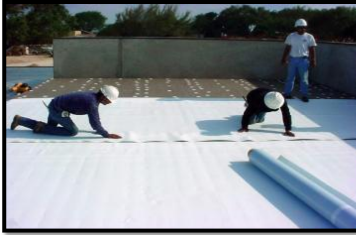
Şekil 4.18 TPO su yalıtım membranı (Anonymous 2013o)
