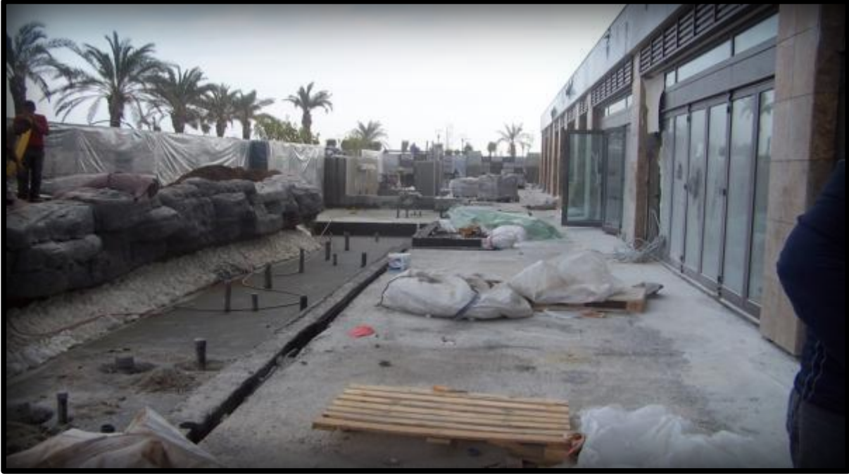
Şekil 5.27 Sensimar Hotel beşinci kısım yapım aşamalarından bir görüntü (Anonim 2013a)
