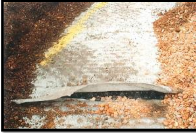
Şekil 4.29 Drenaj katmanı örneği
