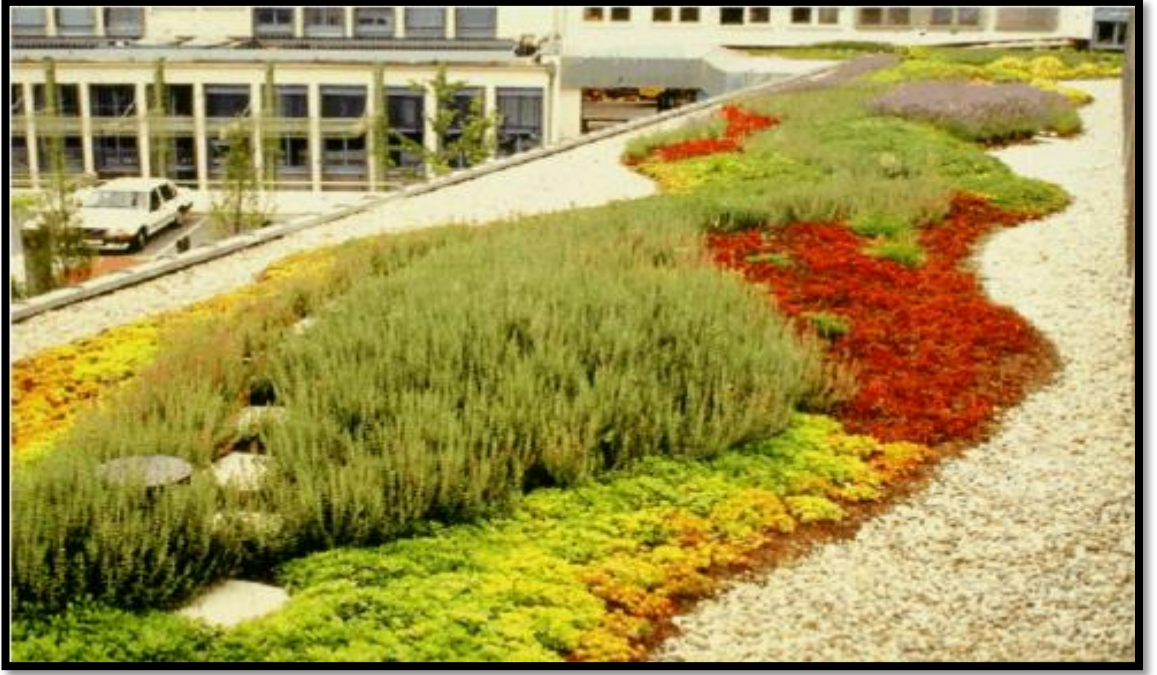
Şekil 1.7 Kuzey Almanya'da uçak hangarı üzerindeki bitkilendirilmiş çatı (Anonymous 2013)
