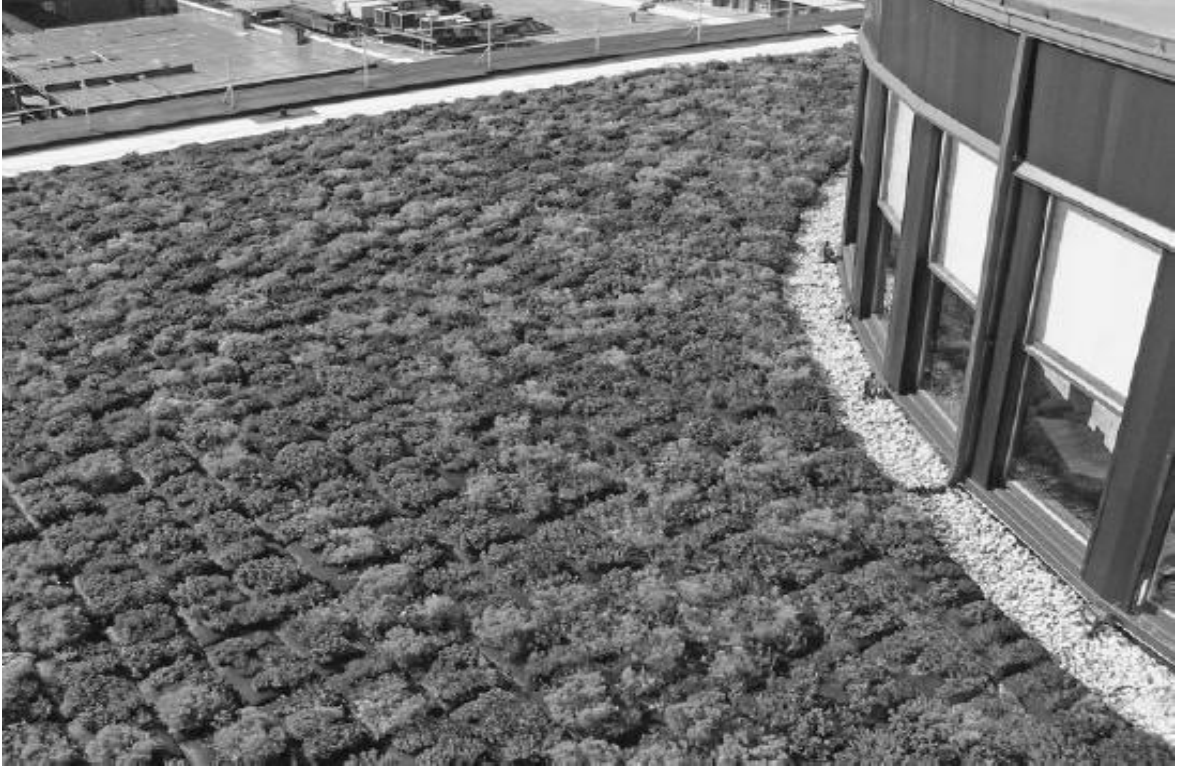
Şekil 4.72 Düzensiz olarak şekillendirilen çatı alanlarına yeşil çatı modüllerinin kurulumu (Lockett 2009)
