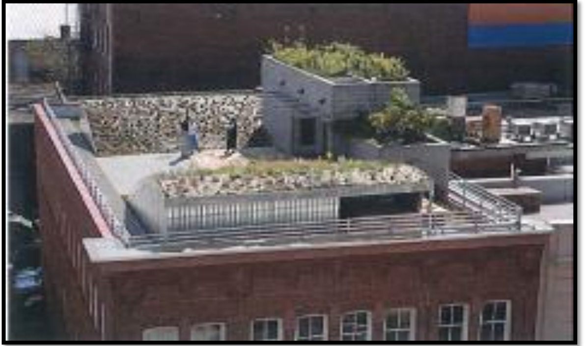
Şekil 4.6 Amerikan Peyzaj Mimarları Topluluğu'nun merkez binası üzerinde bulunan yeşil çatı (Dunnett ve Kingsbury 2008)
