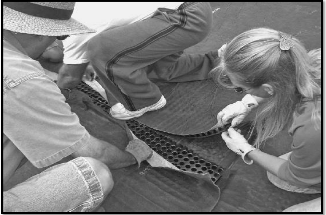
Şekil 4.30 Kök bariyer sisteminin uygulama örneği
