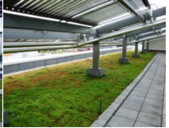
Şekil 4.84 Önceden işlenmiş bitkilendirilmiş örtü sistemi ile uygulanmış ekstantif yeşil çatı örneği (Waterloo Şehir Merkezi, Kanada (Anonymous 2012b))
