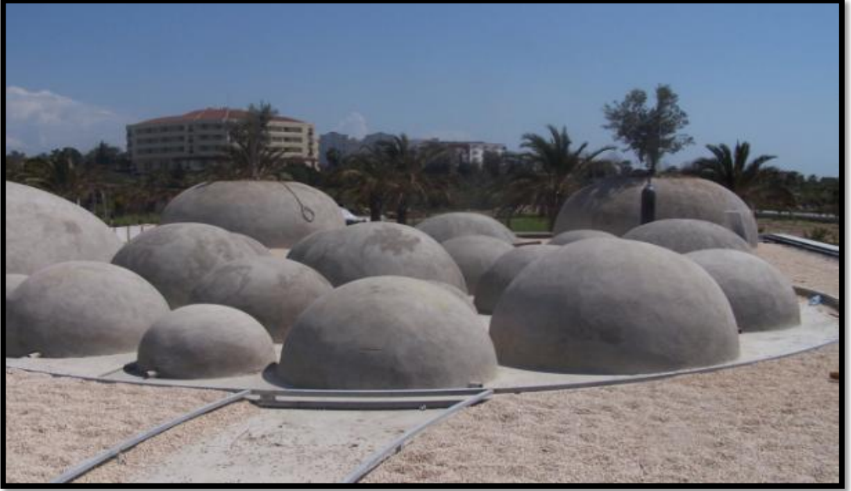
Şekil 5.9 Sensimar Hotel birinci kısım çim tepelerin yapım aşaması (Anonim 2013a)
