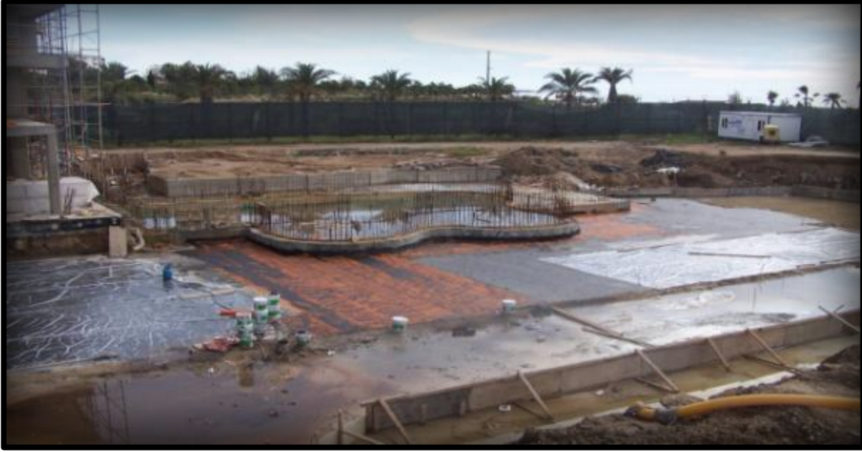
Şekil 5.31 Sensimar Hotel altıncı kısım yapım aşamalarından bir görüntü (Anonim 2013a)
