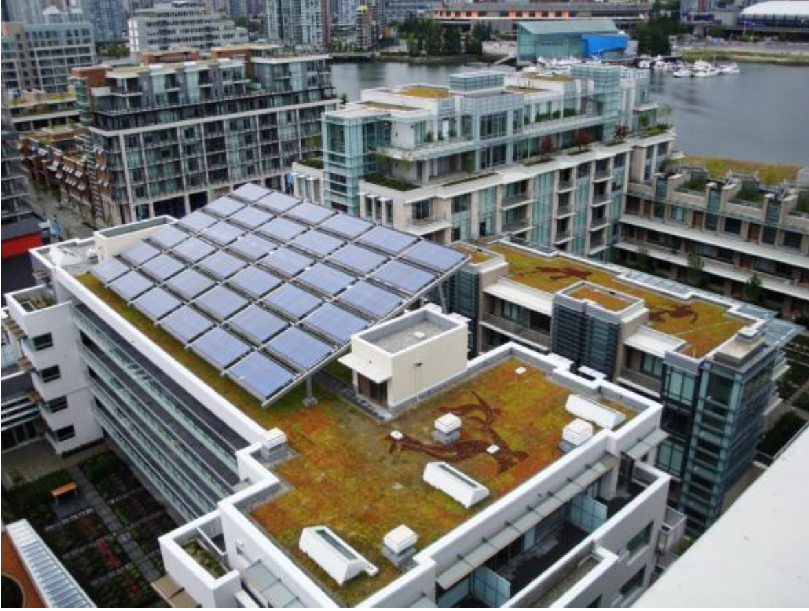
Şekil 4.85 Önceden işlenmiş bitkilendirilmiş örtü sistemi ile uygulanmış ekstentif yeşil çatı örneği (Vancouver 2010 Olimpiyat Köyü, Kanada ) (Anonymous 2012b)
