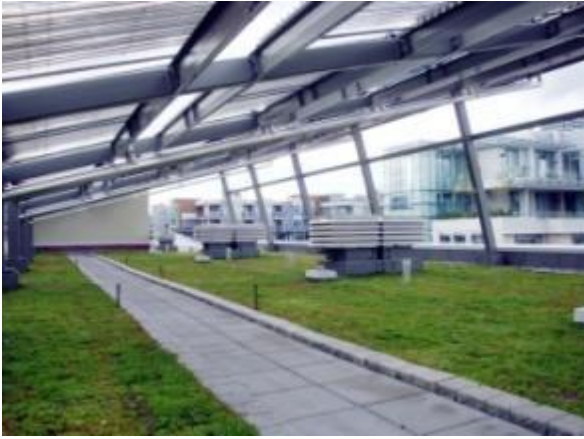
Şekil 4.84 Önceden işlenmiş bitkilendirilmiş örtü sistemi ile uygulanmış ekstantif yeşil çatı örneği (Waterloo Şehir Merkezi, Kanada (Anonymous 2012b))
