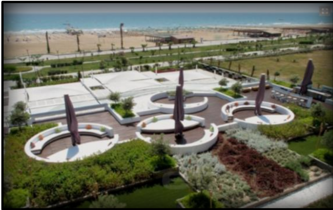
Şekil 5.22 Sensimar Hotel üçüncü kısım restoran üzeri çatı bahçesi (Anonim 2013a)
