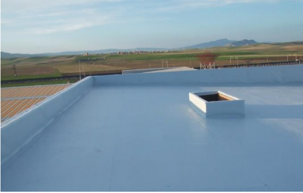
Şekil 4.19 UV ışınlarına dayalı PVC membran (Anonymous 2014a)
