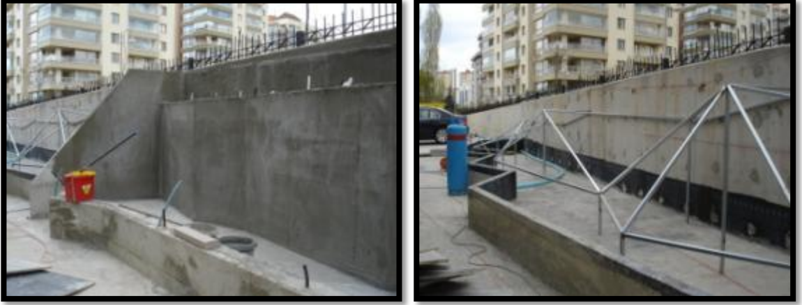
Şekil 5.40 Eser inşaat hizmet binası arka bahçesinin yapım aşamalarından görüntüler (Anonim 2013a)
