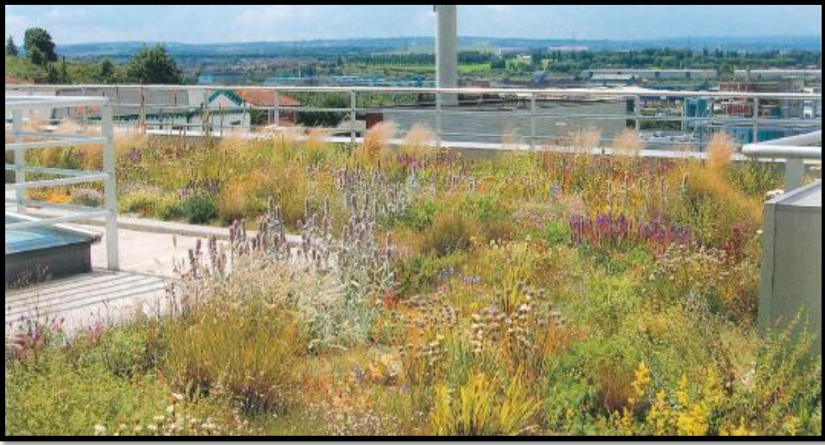
Şekil 4.5 İngiltere- Rotherham, Moorgate Crofts İş Merkezindeki yarı-ekstansif yeşil çatı
