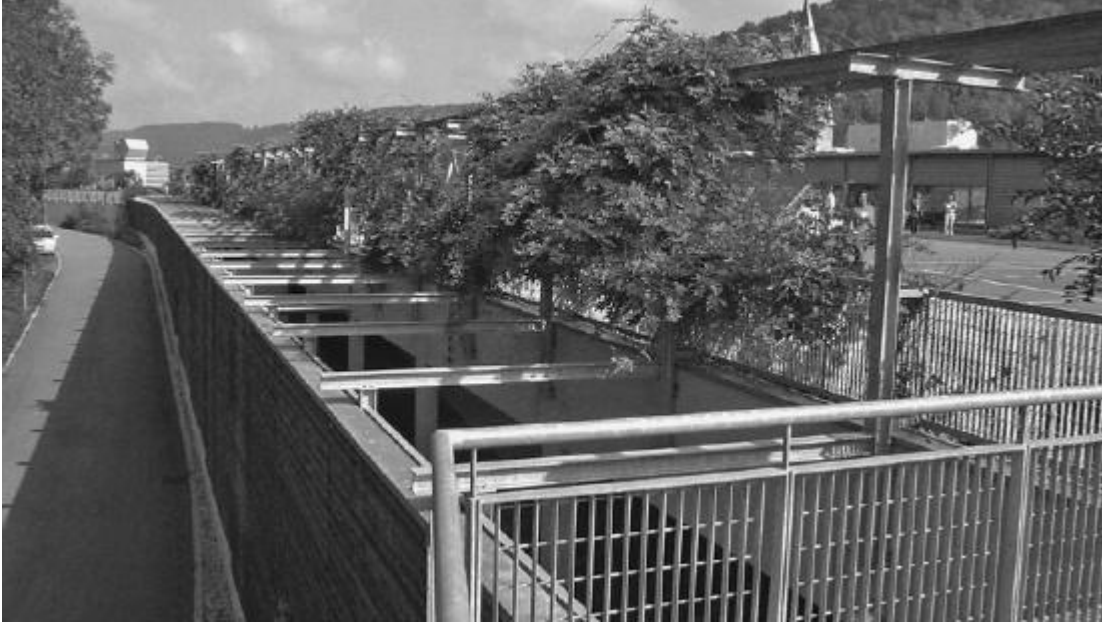
Şekil 4.78 Yeşil çatının altında bulunan ticari alandan bir görünüm
