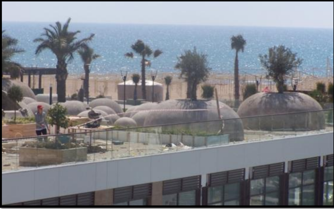
Şekil 5.7 Sensimar Hotel birinci kısım çim tepelerin yapım aşaması (Anonim 2013a)
