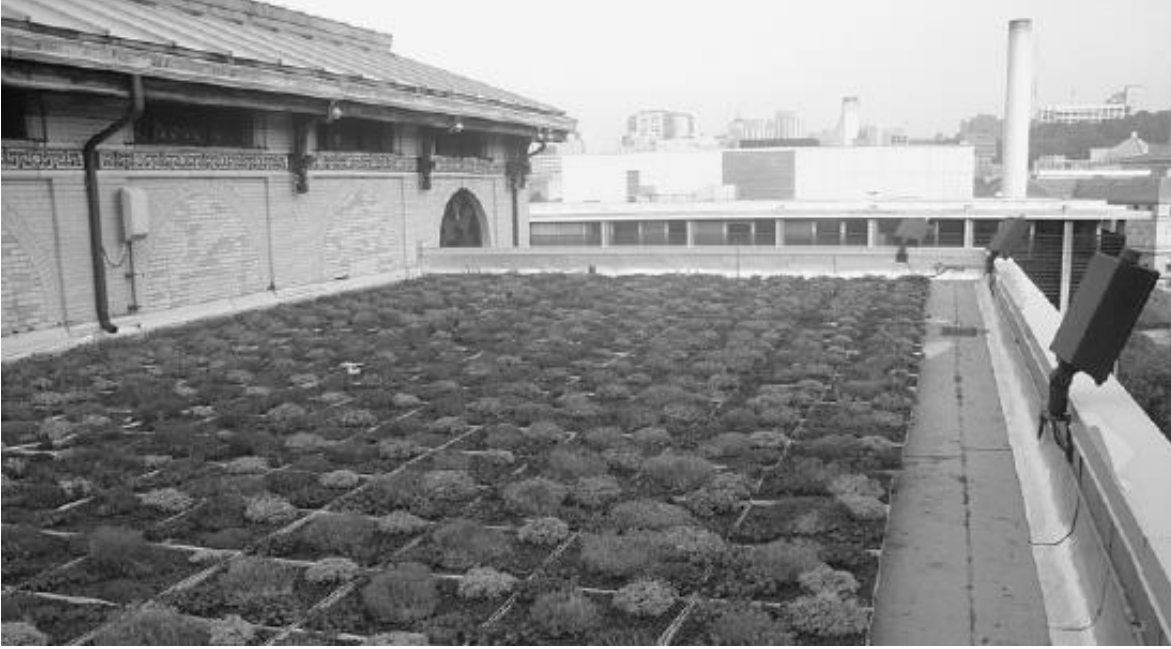
Şekil 4.71 Çatıların tepesinde düzenlenen çiçekliklerden oluşan modüler yeşil çatı (Luckett 2009)
