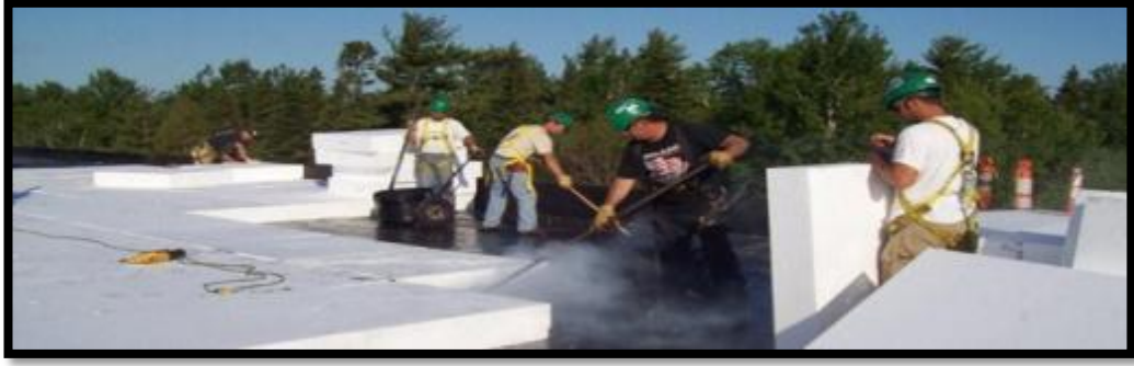
Şekil 4.23 Genleşmiş polistren uygulaması (Anonymous 2013s)
