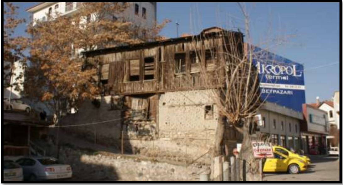
Şekil 5.22 Beypazarı evi (giriş kat: taş malzeme, 1. kat: ahşap malzeme ve dolgu malzemesi, 3. kat: ahşap malzeme) (Orjinal 2013)
