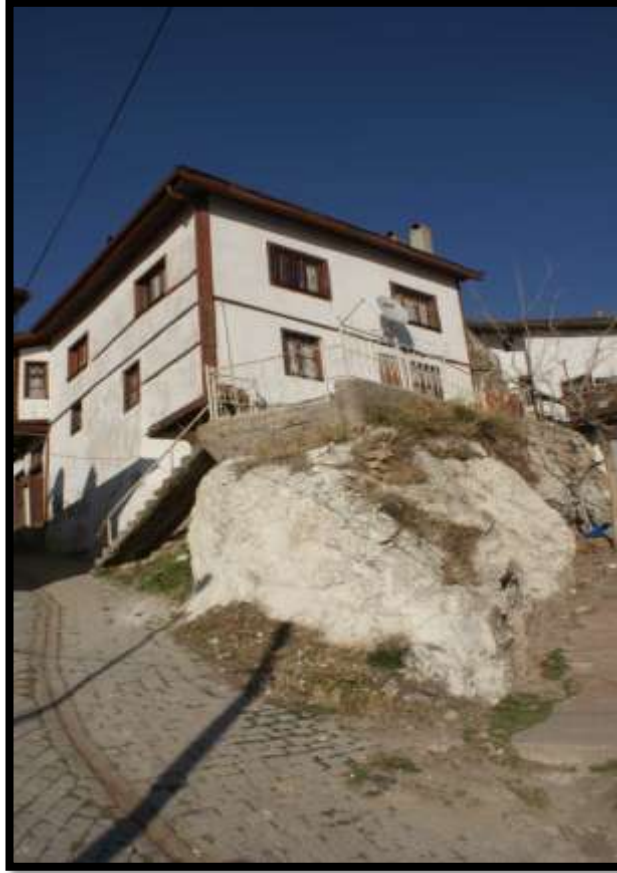
Şekil 5.23 Yapıda doğal kayalıktan faydalanılması (Orjinal 2013)
