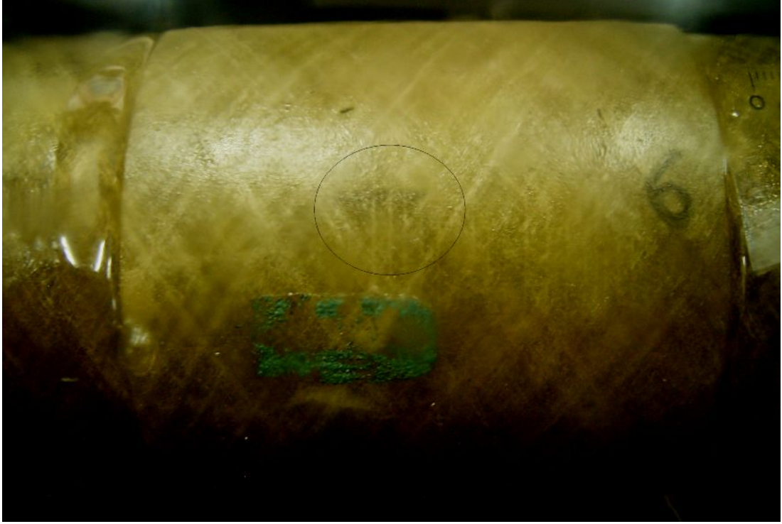
Şekil 6.6 Dıştan Kabuk Yama Yapılmış CTP Boru
