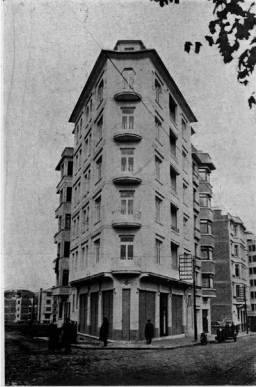
Şekil 81a. Pertev Apartmanı, Vedat Tek (Mimar, 1933-02, s.45)
