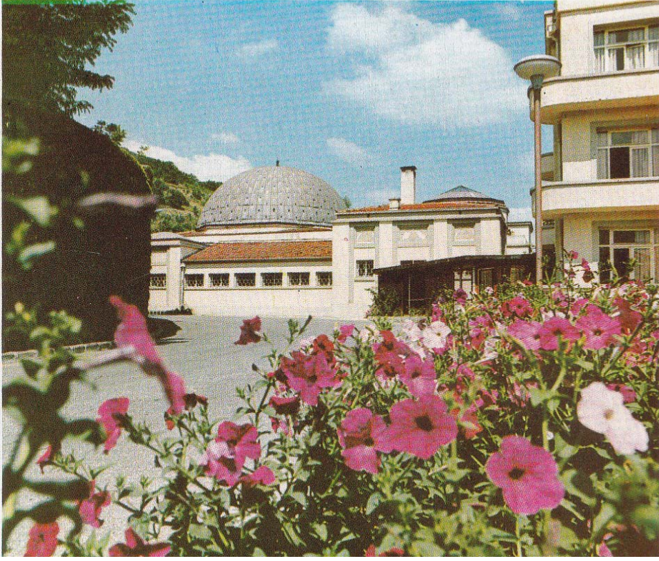
Şekil 166a. Kaplıca'yı otele bağlayan 1964 yılında inşa edilen koridor (Çelik Palas Oteli ve Kaplıcası broşürleri, Haluk Toy arşivi)
