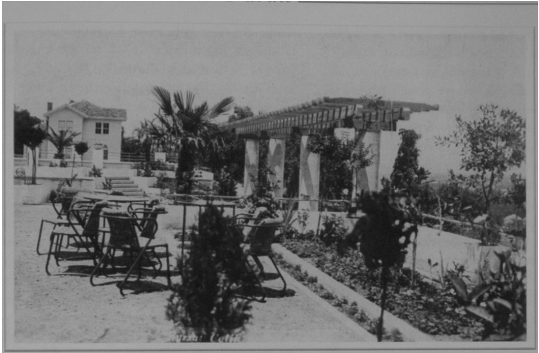
Şekil 132. Avluda farklı kotlarda yer alan teraslar (Çelik Palas., 2011, c.3, s.658-659)
