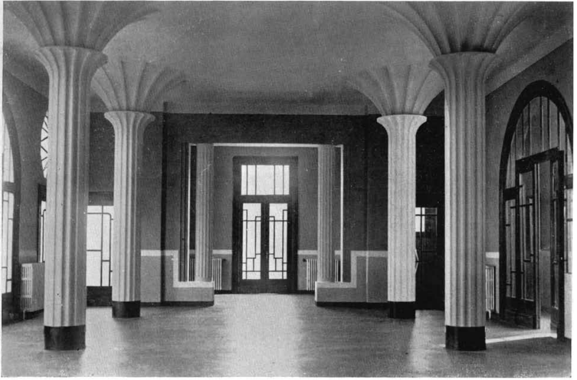
Şekil 136a. Çelik Palas Oteli, yemek salonu (Otel ve Kaplıca Binası, 1932-1, 13)
