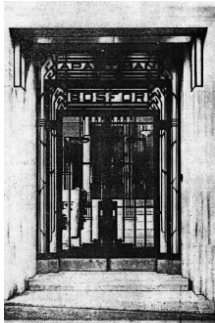
Şekil 79b. Bosfor Apartmanı, Mimar Macaroğlu Sami, Kapı detay (Mimar, 1932-10, s.280)
