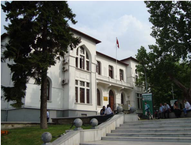
Şekil 97. Bursa Maliye Binası (20.09.2012)
