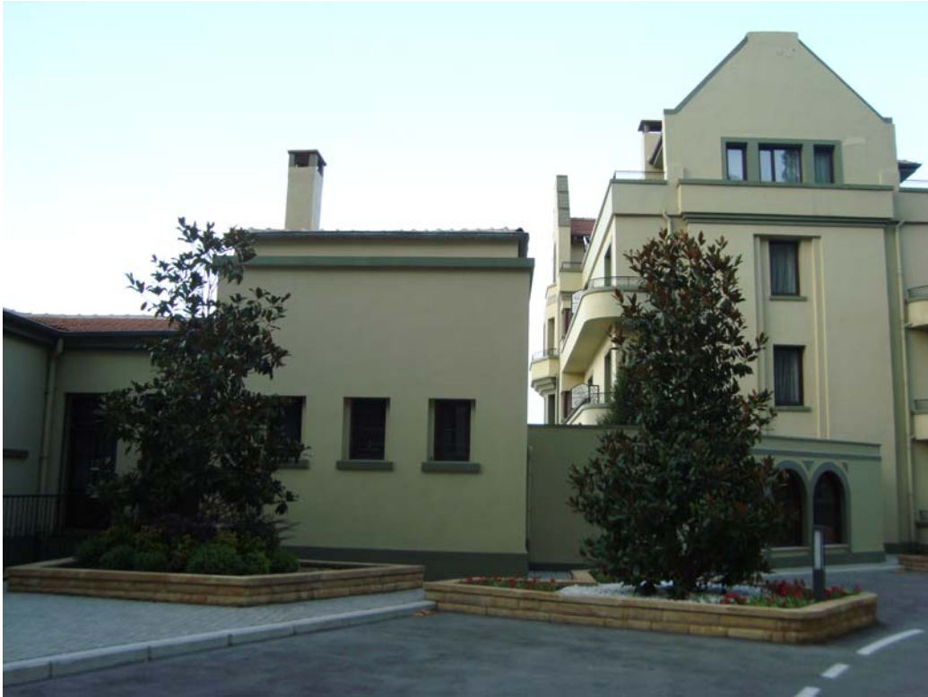
Şekil 141b. Çelik Palas Oteli, arka cephe (07.05.2013)
