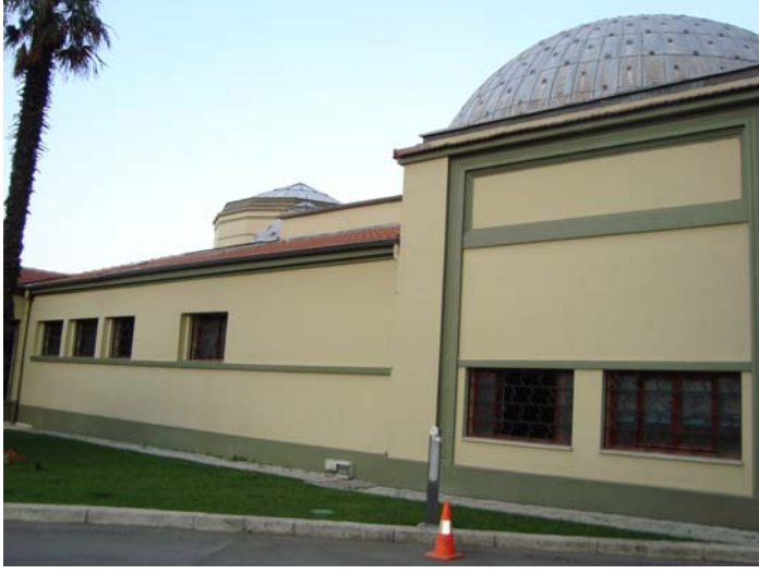
Şekil 152a. Çelik Palas Kaplıcası, yan cephe (07.05.2013)
