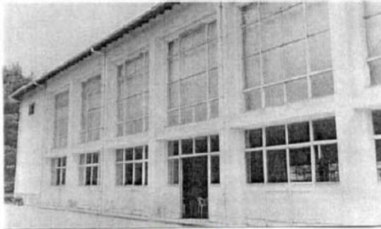
Yemekhane Binasının Dış Görünümü
