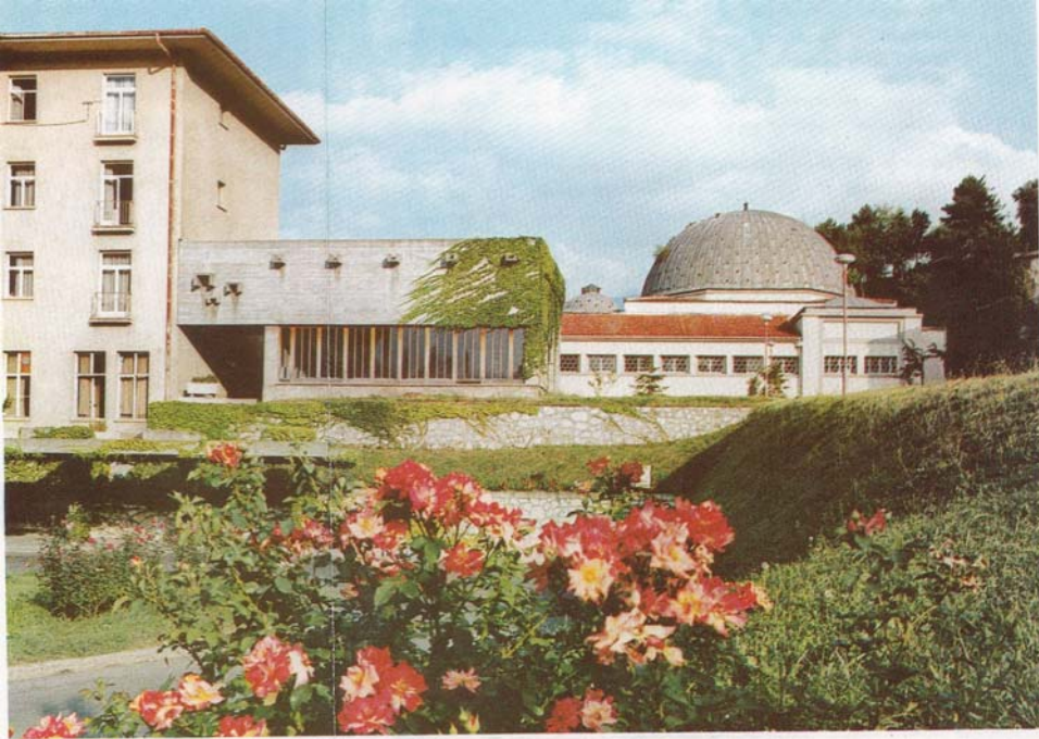
Şekil 166b. Kaplıca'yı yeni otel yapısına bağlayan 1964 yılında inşa edilen otele bağlayan koridor (Çelik Palas Oteli ve Kaplıcası broşürleri, Haluk Toy arşivi)
