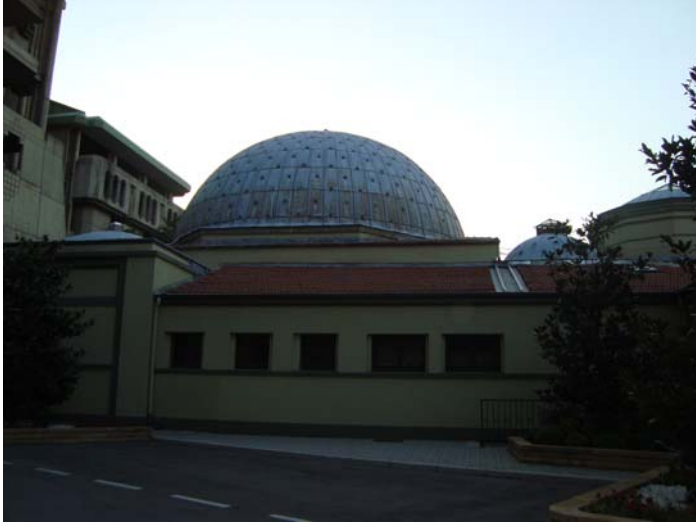
Şekil 152b. Çelik Palas Kaplıcası, yan cephe (07.05.2013)
