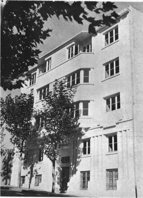
Şekil 82b. Halit Ziya Uşaklıgil Apartmanı, İstanbul, Vedat Tek (Mimar, 1934, s.227)
