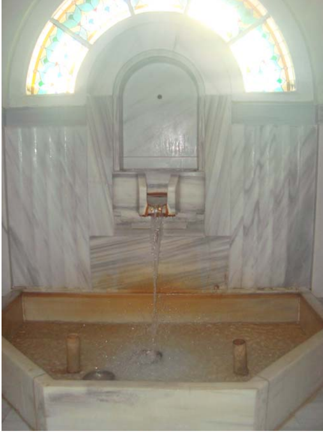
Şekil 148a. Çelik Palas Kaplıcası, aslanagzı (25.07.2013)
