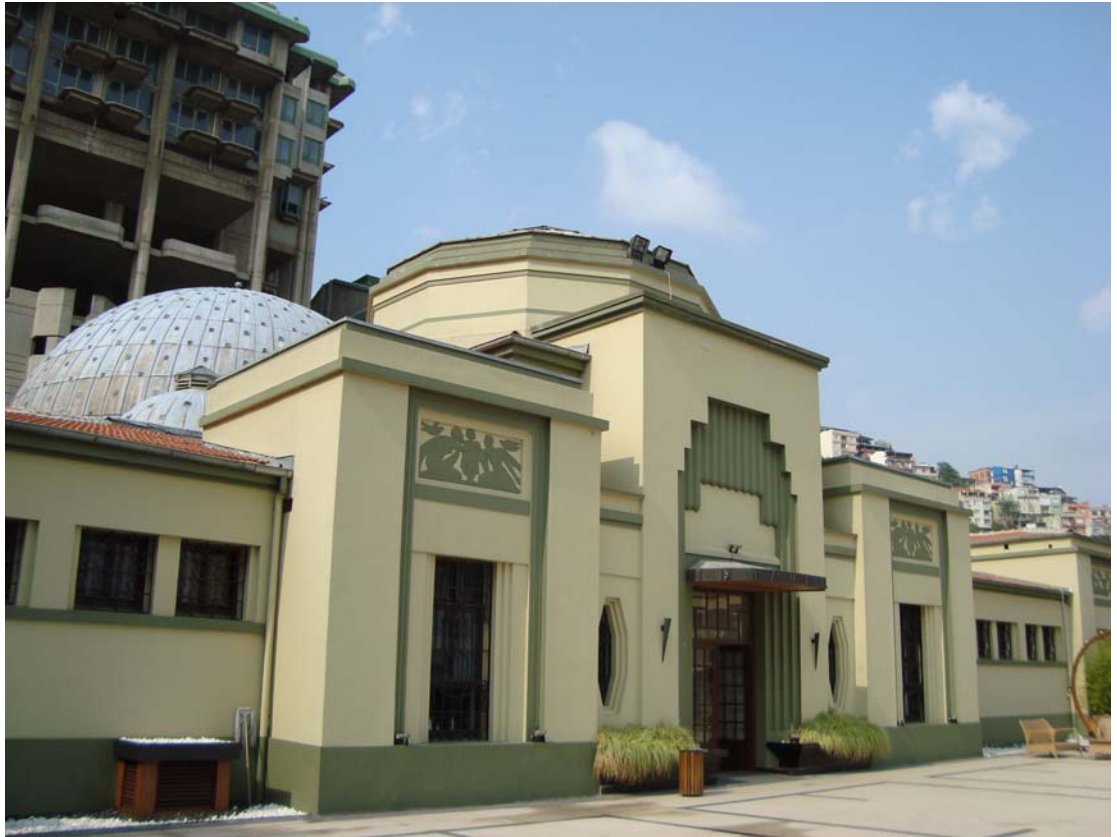
Şekil 149b. Çelik Palas Kaplıcası, giriş cephesi (07.05.2013)
