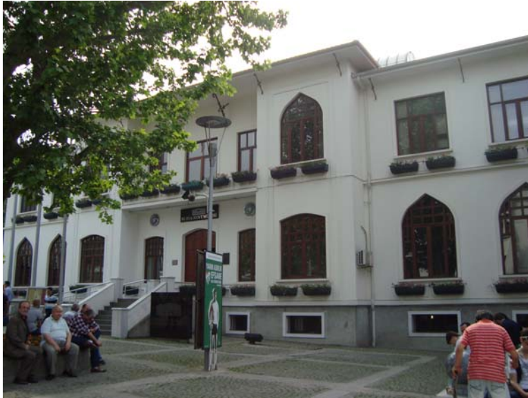
Şekil 96. Bursa Adliye Binası (08.05.2013)
