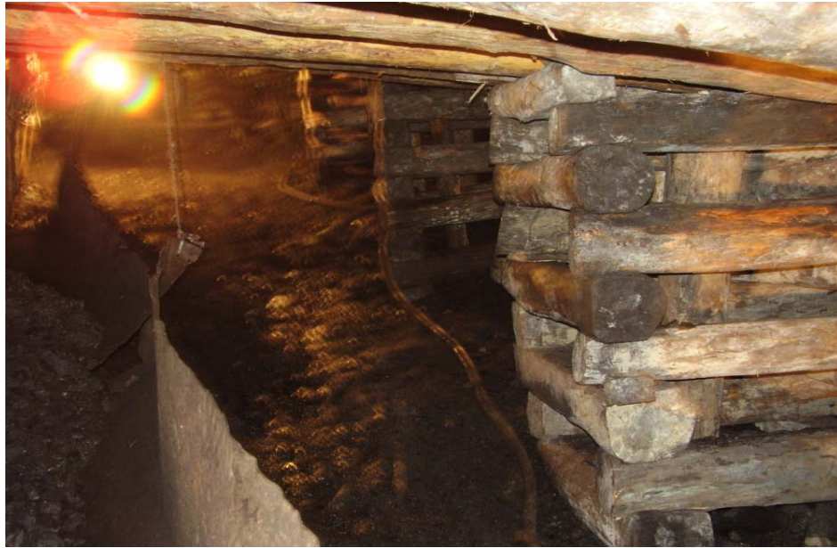
Resim 2.3. Armutlu kömür işletmesi domuz damı görüntüsü (Temmuz, 2006).
