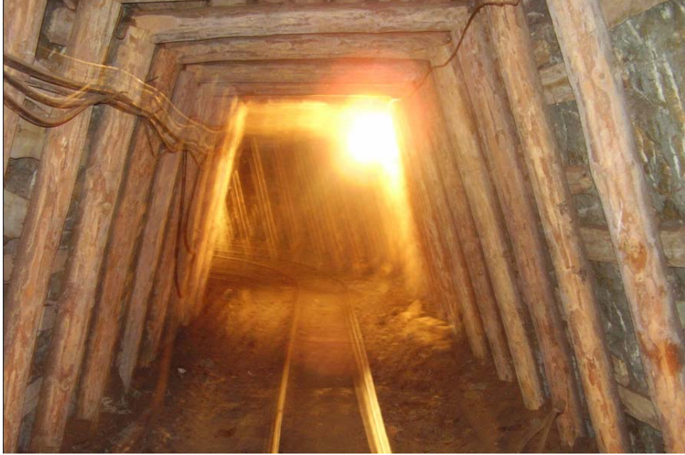
Resim 2.2. Armutlu kömür işletmesi anayolda bağ tahkimatı görüntüsü (Temmuz, 2006).
