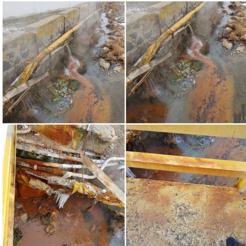
Şekil 33. Pasinler Termal’de tespit edilen durabilite sorunlarına ait görsel
