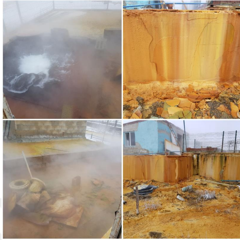
Şekil 34. Nene Hatun Termal’de tespit edilen durabilite sorunlarına ait görsel - 1
