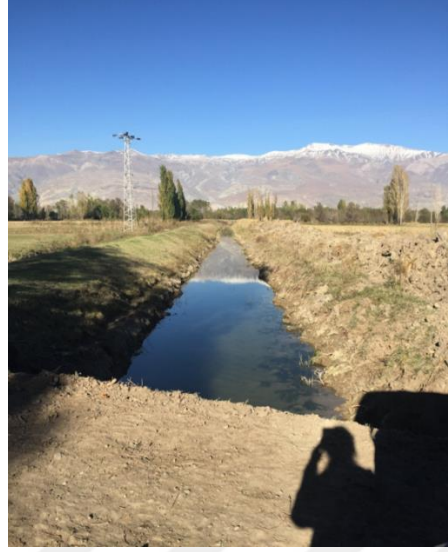
Şekil 4.5. Açık drenaj kanalı üzerine yapılmış büzlü geçit sol sahil sulaması (Yamaçlı köyü) (Özgün)
