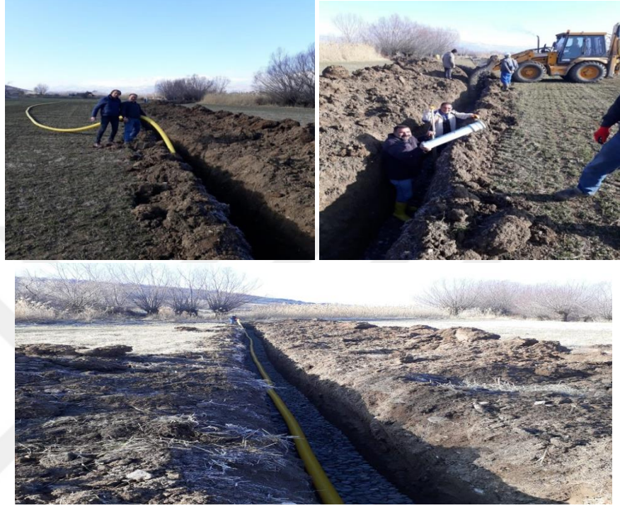
Şekil 4.4. Altınbaşak ada sulamasının (Güllüce köyü) tarla içi drenaj sistemi (Özgün)
