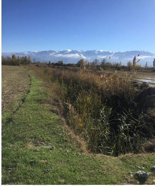
Şekil 4.10. Otlarla tıkanmış sulama kanalı (Molla köy) (Özgün)
