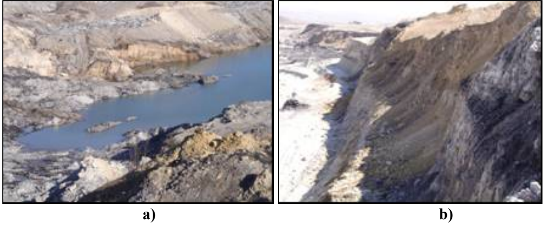
Şekil 5.12. a) GLI-Ilgın linyit ocağı tabanında biriken yeraltı suyu, b) ölçüm yapılan heyelanlı şevleri ocak tabanına bağlayan en alt şev basamağı.
