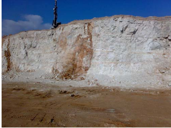
Şekil 5.41. Konya Çimento Fabrikası Kireçtaşı Ocağının Doğusunda bulunan basamakta patlatma deliği hazırlıkları.
