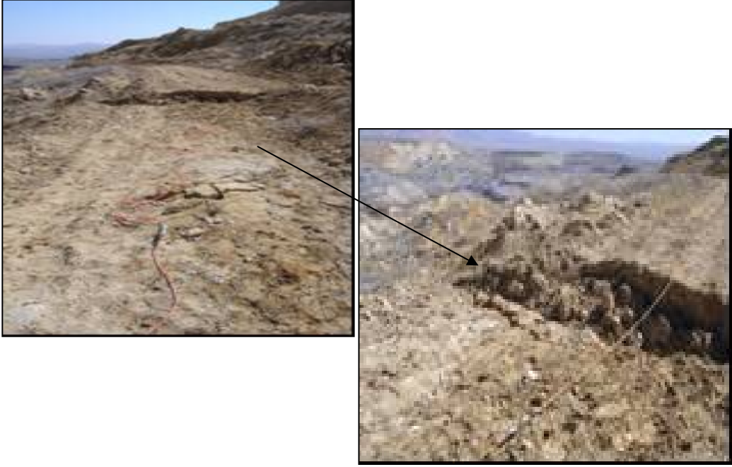
Şekil 5.16. Heyelan olan maden bölgesinde bulunan maden yolundaki 20-40 cm'lik kayma.
