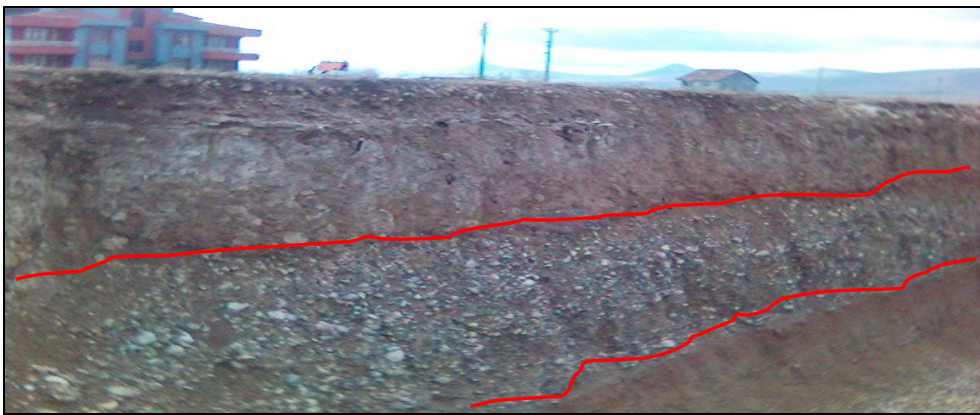
Şekil 4.15. Konya-Binkonutlar semtinde üzerinde ölçüm yapılan inşaat temelinin kazılmış hali, kazı derinliği 5m dir.
