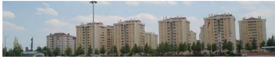
Resim 4.13, 4.14, 4.15-. Yeni Gelişmekte olan Yeni Otogar aksı-İstanbul Yolu'nun batı bölümü.
