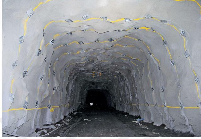
Şekil 1.1. Kaya saplaması uygulaması (Anonim 2018a)
