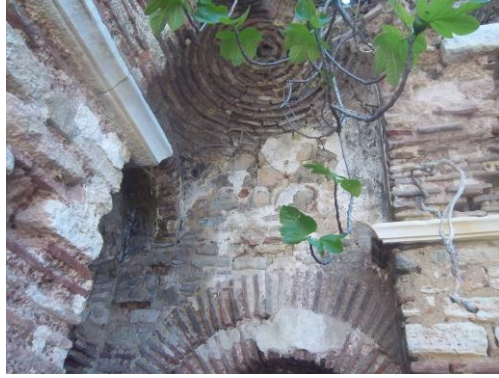
Resim 32. Kuzeydoğu Köşe Odası Örtüsü (Yinsel, 2015).
