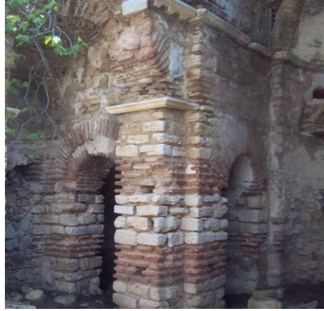
Resim 137. Pelekete Manastırı Kilisesi, Kuzeydoğu Duvar, Almaşık Teknik (Yinsel, 2015).
