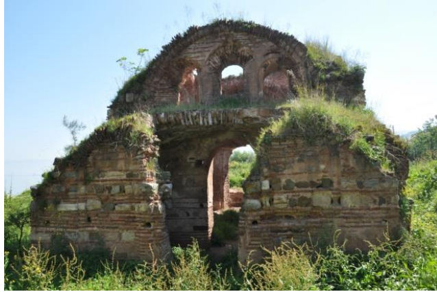
Resim 139. Aziz Aberkios Manastırı Kilisesi, Batı Cephe, Almaşık Teknik (Fenerci, 2013).
