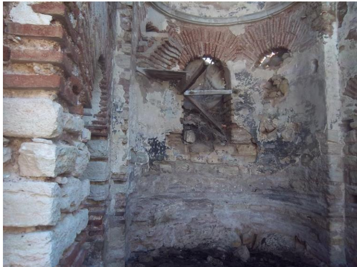
Resim 64. Apsis Pencere Kemerleri, Çift Sıra Tuğla Teknik (Yinsel, 2015).
