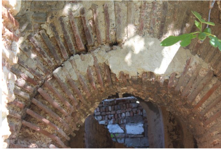
Resim 63. Prothesis Kapı Kemerleri, Çift Sıra Tuğla Teknik (Yinsel, 2016).
