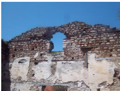
Resim 58. Batı Duvar, Ahşap Hatıllar (Yinsel, 2015).
