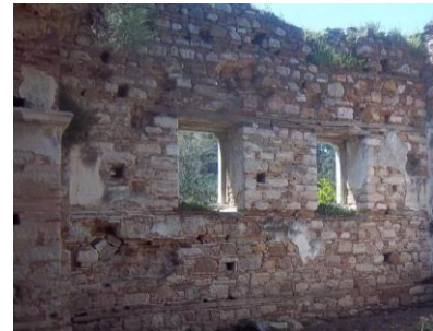
Resim 59. Güney Duvar, Ahşap Hatıllar (Yinsel, 2015).
