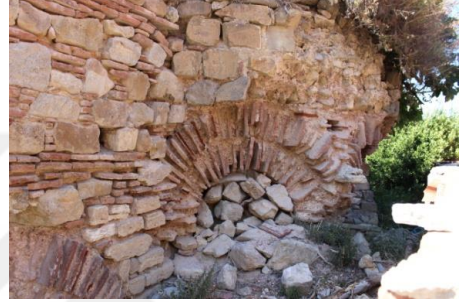
Resim 123. Pelekete Manastırı Kilisesi, Doğu Cephe, Kemerler (Yinsel, 2016).
