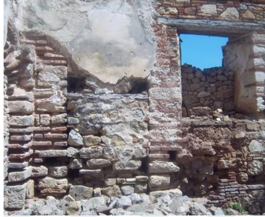
Resim 61. Kuzeybatı Köşedeki Kemer, Almaşık Teknik (Yinsel, 2015).
