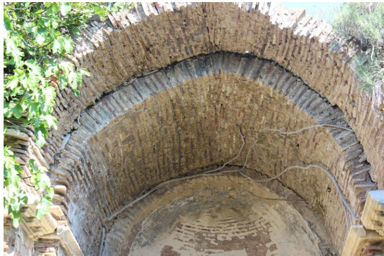
Resim 41. Bema ve Doğu Haç Kolu Beşik Tonozu (Yinsel, 2016).
