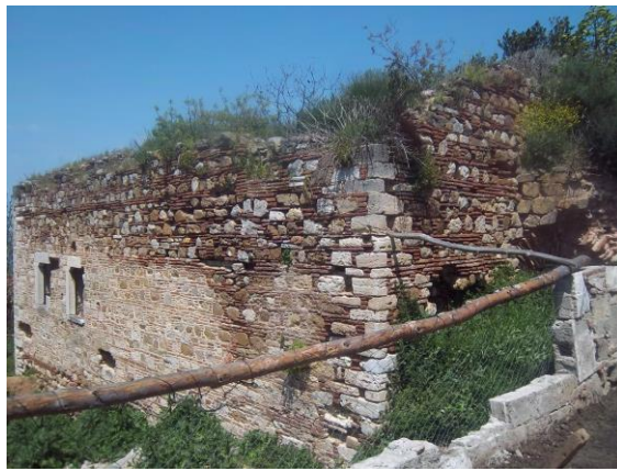
Resim 62. Güney Cephe, Taş ve Tuğla Malzeme (Yinsel, 2015).
