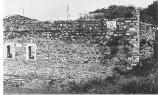
Resim 50. Güneydoğu Cephe (Mango ve Ševčenko, 1973).
