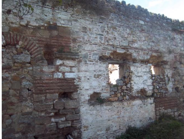
Resim 52. Kuzey Cephe, Kör Kemer ve Pencere (Yinsel, 2016).
