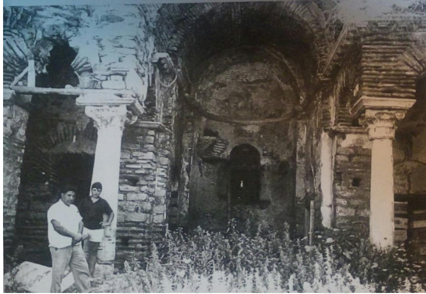
Resim 172. Pelekete Manastırı Kilisesi, Destek Sistemi
