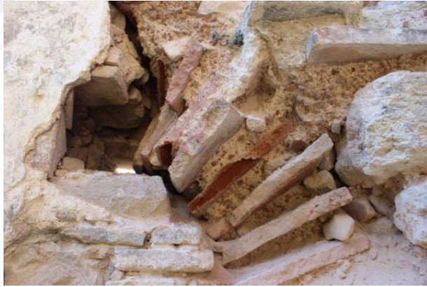
Resim 135. Pelekete Manastırı Kilisesi, Kuzeybatıdaki Kemer, Tuğla Malzeme (Yinsel, 2016).
