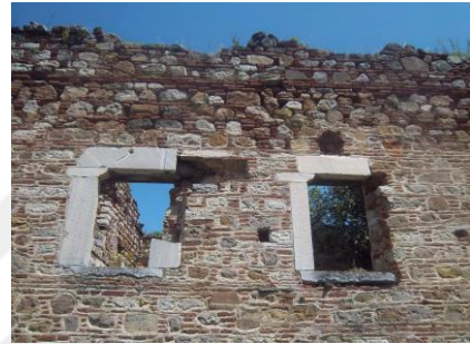
Resim 57. Güney Cephe, Mermer Lento ve Söve (Yinsel, 2015).
