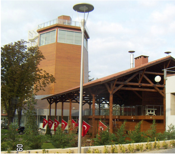
Şekil 8.5.5. Kafeterya ve restavuranta dönüştürülen soğutma kulesi ve salaş ambarları (Orijinal 2010).
