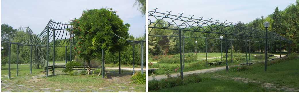
Şekil 7.7.11. Gül bahçesi içinde bulunan üst örtü elemanları (Orijinal 2010).
