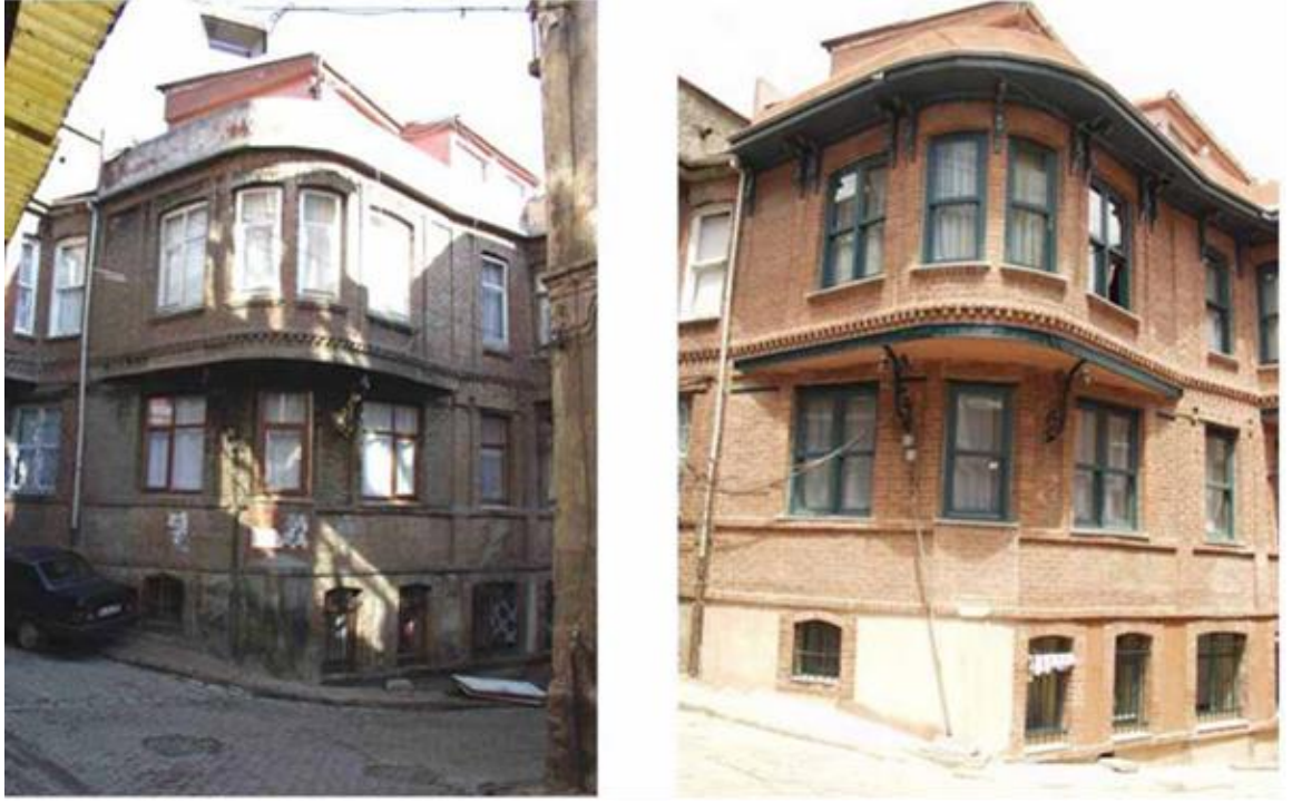
Şekil 4.3 Bina restorasyonu (Anonim 2008a)
