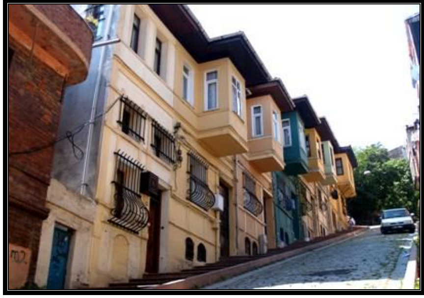
Şekil 4.1 Cephe restorasyonu (Anonim 2006b)
