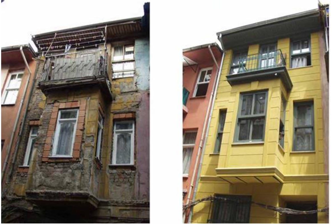
Şekil 4.2 Cephe restorasyonu (Anonim 2008a)
