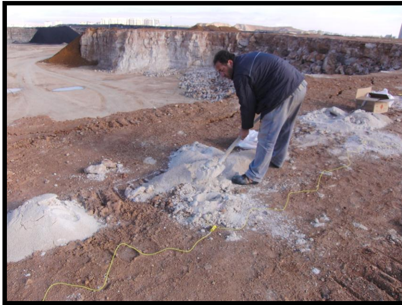
Şekil 7.12. Deliklerin sıkılama işlemleri
