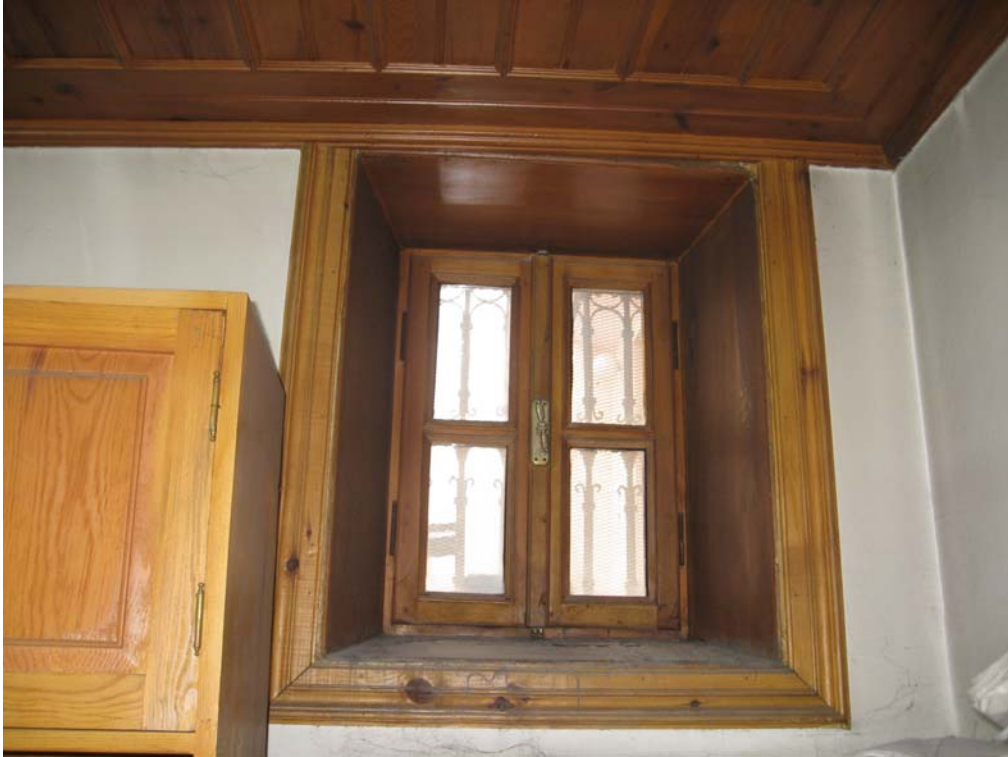
Resim 94- Bodrumda Çeşitli Cephelerde Yer Alan Mazgal Pencere
