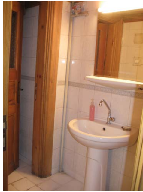
Resim 81- Ara Sahanlıkta Yer Alan Lavabo Mekanı
