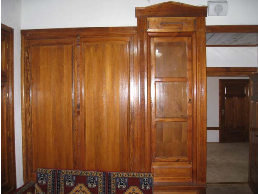
Resim 64- 1. Kattaki Sofaya Bağlı Doğuda Yer Alan Odanın Yenilenen Ahşap Dolapları
