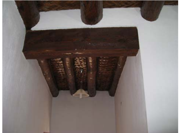
Resim 68- Mutfak Tavanı Ahşap Kirişleri
