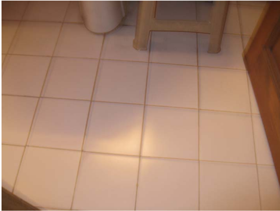
Resim 109- Lavabo Mekanı Döşeme Kaplaması
