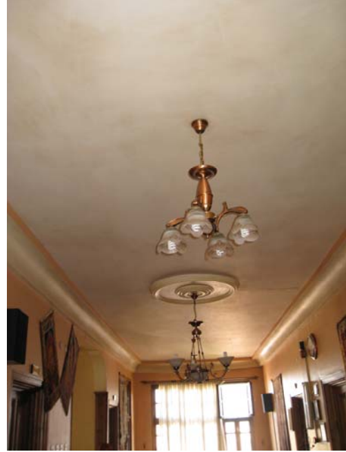
Resim 40- Tavanda Sıva Uygulaması
