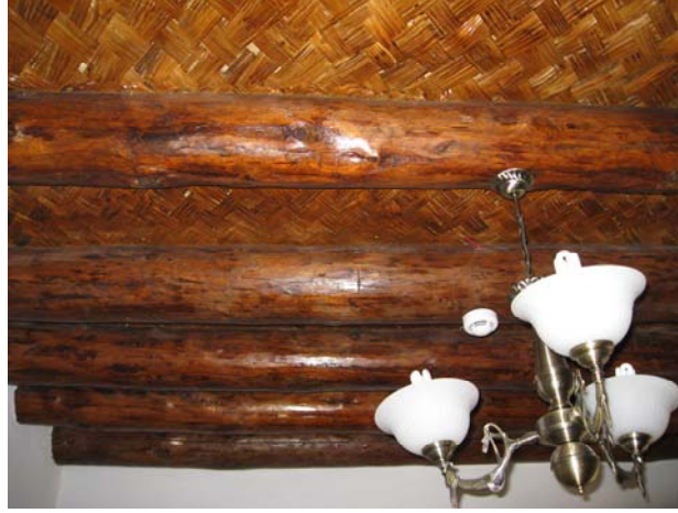
Resim 66- Zemin Kat Sofaya Bağlı Odaların Tavan Ahşap Kirişlemeleri
