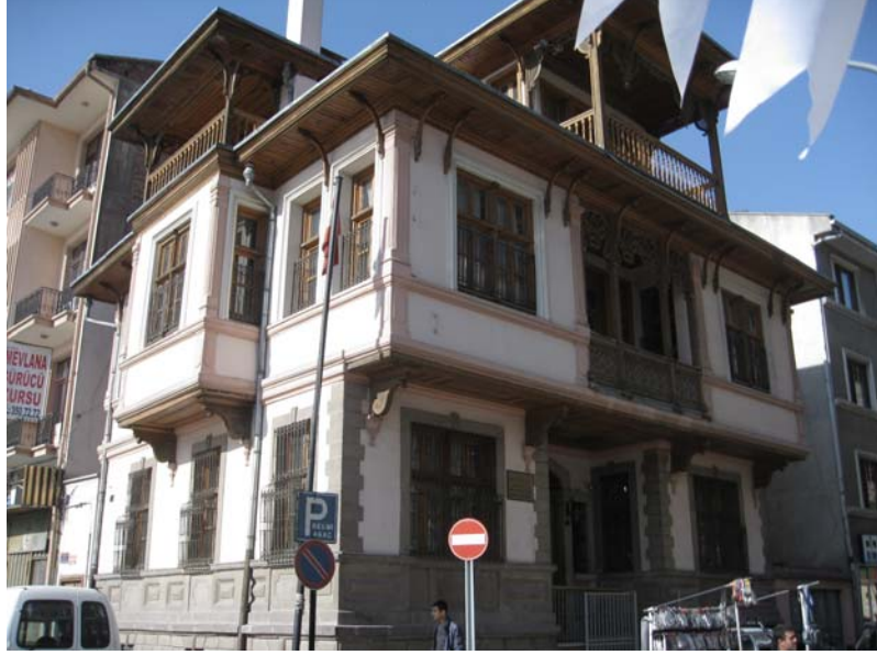
Resim 95- Giriş Cephesi Duvarları
