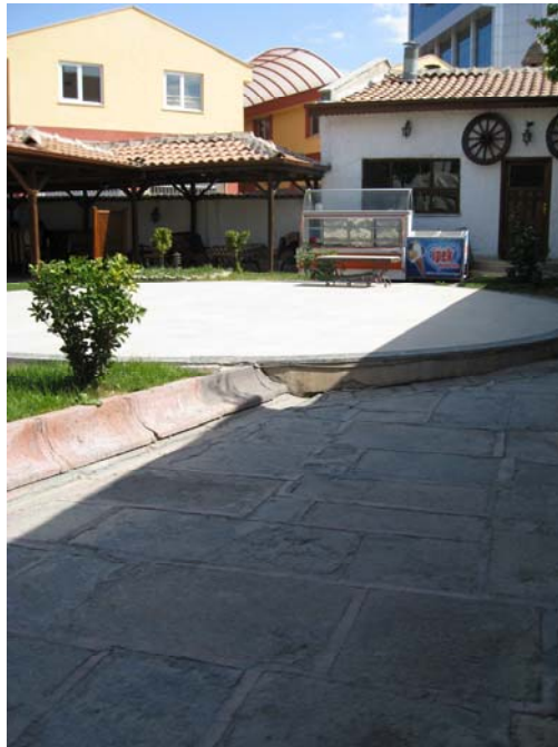
Resim 49- Gösteri Alanı Traverten Kaplama
