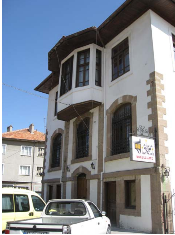
Resim 35- Giriş Cephesi Duvarları
