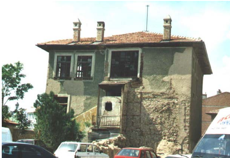
Resim 36- Restorasyon Öncesi Dış Cephe Duvarları (Kültür İnş. Arşivi)
