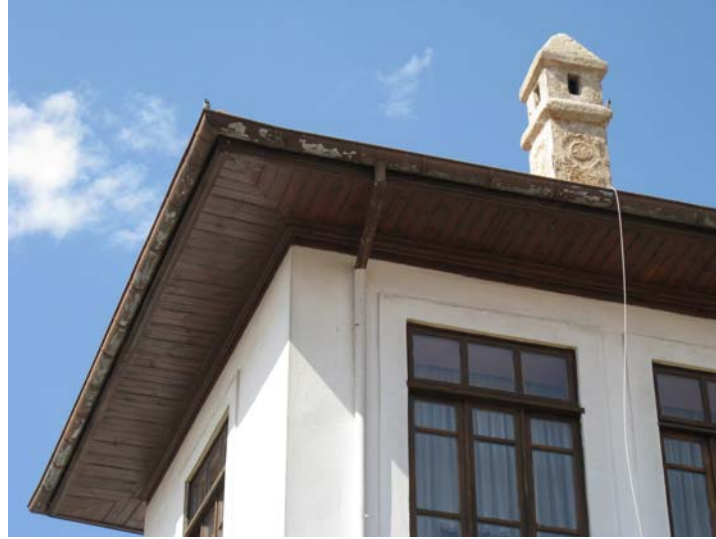
Resim 37- Ahşap Kaplama Saçaklar
