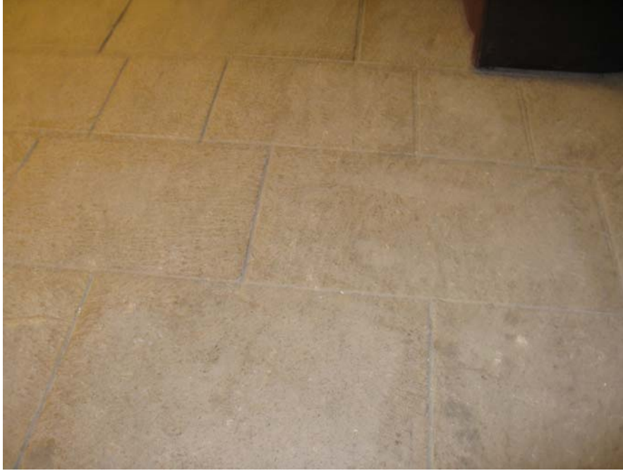
Resim 151- Mimar Evi Döşeme Kaplaması
