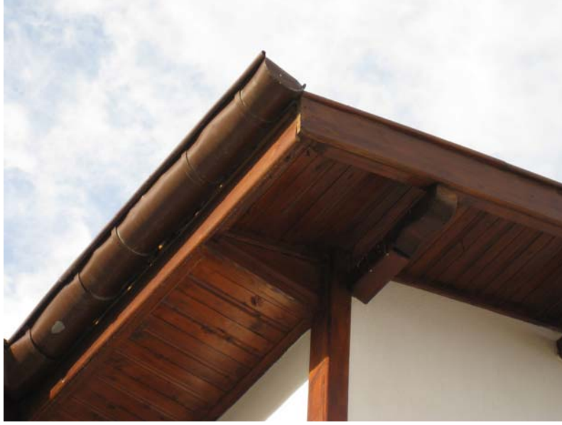
Resim 69- Ahşap Kaplama Saaklar
