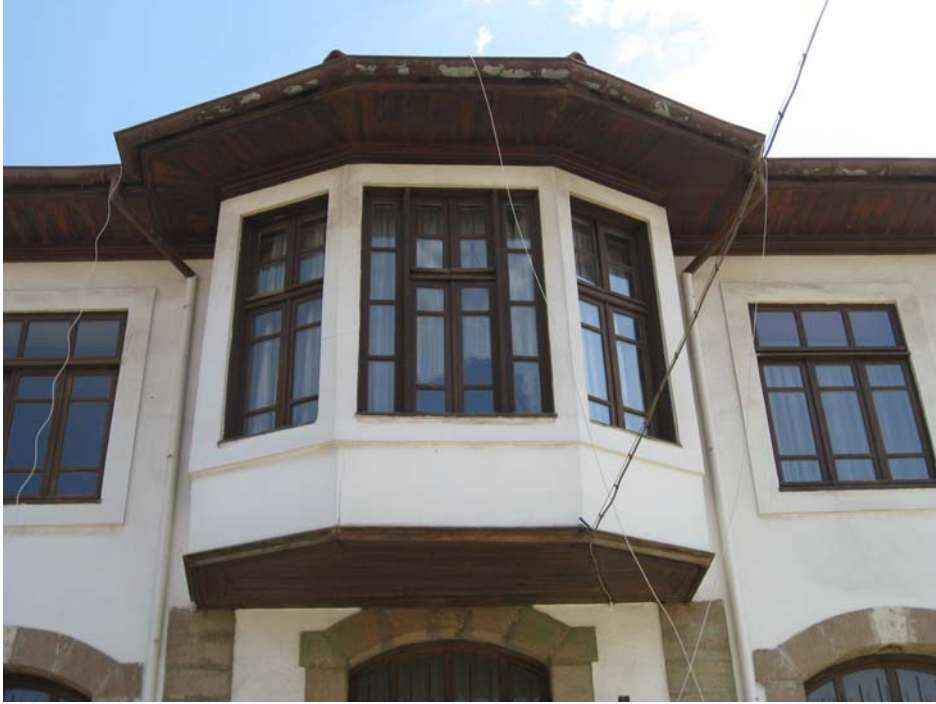
Resim 26- Beşgen Çıkmanın Dış Cepheden Görünüşü
