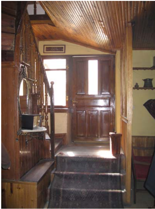
Resim 14- Giriş Holüne Bağlı Merdiven
