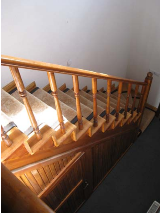
Resim 56-1. Kat Sofaya Ulaşan Merdiven
