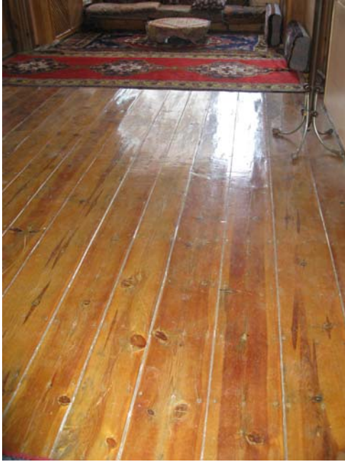
Resim 39- 2. Kat Sofa Ahşap Döşeme Kaplaması
