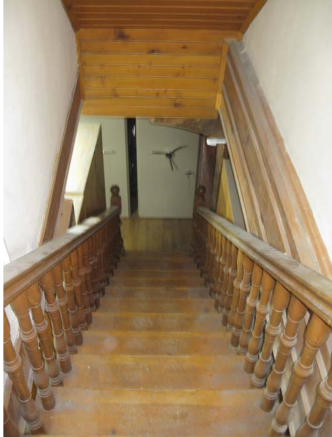
Resim 92- Bodrum Kata İniş Sağlayan Merdiven
