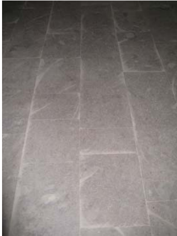
Resim 67- Mutfak Döşeme Kaplaması
