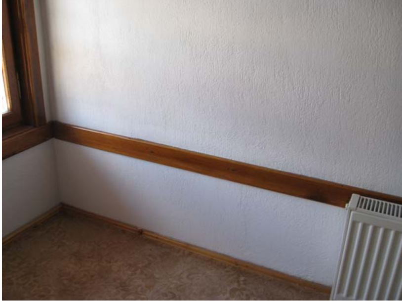
Resim 63- Ahşap Duvar Bantları
