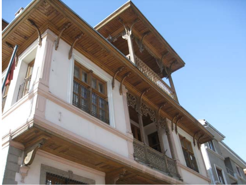
Resim 97- Çıkma Altında, Saçaklarda ve Balkonda Kullanılan Ahşap Malzeme
