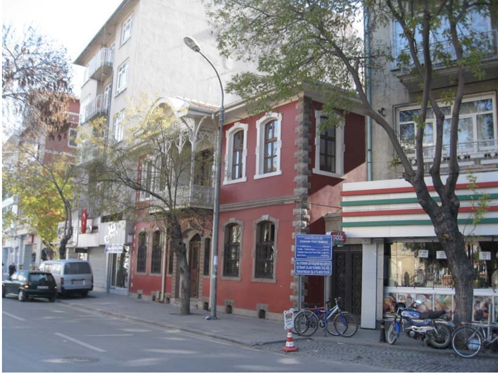
Resim 140- Giriş Cephesi Duvarları
