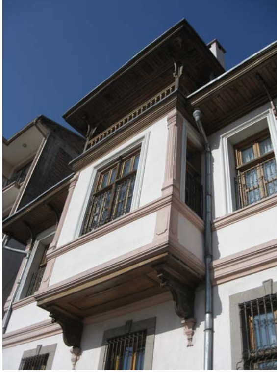
Resim 96- Çıkma Altında Kullanılan Ahşap Malzeme
