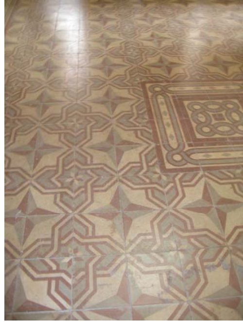
Resim 101- Giriş Holü Zemin Kaplaması
