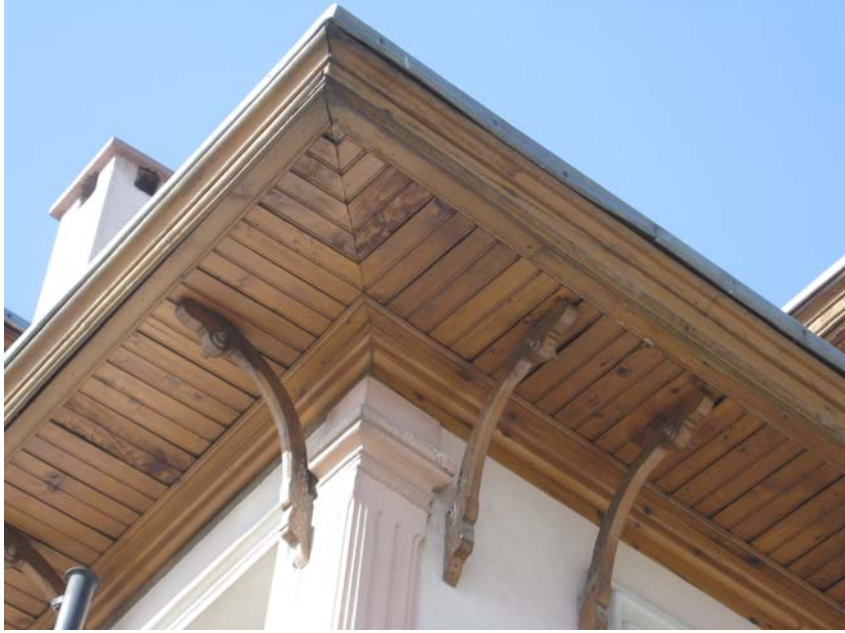
Resim 99- Saçak Altı Ahşap Kaplama
