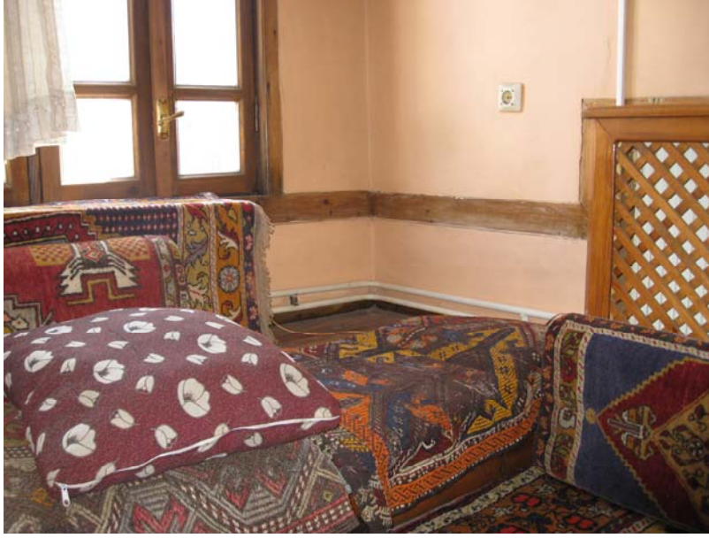
Resim 31- Ahşap Duvar Bantları
