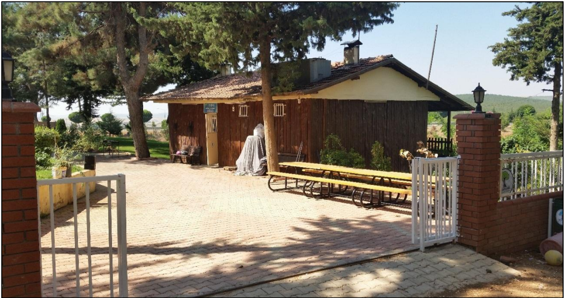
Şekil 4.23 İdare binası (Orjinal 2014)
