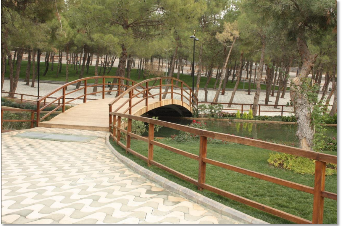
Şekil 4.29 Suni dere üzerindeki ahşap köprü (Orjinal 2014)
