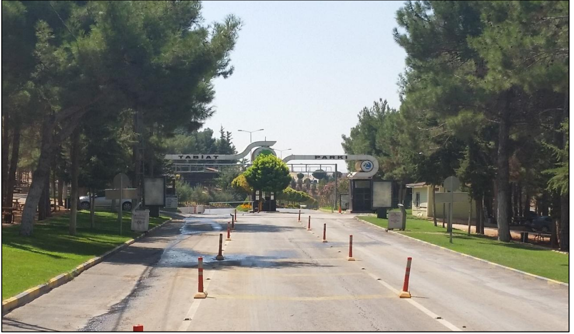
Şekil 4.22 Giriş kontrol binası (Orjinal 2014)
