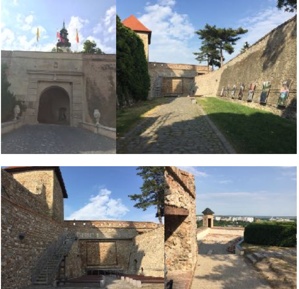
Uyvar'dan yaklaşık 40 dakikada ulaştığımız kuzey noktası: Nitra Kalesi.
